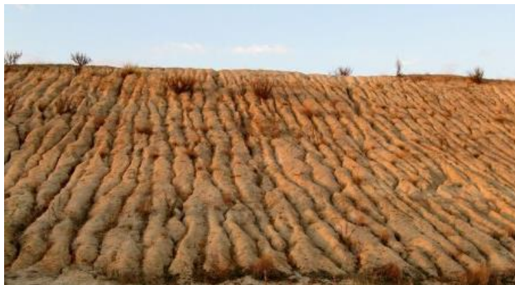
Figura 7 Erosión de Taludes
