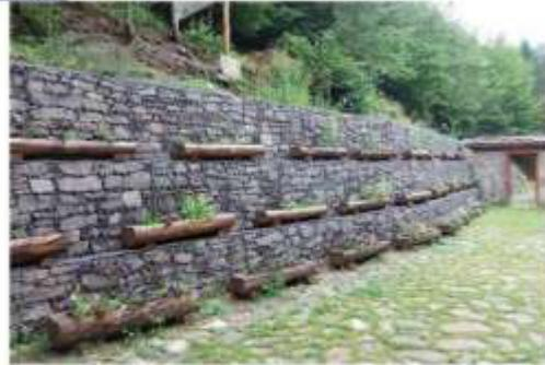
Figura 1. Estructura con gaviones. Fuente: <http://www.solucionesespeciales.net/MedioAmbiente/Gaviones/Gaviones.aspx>
