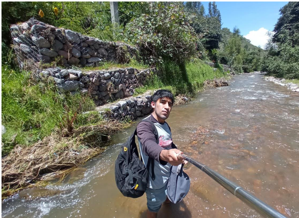
Imagen 2: Vista amplia en la que se observa la presencia de vegetación en los niveles superiores del muro.
