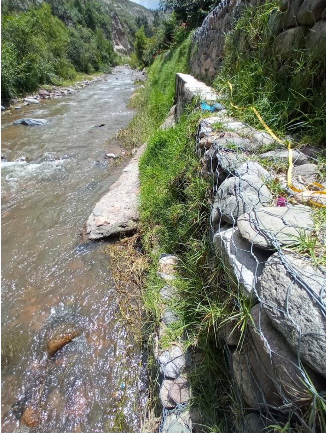
Imagen 3: se observa la presencia de una base de concreto ciclópeo a modo de espigón en progresiva 00+040 a 00+050
