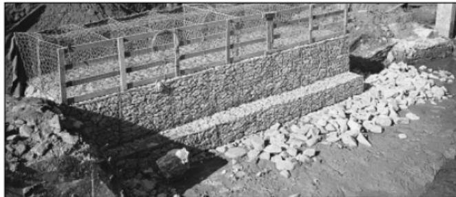
Figura 2.4.2 - Detalle constructivo de obra con gaviones caja
