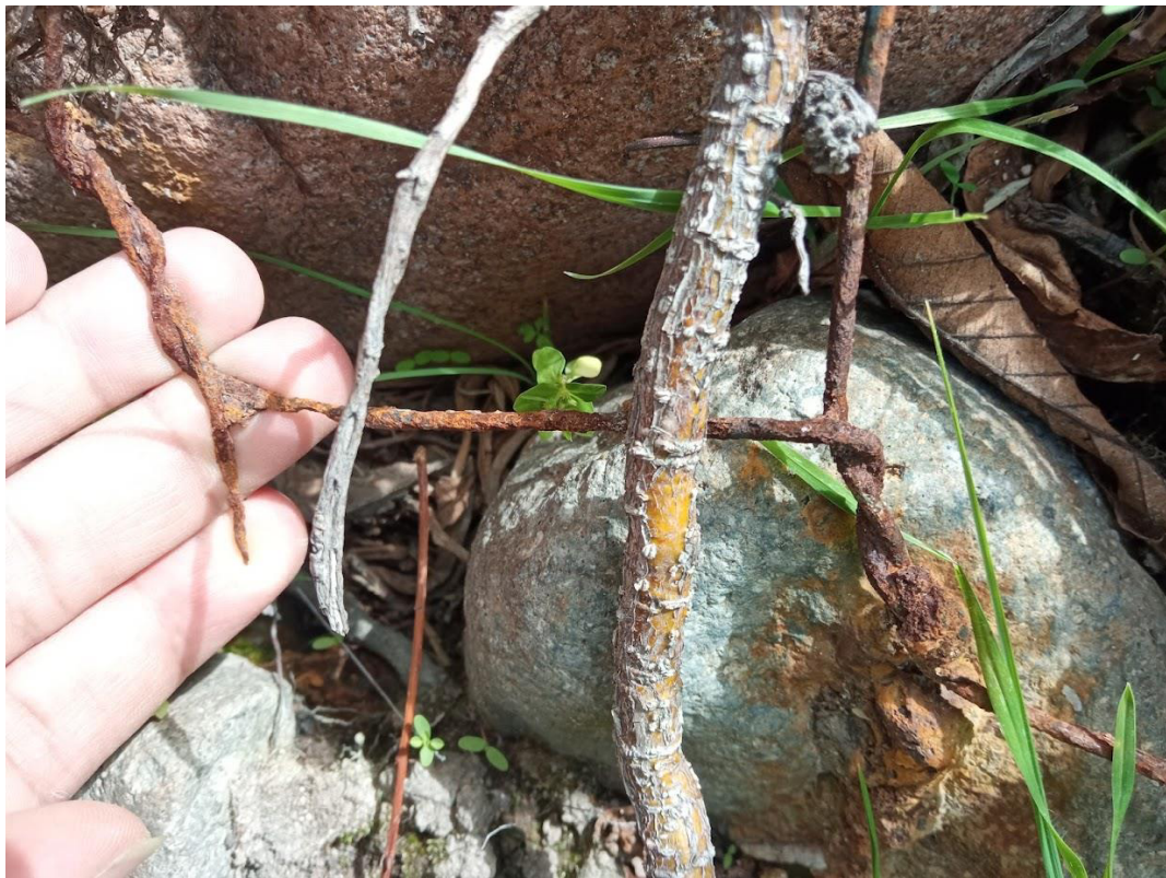
Imagen 29: Se observa rotura en las mallas producto del avanzado grado de oxidación
