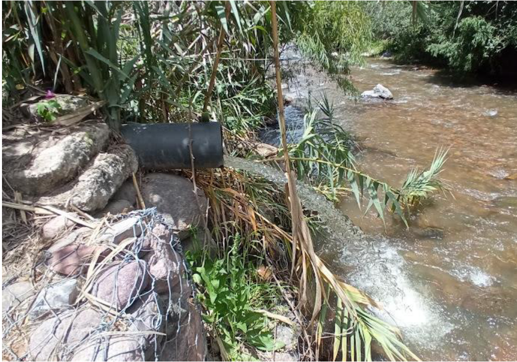
Imagen 4: Salida del desfogue de aguas de riego del Vivero Municipal entre las progresivas 00+050 y 00+060
