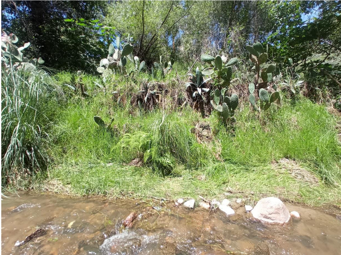
Imagen 15: Se observa que el muro es casi imperceptible a simple vista entre las progresivas 00+080 a 00+100
