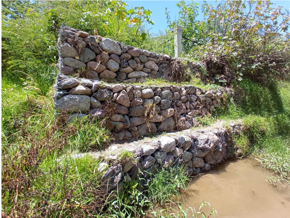
Imagen 1: Vista de los tres niveles de gaviones que conforman el muro.
