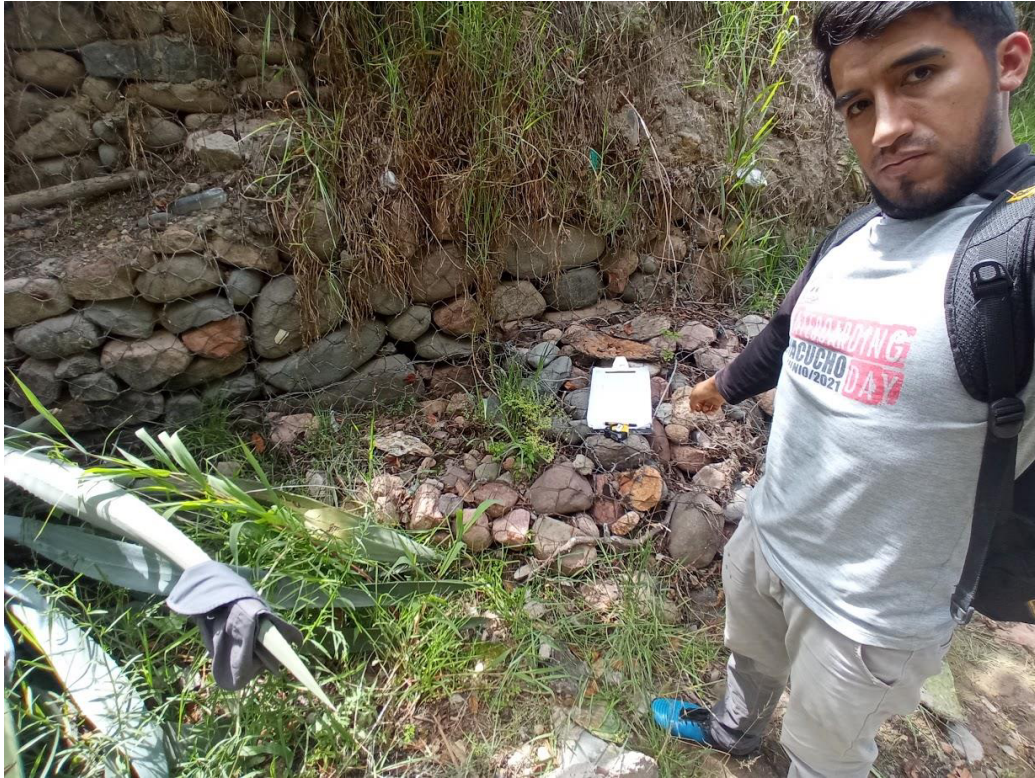
Imagen 8: Mi persona realizando la evaluación de los gaviones. Progresiva 00+070 a 00+080
