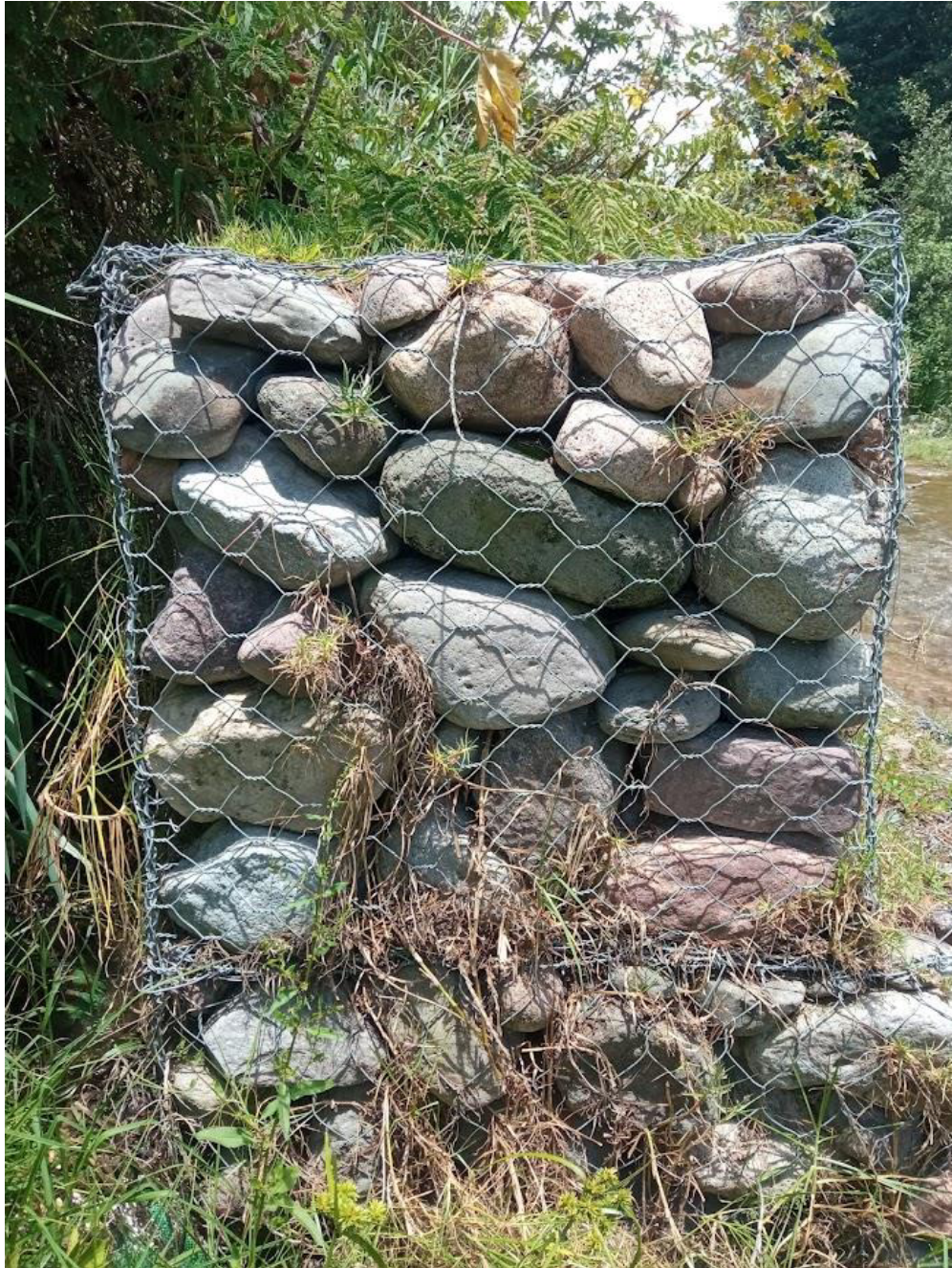
Imagen 18: Se observa la falta de uniformidad en el tamaño del relleno
