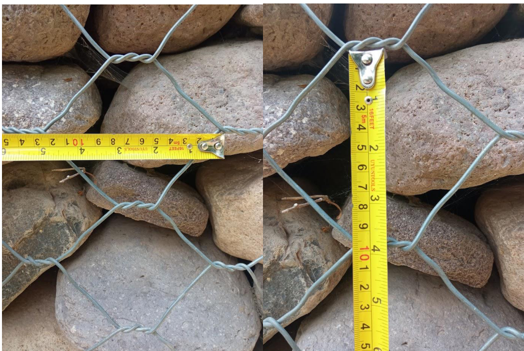
Imagen 20: Toma de medidas de las dimensiones de las mallas hexagonales
