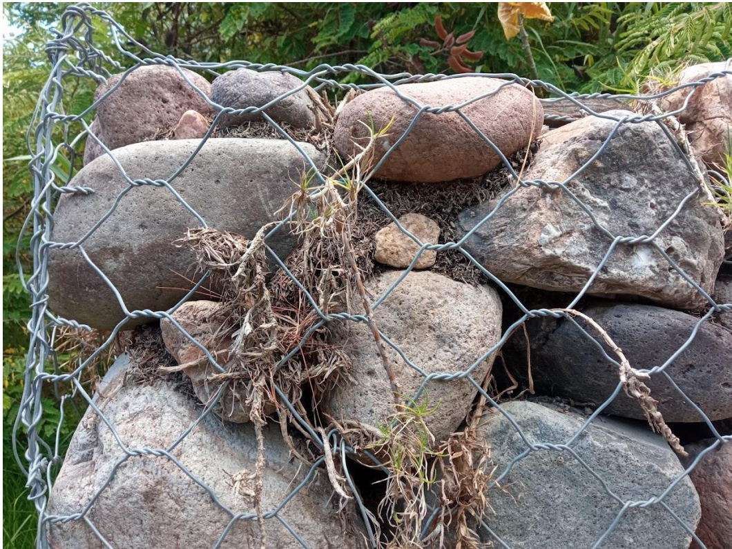
Imagen 19: Se visualiza la presencia de piedras demasiado pequeñas generando espacios vacíos
