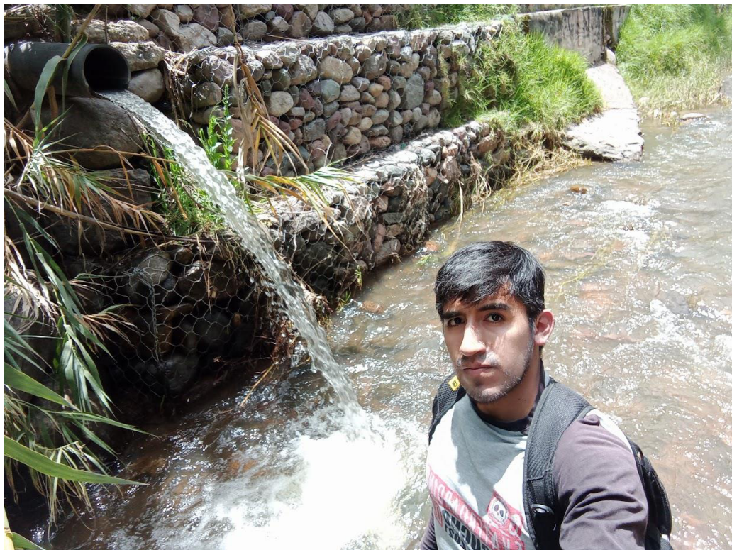
Imagen 5: Mi persona realizando la evaluación entre las progresivas 00+050 y 00+060
