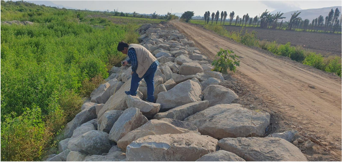
Figura 14: Tomando la altura de la defensa ribereña
