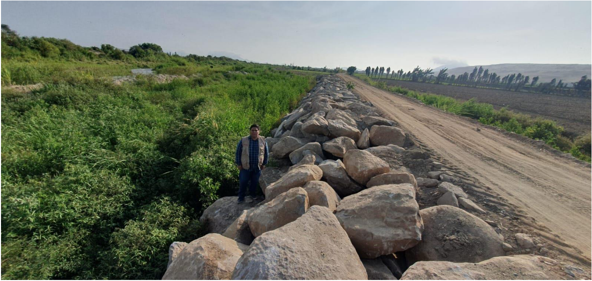
Figura 12: Vista panorámica de la defensa ribereña tipo enrocado en el AA.HH. 23 de Octubre
