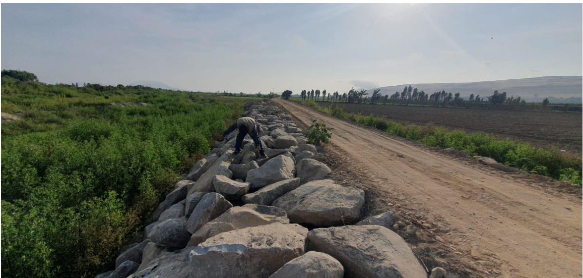
Figura 13: Midiendo la corona del enrocado fue de 1.5 metro de ancho
