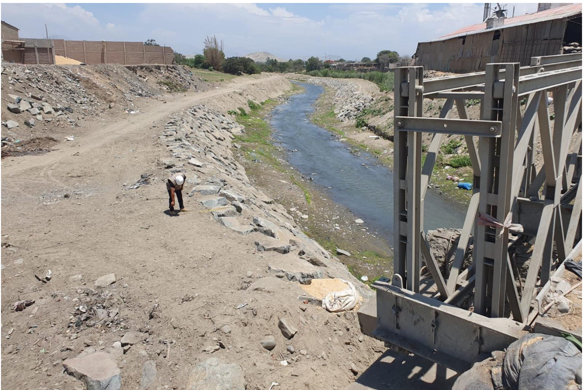
Figura 14: Tomando la medida de la corona del enrocado
