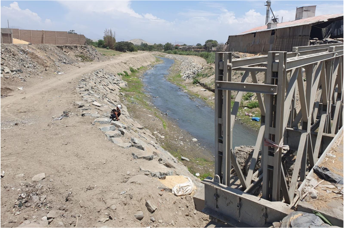
Figura 13: Tomando pendiente del enrocado (2.5 metros)
