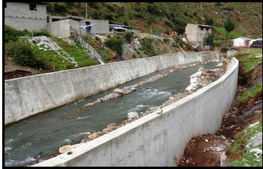
Figura 9: Muro de concreto
