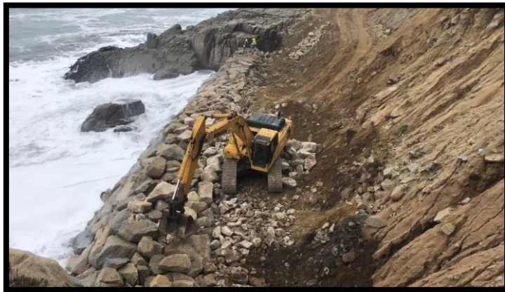
Figura 10: Enrocado para protección
