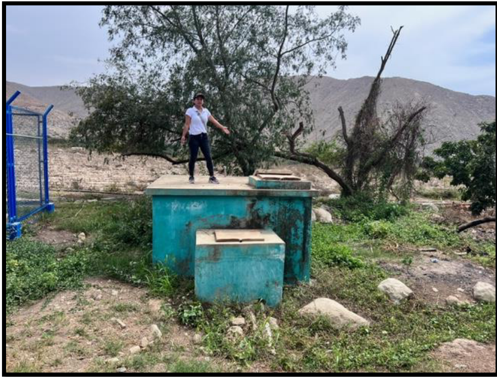
Figura 03: Reservorio Antiguo (Sin uso).
