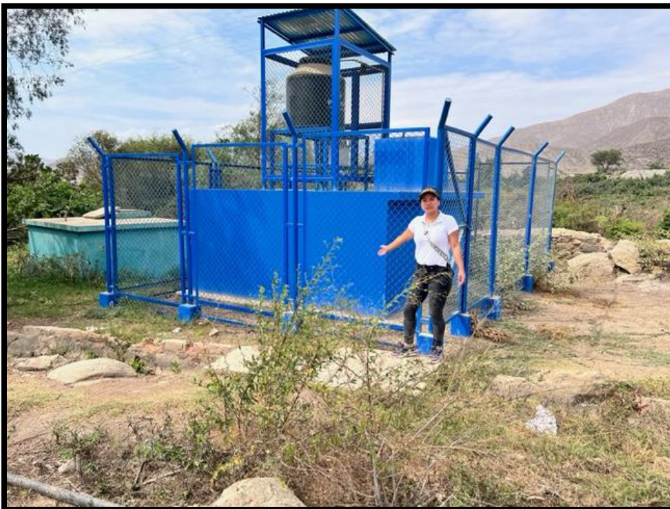
Figura 02: Reservorio Actual, recientemente Construido.
