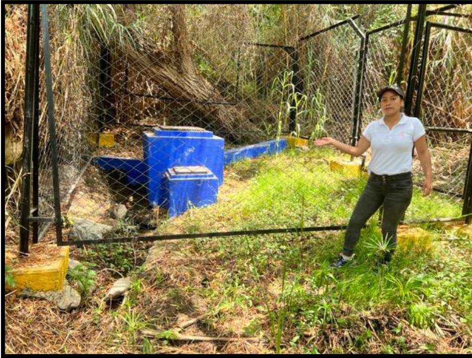
Figura 01: Captación, La fuente es subterránea y el tipo de captación es manantial de ladera
