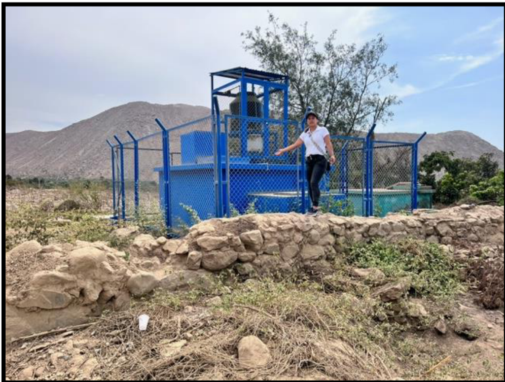
Figura 04: Cerco perimétrico del Reservorio.
