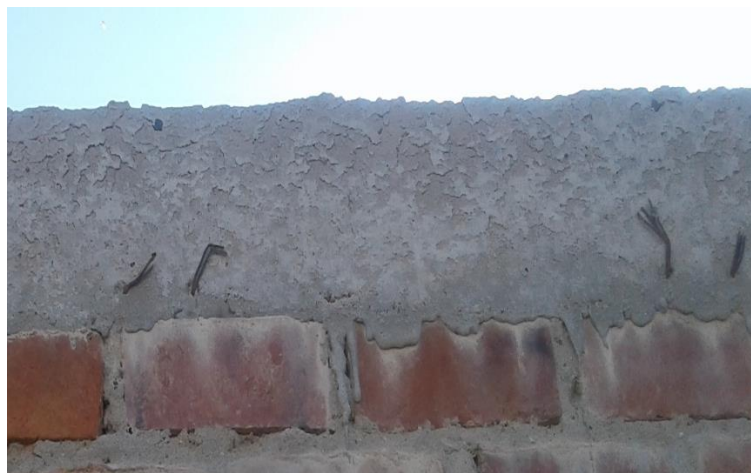
Figura 7 Fisuramiento
