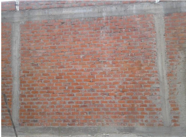
Figura 4 Muro Portante de Albañilería
