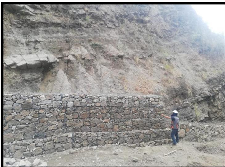
Imagen 03: Verificación de altura de gaviones para mejorar Defensa Ribereña Del Rio Chacapata
