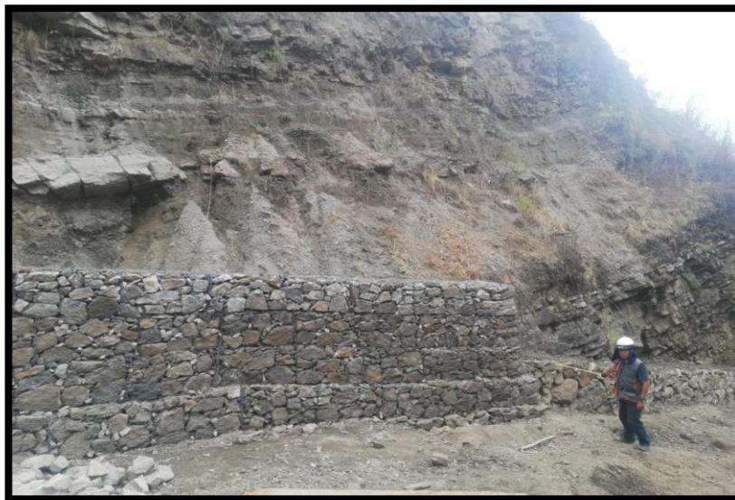
*Foto 5: Verificación de altura de gaviones para mejorar Defensa Ribereña Del Rio Chacapata*
