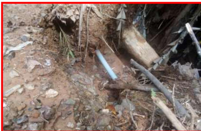
**Imagen 4.** Línea de conducción, tubería a la intemperie.
