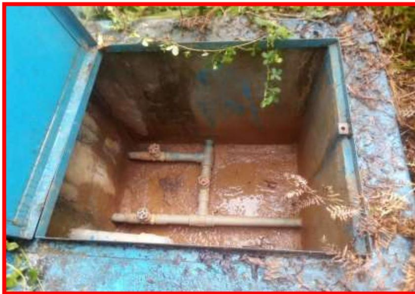
*Imagen 6.* Accesorios de la caseta de válvulas en malas condiciones.
