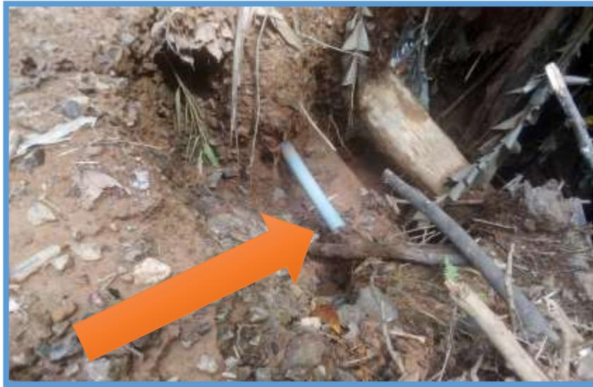
**Imagen 7.** Tubería de la línea de aducción expuesta a la intemperie.
