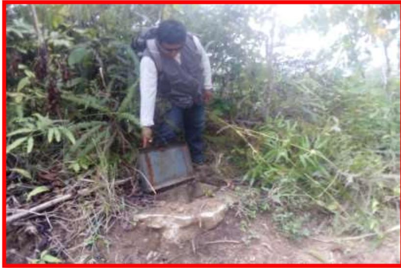
**Imagen 12.** Caseta de válvula de la cámara rompe presión tipo 6
