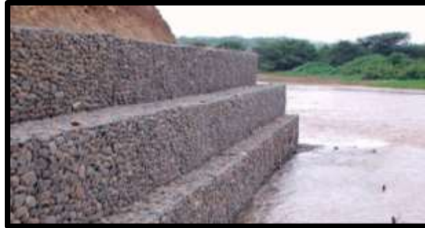
Figura 7. Gaviones con relleno de piedra
