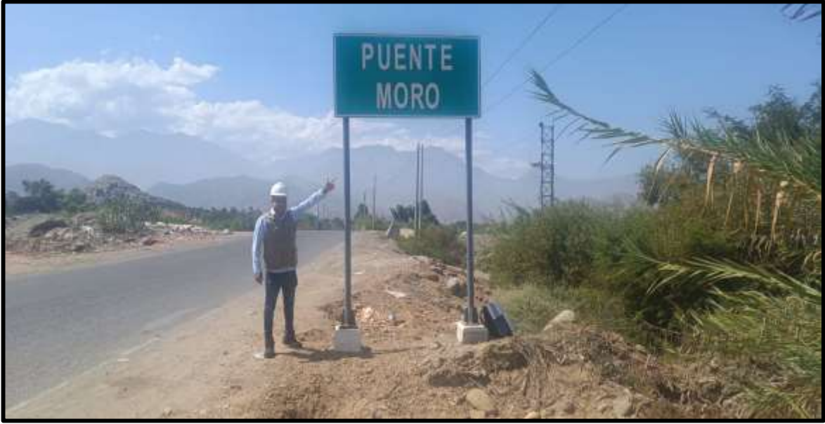
Figura 1: Toma fotográfica de la entrada hacia el puente de Moro
