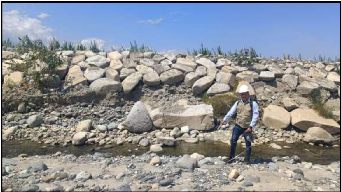
Figura 14: Toma de medición con una progresiva de inicio de 0+070 hasta 0+080.
