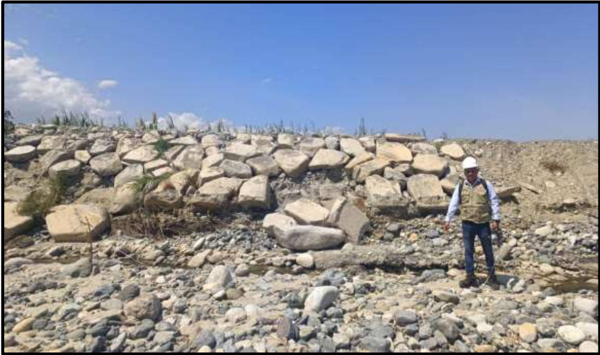
Figura 17: Toma de medición con una progresiva de inicio de 0+090 hasta 0+100.
