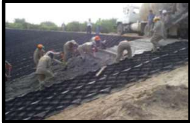
Figura 5. Sistema de geoceldas con relleno de agregados
