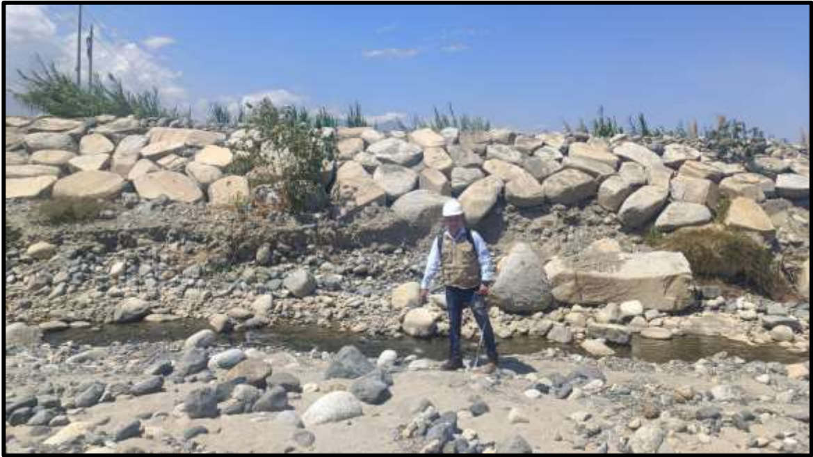
Figura 13: Toma de medición con una progresiva de inicio de 0+060 hasta 0+070.
