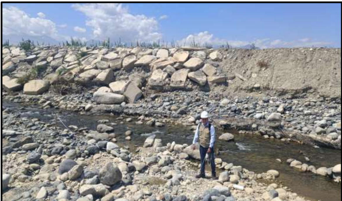
Figura 18: Toma de medición con una progresiva de inicio de 0+100 hasta 0+110
