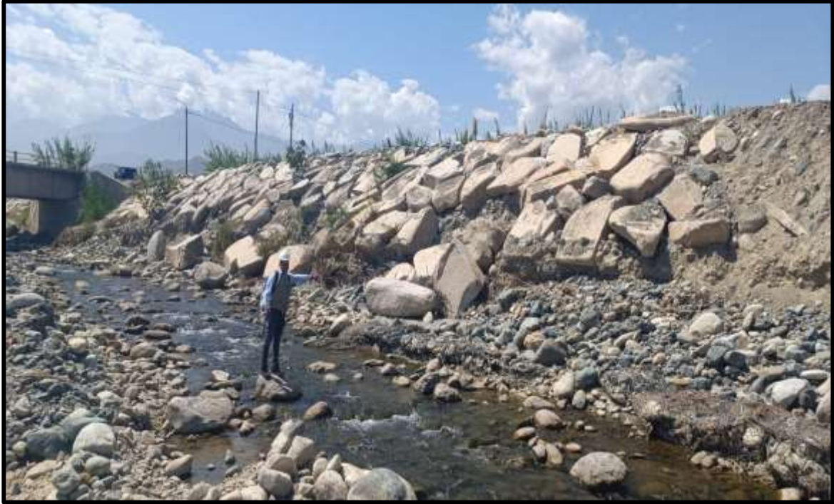
Figura 19: Toma fotográfica de la parte final del enrocado
