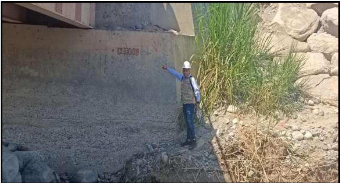
Figura 26: Cota de inicio 0+000 aguas abajo del puente Moro.
