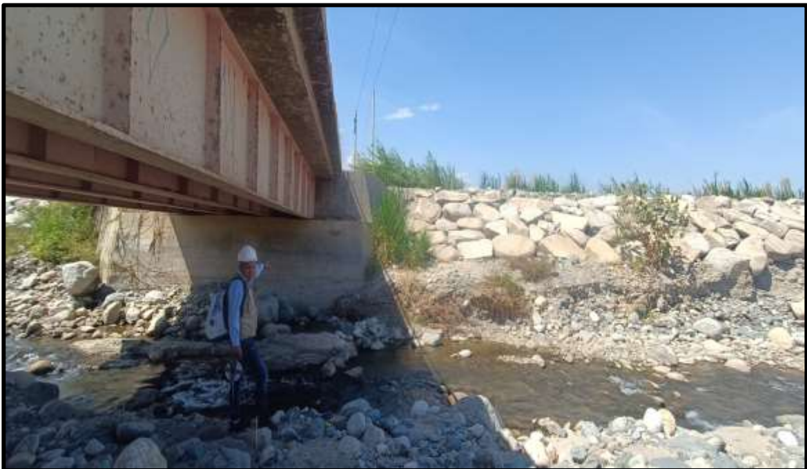
Figura 8: Se observa el inicio del enrocado debajo del puente Moro.
