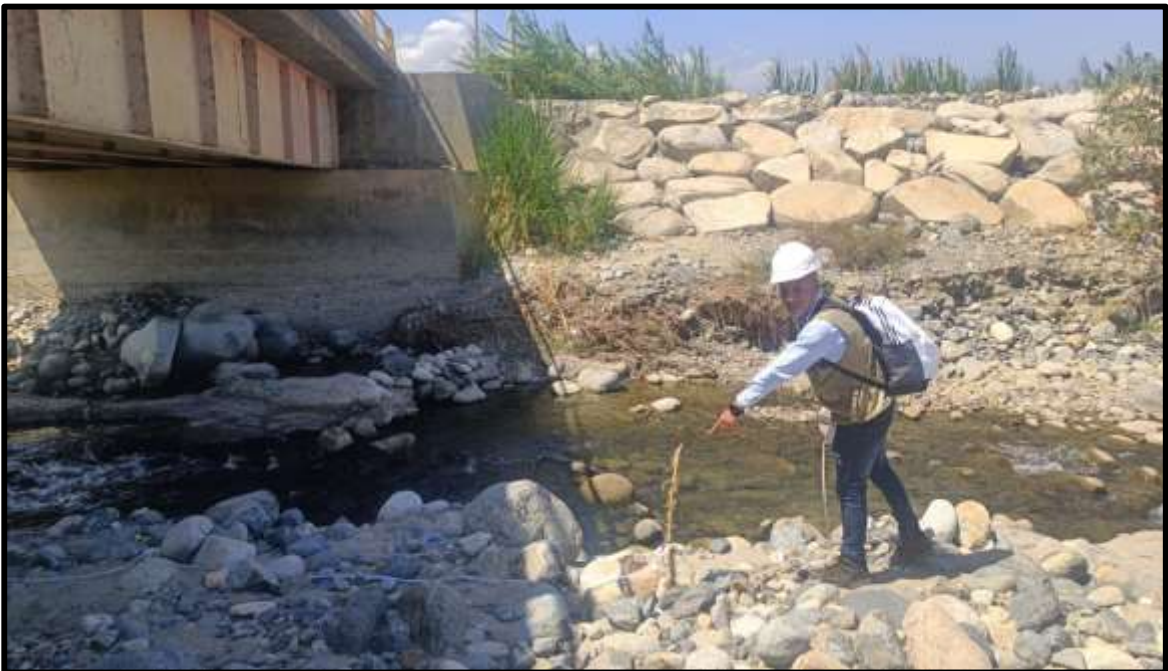
Figura 12: Toma de medición con una progresiva de inicio de 0+040 hasta 0+060.
