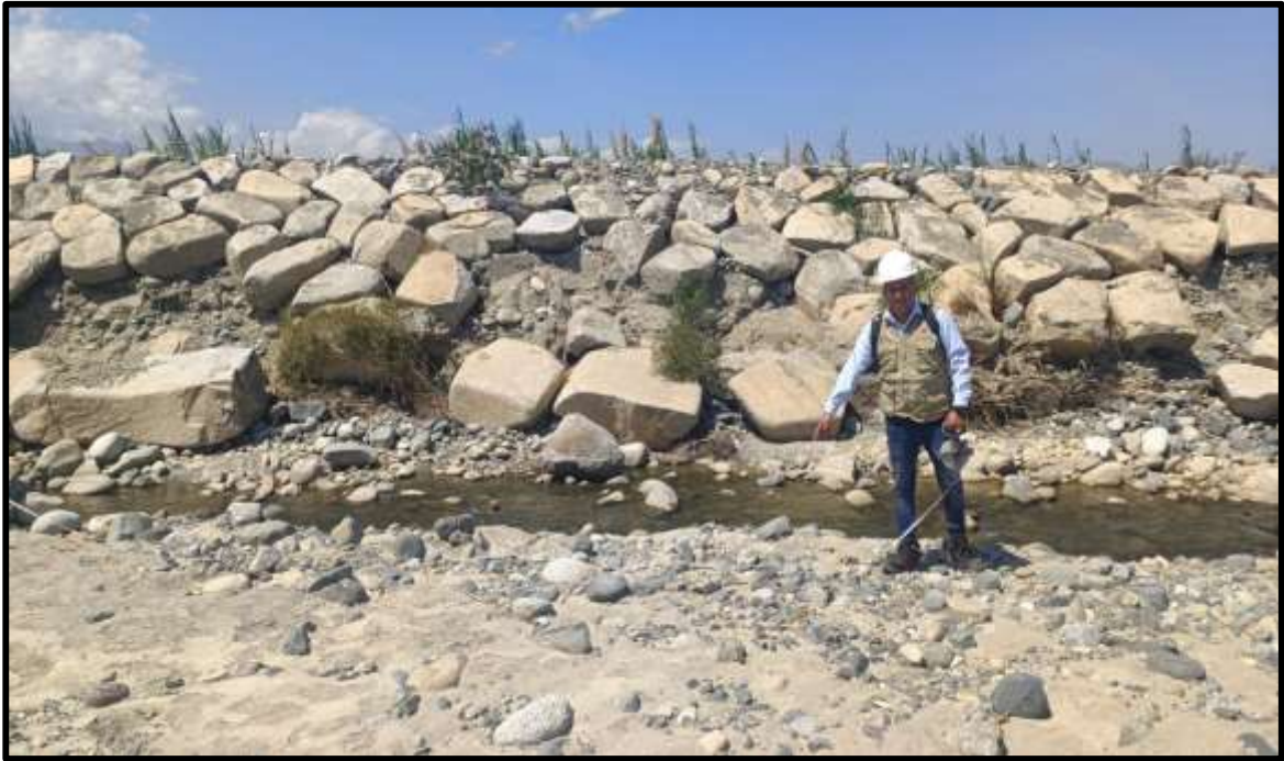
Figura 15: Toma de medición con una progresiva de inicio de 0+070 hasta 0+080.
