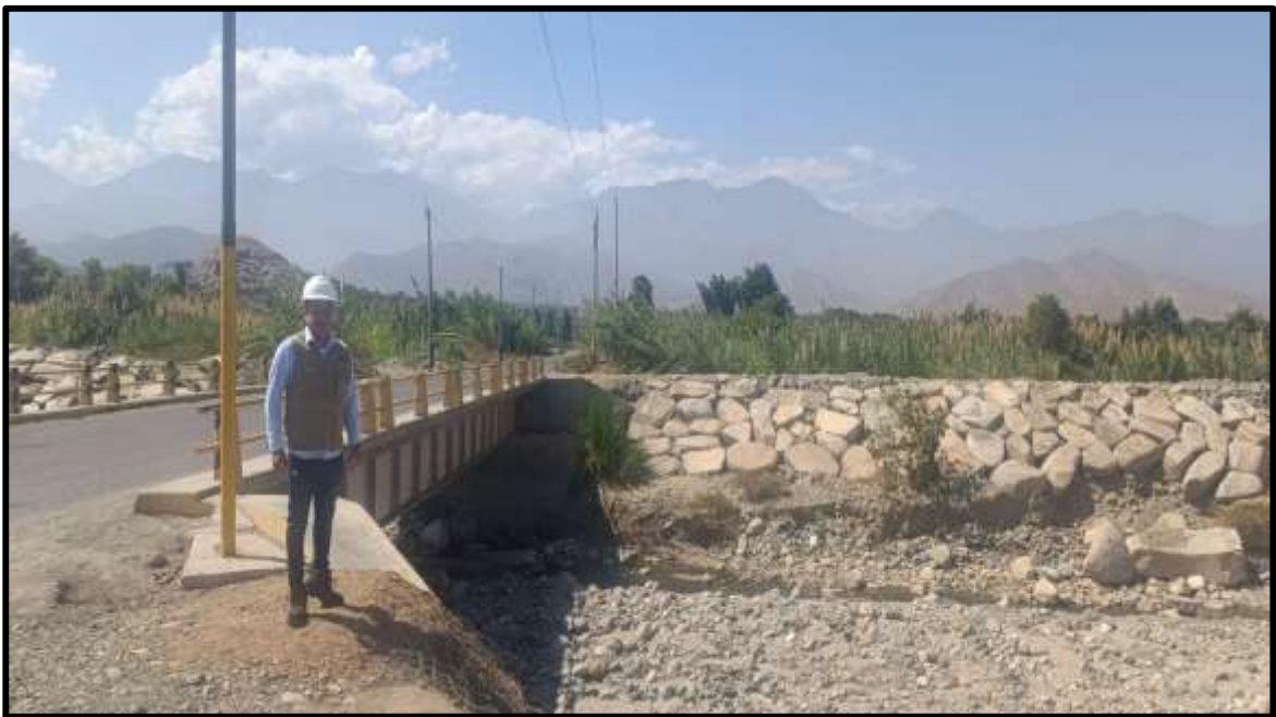
Figura 2: Punto de inicio del enrocado aguas abajo del puente de Moro.
