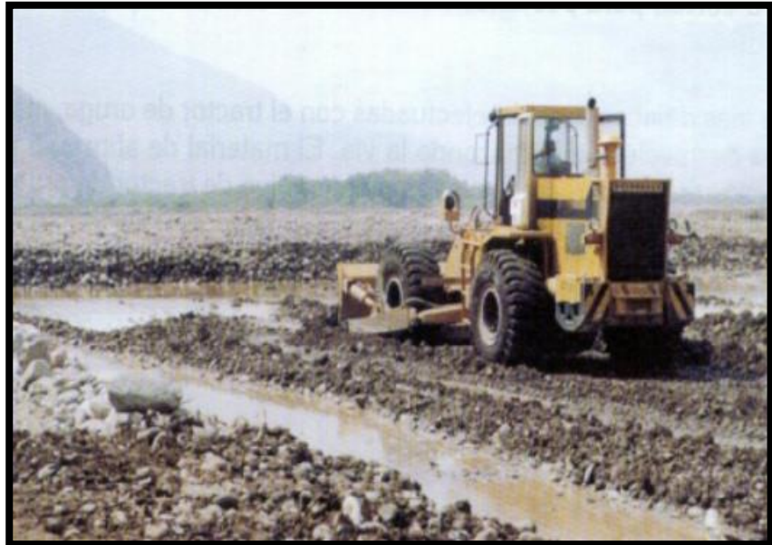
Figura 5: Preparación de la vía de acceso.
