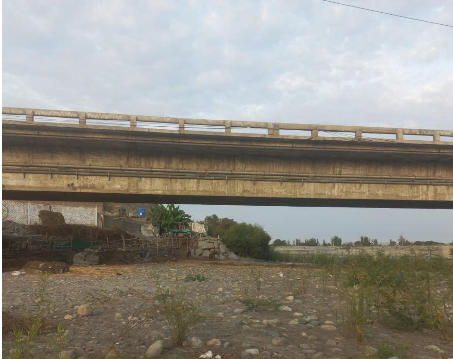
Figura 19: : Enrocado del lado derecho del puente Santa visto desde el lecho del rio Santa. Fuente: Elaboración propia
