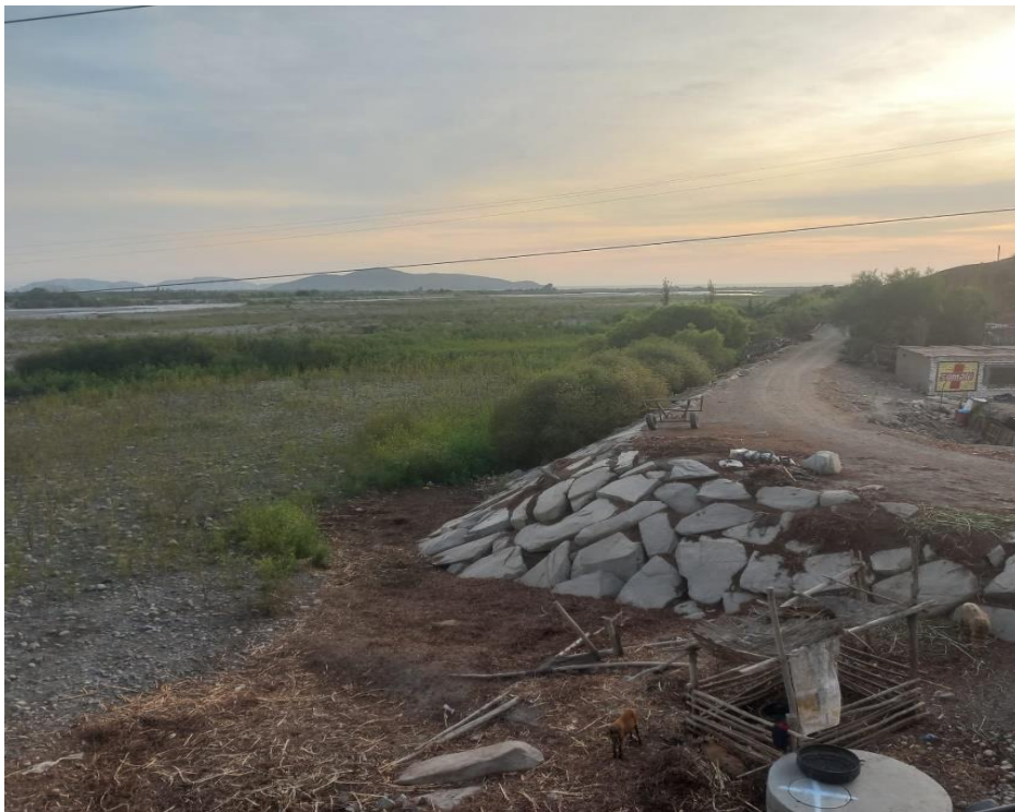
Figura 20: Enrocado del lado derecho del puente Santa visto desde el puente. Fuente: Elaboración propia
