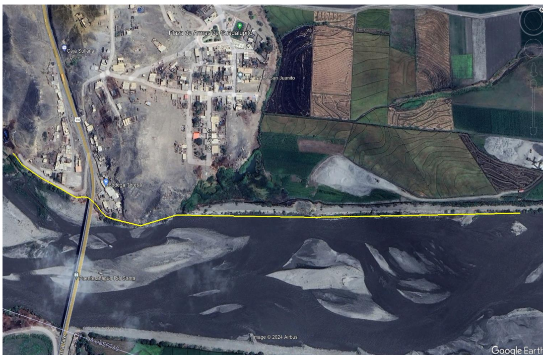
Figura 17: Vista general del centro poblado Santa Rosa Bajo y la defensa ribereña
