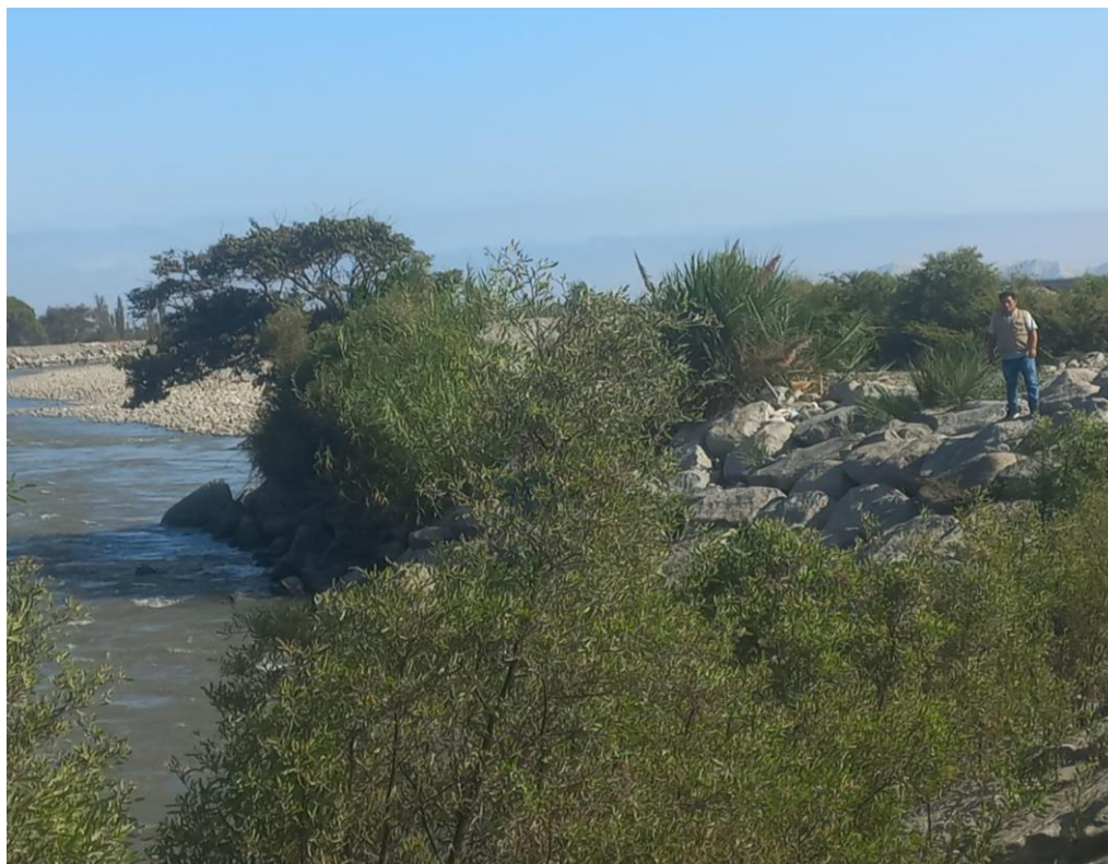
Figura 24: Enrocado aguas arriba del centro poblado progresiva 0+950 Fuente: Elaboración propia
