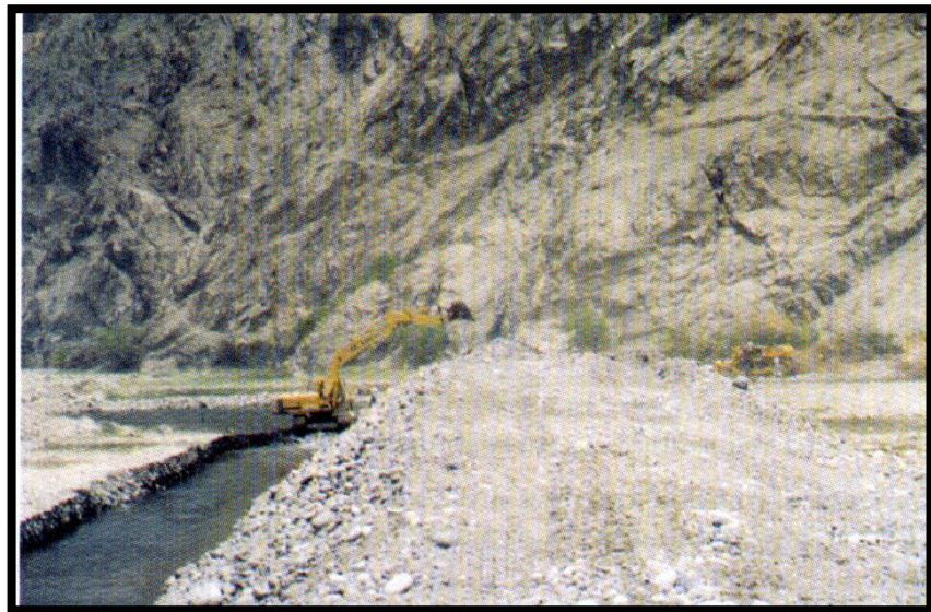
Figura 7: Tractor armando terraplén.
