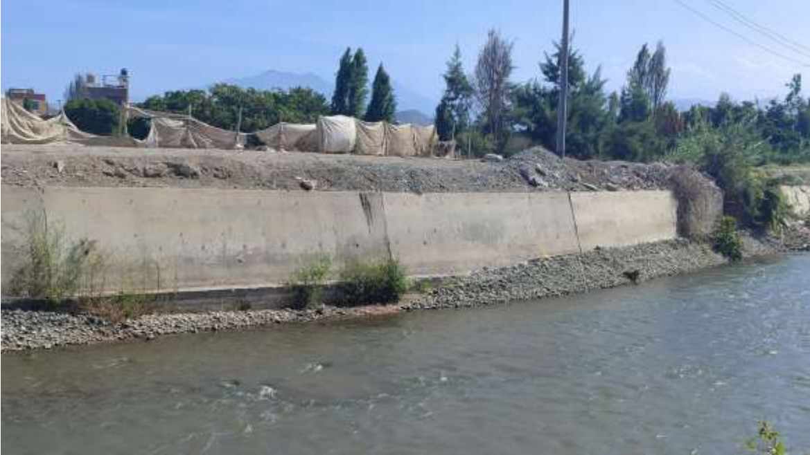
Fotografía 01 : se observa el muro de contención de la progresiva 0+040 a la 0+080
