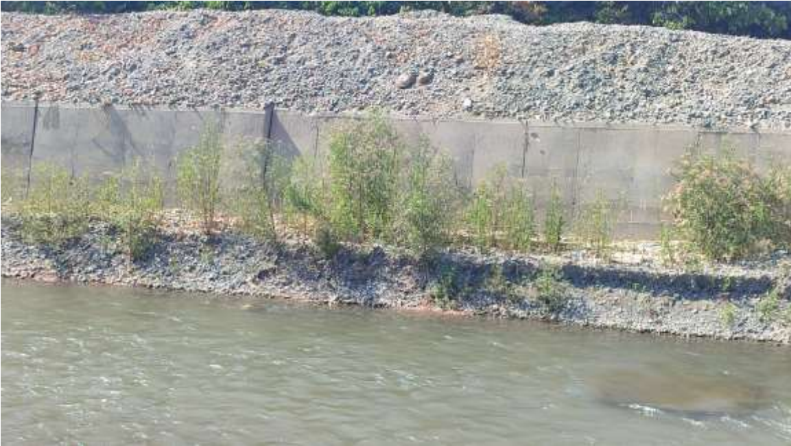
Fotografía 01 : se observa el muro de contención de la progresiva 0+020 a la 0+037
