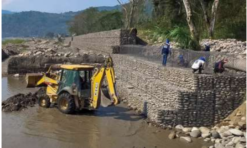
Figura 6 Muro de Gaviones
