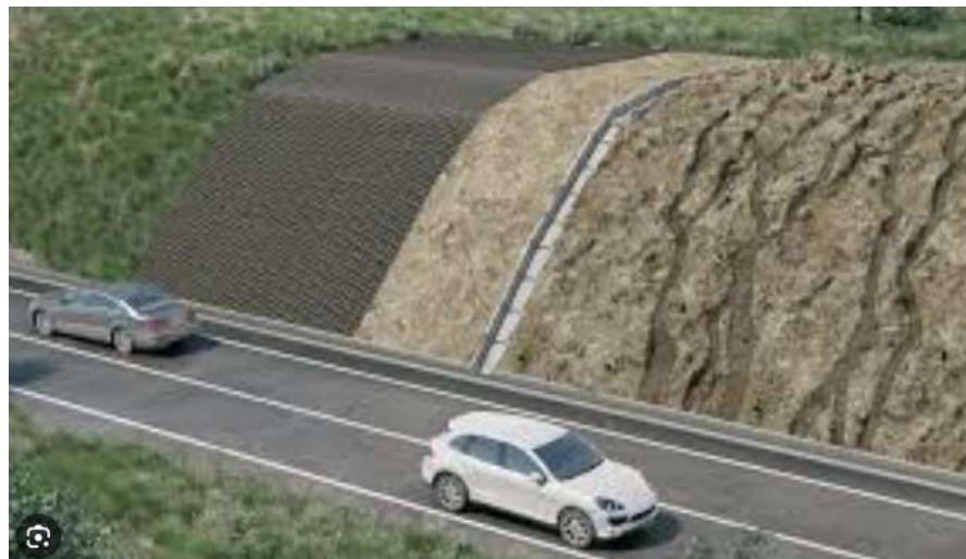
Figura 12 Erosión de taludes
