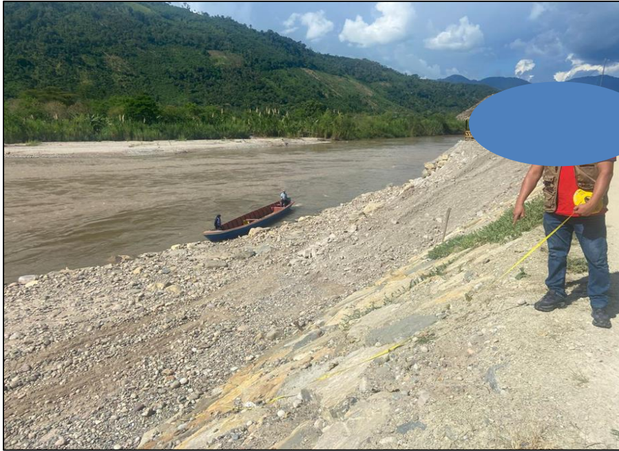
Figura 1: Vista del enrocado existente
