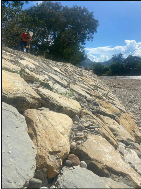
Figura 3: Vista general parte inferior del enrocado existente
