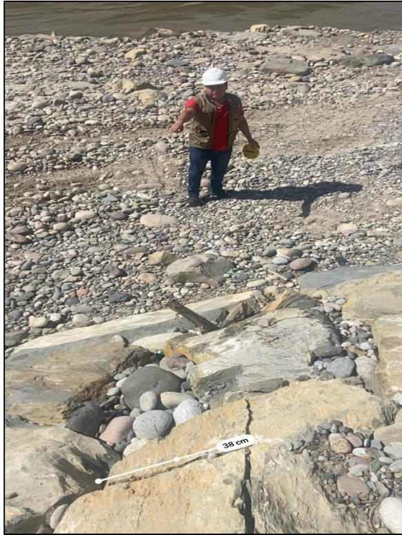
Figura 7: Punto de inicio del tramo a intervenir del enrocado existente
