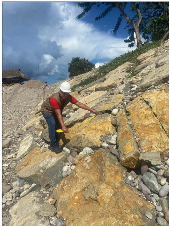
Figura 8: Midiendo el longitud de las rocas usadas en el enrocado existente
