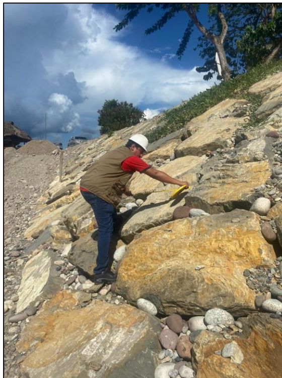
Figura 4: Medición de la longitud del enrocado existente
