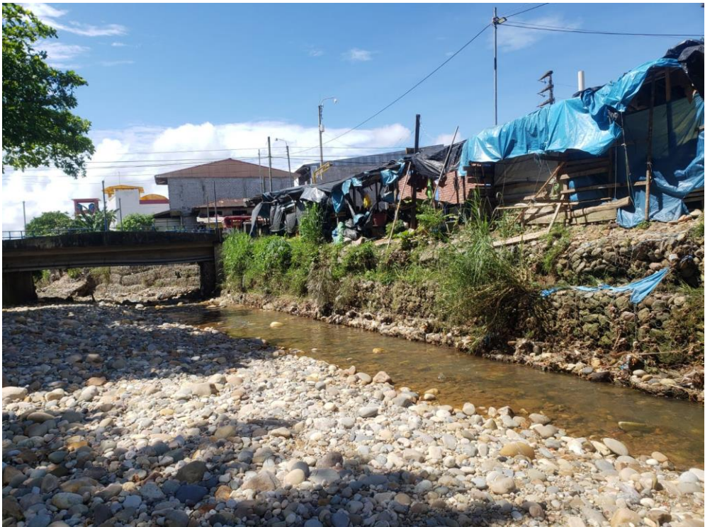
Figura 35: Vista desde el otro lado del Puente Rímac.
