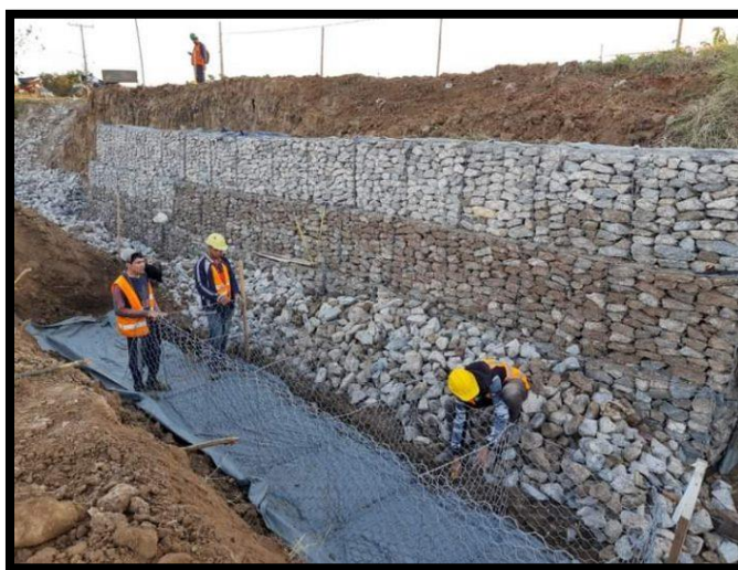
Figura 8: Reforzamiento Estructural
