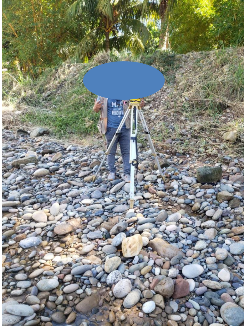
Figura 34: Levantamiento Topográfico para conocer la altura real y longitud a mejorar.
