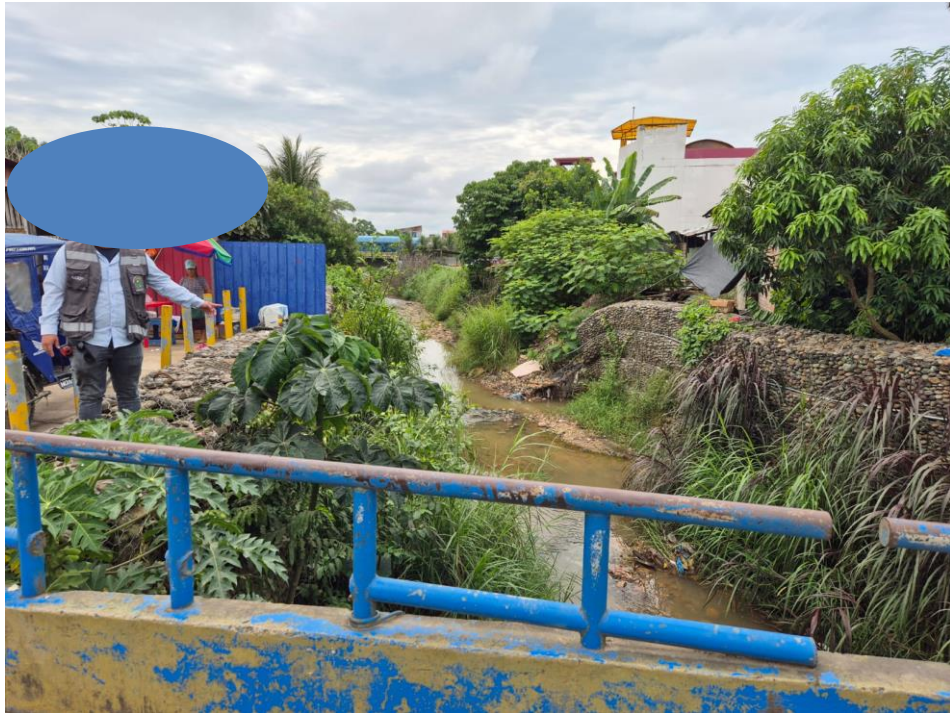
Figura 29: Vista Panorámica del Muro de Gavión desde el Puente Rímac.
