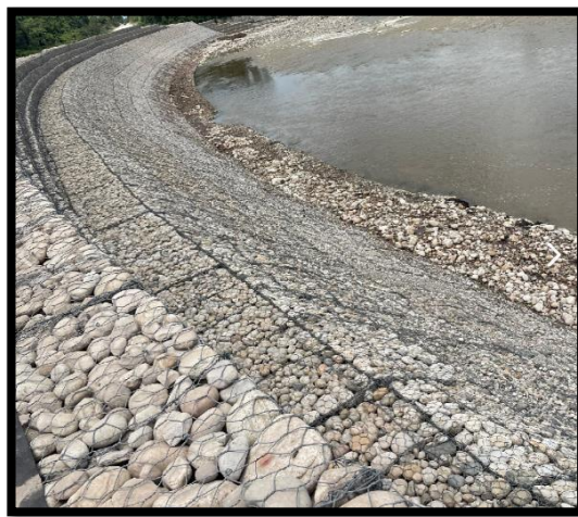
Figura 4: Muro Tipo Colchon
