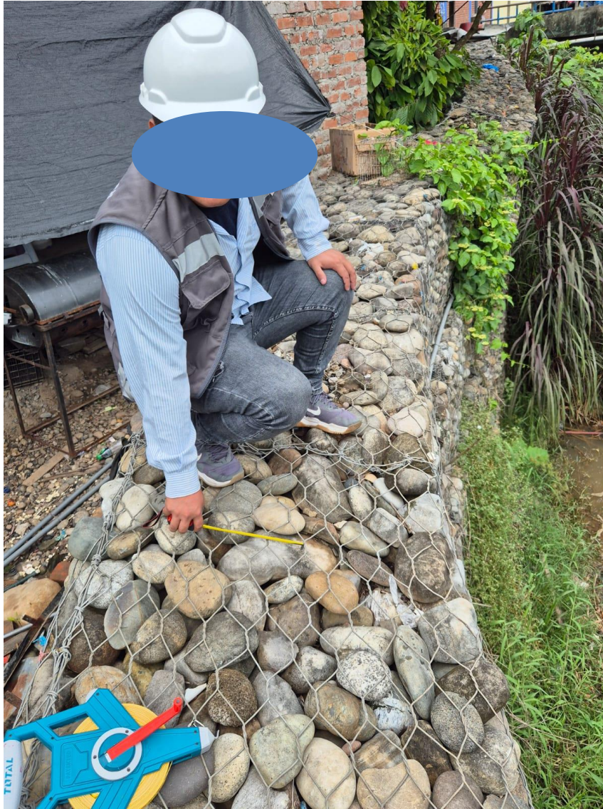
Figura 31: Toma de Medida de la Separación de la Malla Hexagonal
