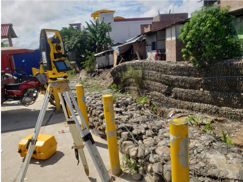
Figura 36: Levantamiento Topográfico para conocer la altura real y longitud a mejorar.
