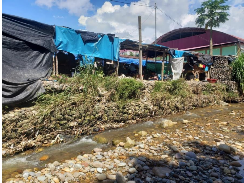
Figura 32: Viviendas Construida al Borde de la Quebrada.
