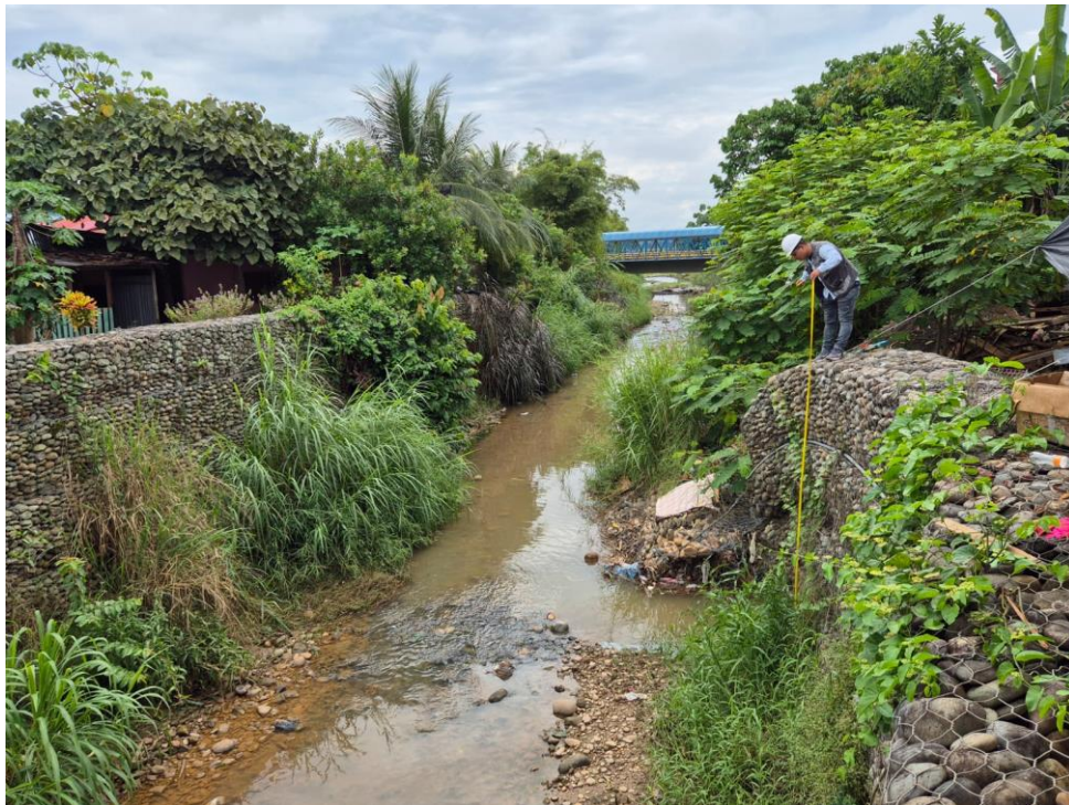
Figura 28: Toma de Altura del Muro de Gavión
