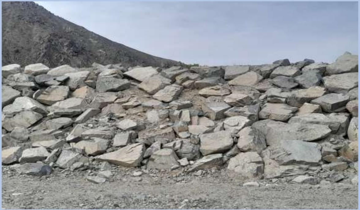
**Foto 13:** Se puede apreciar talud erosionado desde la progresiva 0+190 hasta 0+210.
