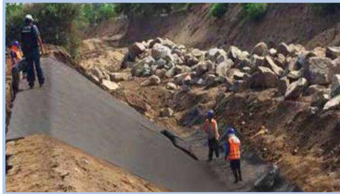
**Figura 7.** Geotextil de protección para dique enrocado.
