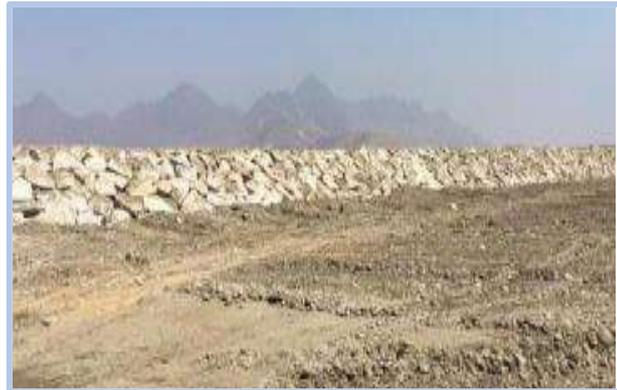
**Figura 12.** Enrocado con roca colocada.
