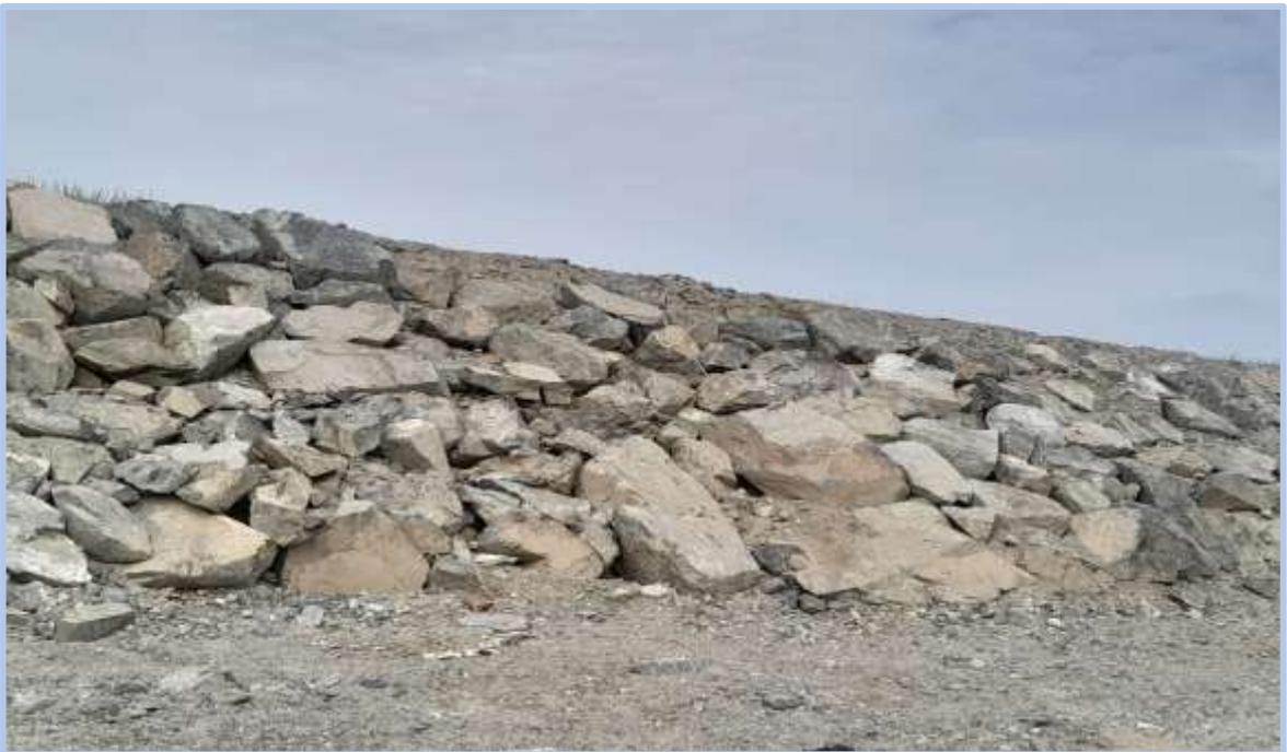
**Foto 14:** Se observa falta de protección en la corona desde las progresiva 0+160 hasta 0+195.
