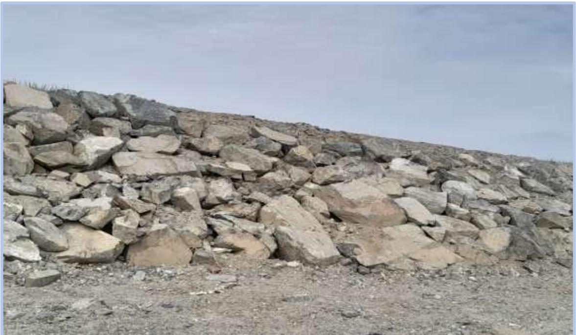
**Foto 16:** Se observa rocas que pueden sufrir volteo por estas sobre una estructura totalmente inestable.
