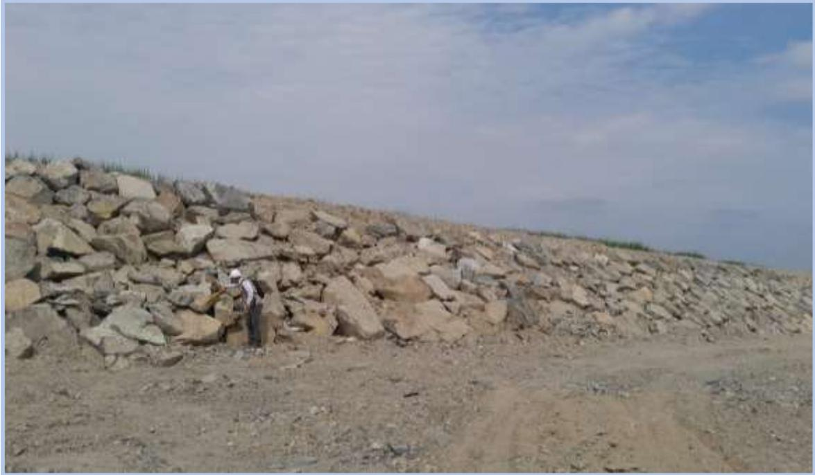
**Foto 11:** Se observa la toma de medida de los espaciamientos del enrocado desde la progresiva 0+120 hasta la 0+160.
