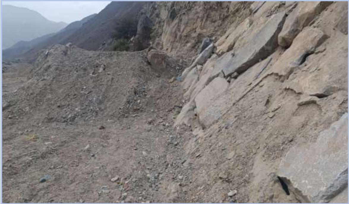
**Foto 17:** Se observa la construcción de un dique de altura de 2.50 metros para la protección del inicio del enrocado.
