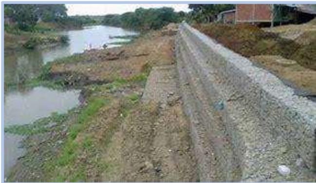
**Figura 15.** Muro de gaviones.
