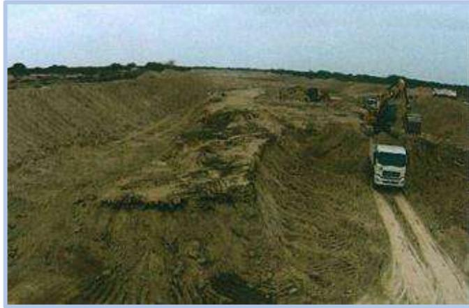
**Figura 8.** Extracción de material sedimentado de cauce
