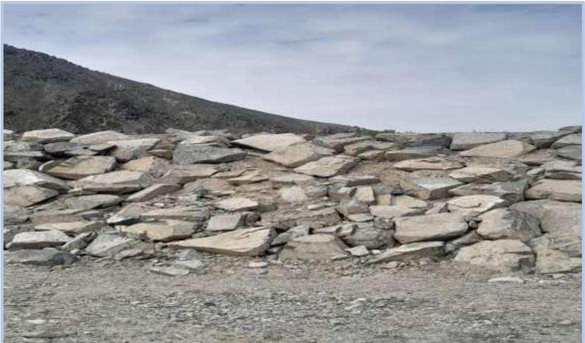
**Foto 12:** Se puede apreciar talud erosionado desde la progresiva 0+165 hasta 0+190.
