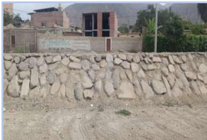
**Figura 5.** Deterioro de juntas.
