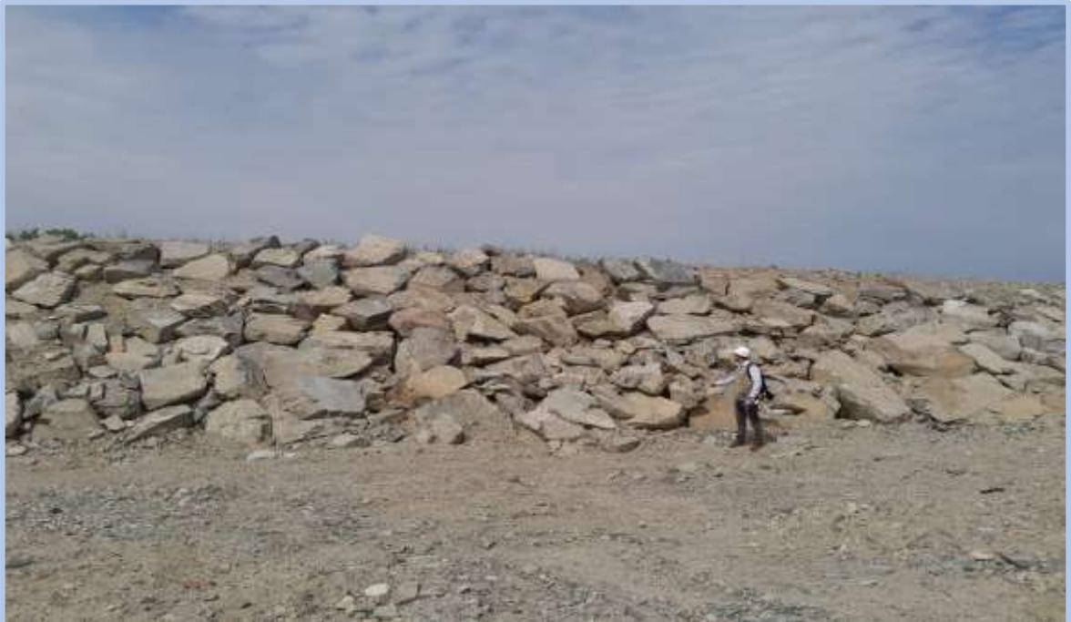
**Foto 6:** se observa el enrocado desde la progresiva 0+110 hasta 0+120, donde se puede apreciar inestabilidad de enrocado.
