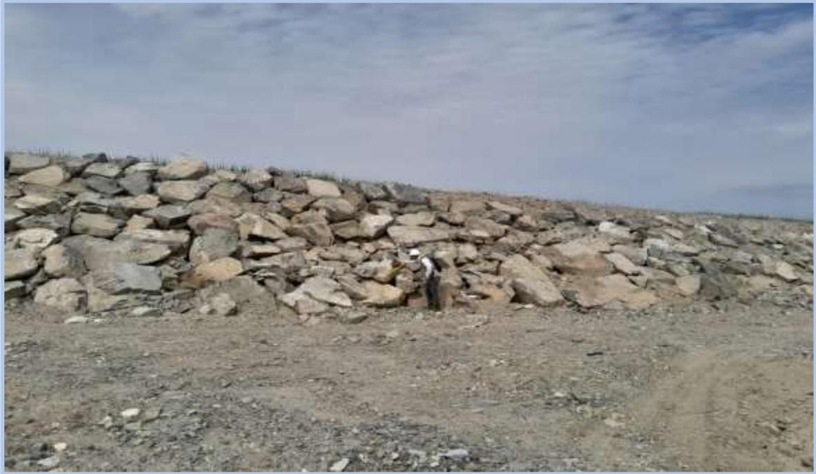
**Foto 7:** Se observa la toma de medida de los espaciamientos del enrocado desde la progresiva 0+080 hasta la 0+120.
