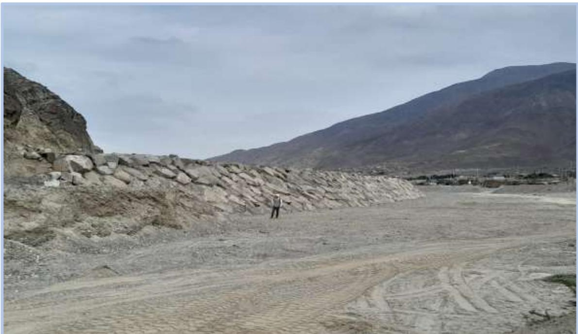
**Foto 4:** Se observa la continuación del enrocado desde la progresiva 0+000 hasta la 0+120.
