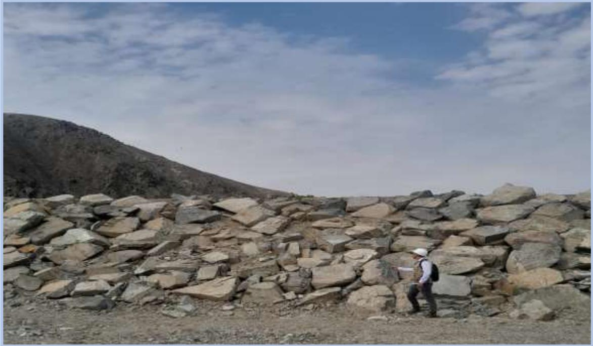
**Foto 9:** Se puede apreciar talud erosionado desde la progresiva 0+140 hasta 0+165.
