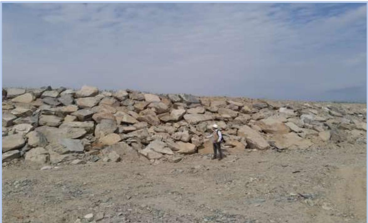
**Foto 10:** Se aprecia suelo sedimentado, así como enrocado rocas de menor tamaño en la parte de abajo desde la progresiva 0+080 hasta 0+125
