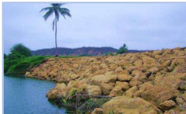
**Figura 11.** Enrocado con roca al volteo.
