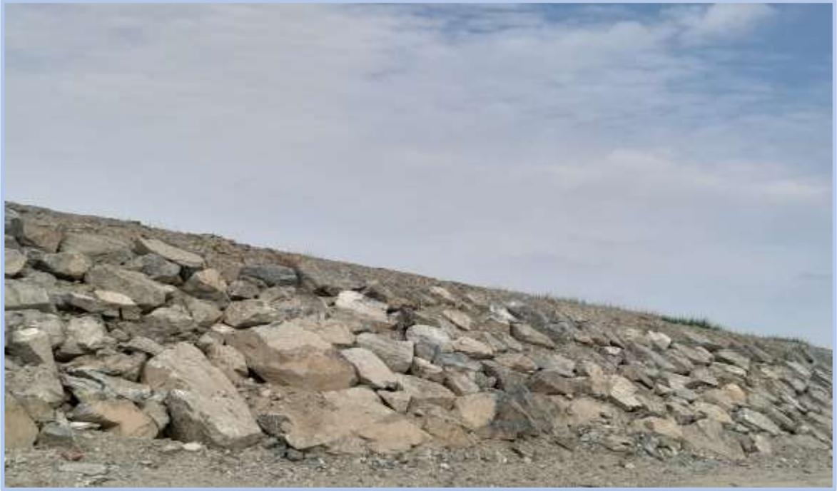
**Foto 15:** Se observa falta de protección en la corona desde las progresiva 0+195 hasta 0+210.
