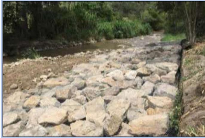
**Figura 4.** Desgaste del enrocado.
