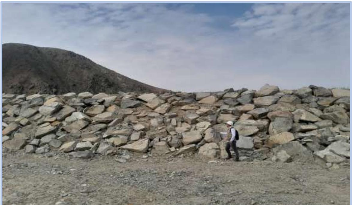
**Foto 8:** Se puede apreciar talud erosionado desde la progresiva 0+115 hasta 0+140.
