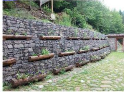
Figura 1. Estructura con gaviones. Fuente: <http://www.solucionesespeciales.net/MedioAmbiente/Gaviones/Gaviones.aspx>
