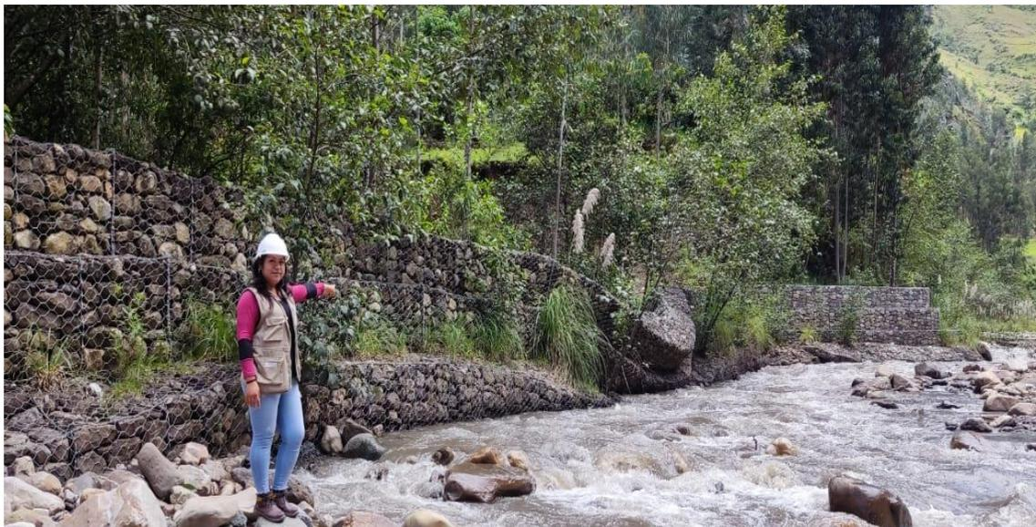
*figuras 10: Vista panorámica del volteo del muro de gaviones.*
