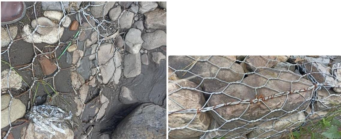
*figuras 14: Vista de la oxidación en la malla y el alambre del muro de gaviones.*
