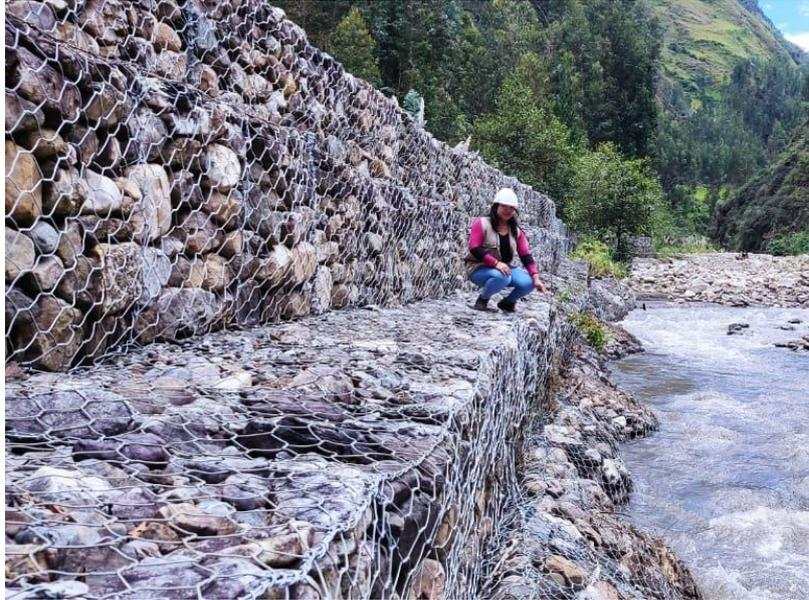
*figuras 13: Vista del colchón del muro de gaviones.*
