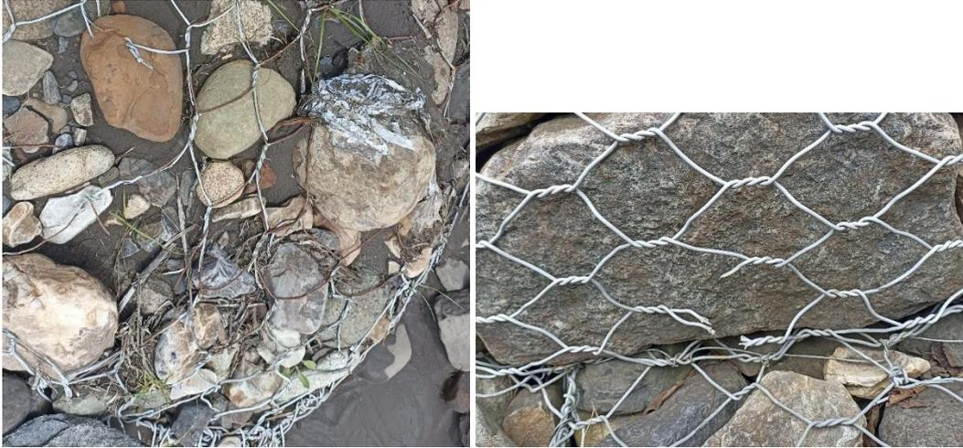
*figuras 15: Vista de la rotura de malla hexagonal.*
