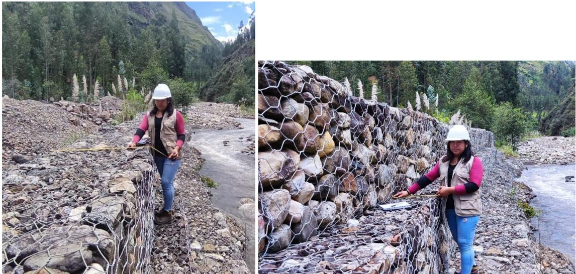
*figuras 12: Se puede observar la toma de medidas del muro de gaviones.*
