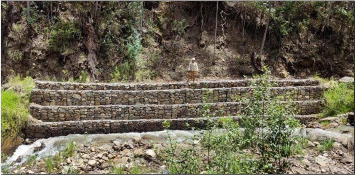
**Figura 17:** Foto frontal del muro de gavión del rio de Paicaran
