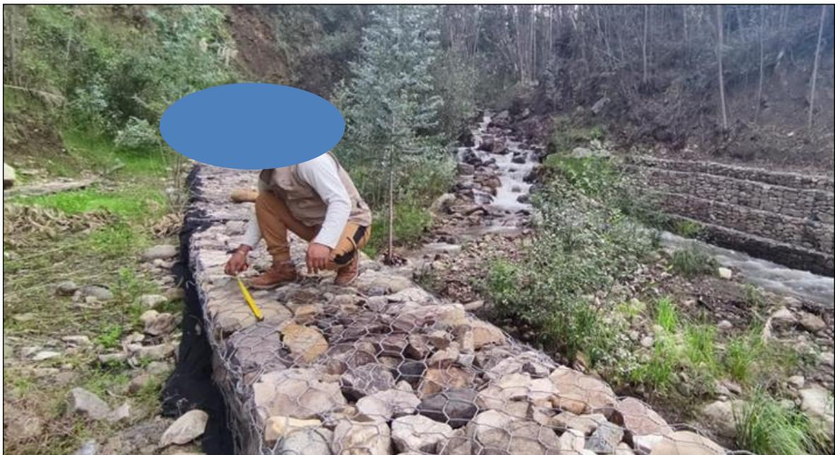
**Figura 16:** Extrayendo medidas del material de relleno que varía entre 12 y 55 cm del gavión
