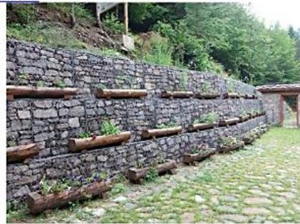
Figura 1. Estructura con gaviones. Fuente:
