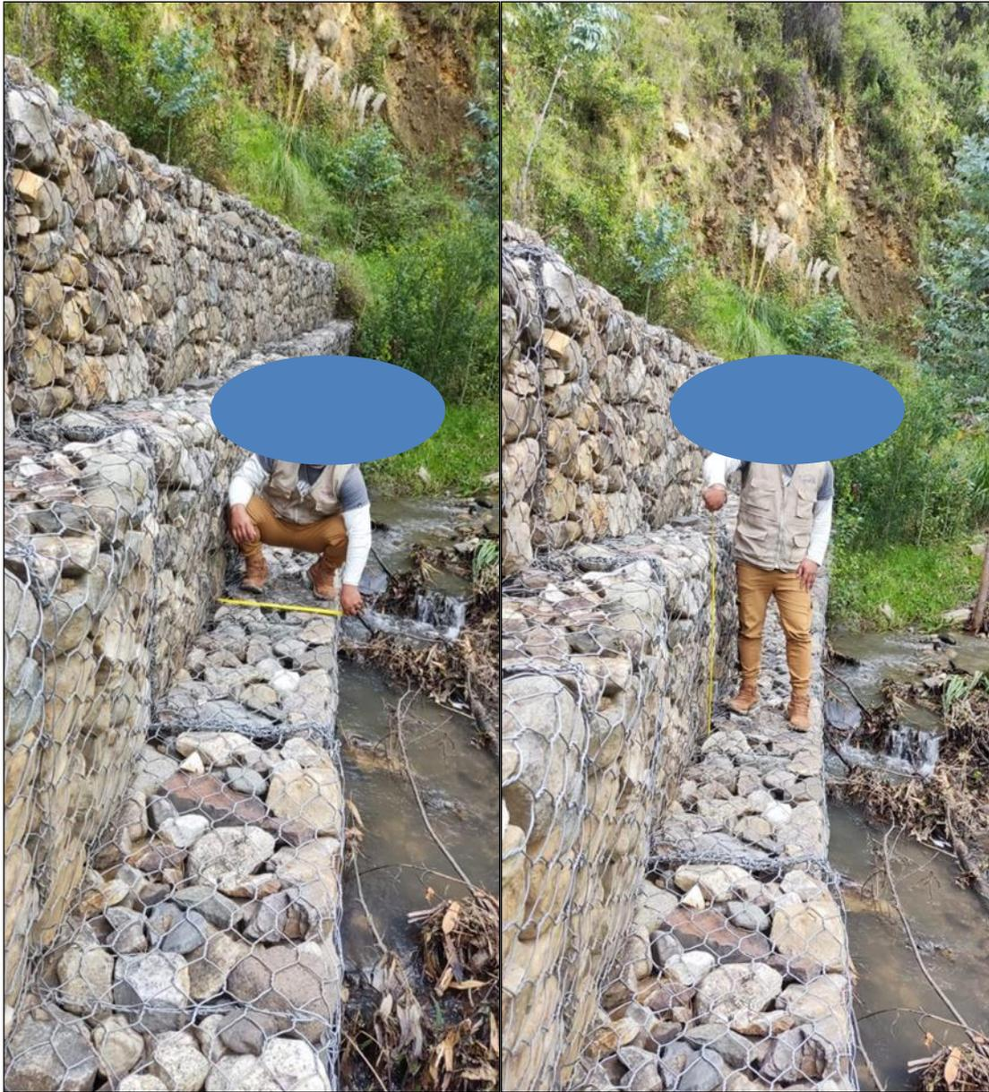
**Figura 20:** Tomando medidas de las dimensiones del muro de Gavión.
