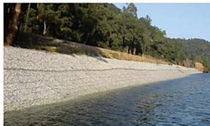
Figura 2. Gaviones para contención fluvial. Fuente:(A Bianchini, 2017).
