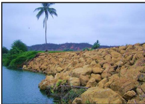
**Figura 11:** Dique enrocado al volteo
