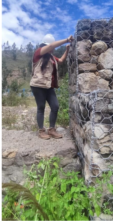
Figura 17. Se realizo la medida con la plomada para verificar la alineación del gavión.
