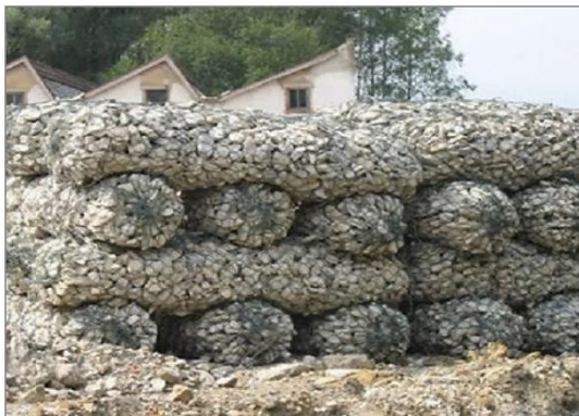
Figura 5. Gavión tipo saco.
