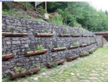
Figura 1. Estructura con gaviones. Fuente: http://www.solucionesespeciales.net/MedioAmbiente/Gaviones/Gaviones.aspx
