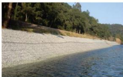
Figura 2. Gaviones para contención fluvial. Fuente: (A Bianchini, 2017).
