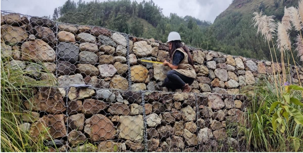
Figura 15. Medición de la altura del primer nivel del gavión tipo caja.
