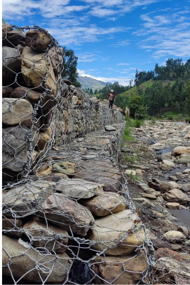
Figura 9. Vista panorámica de la defensa ribereña
