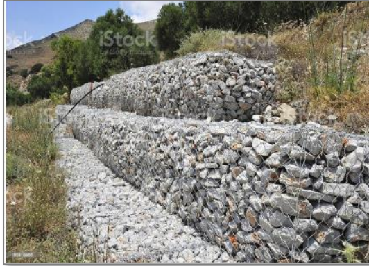
Figura 4. Gavión tipo caja.
