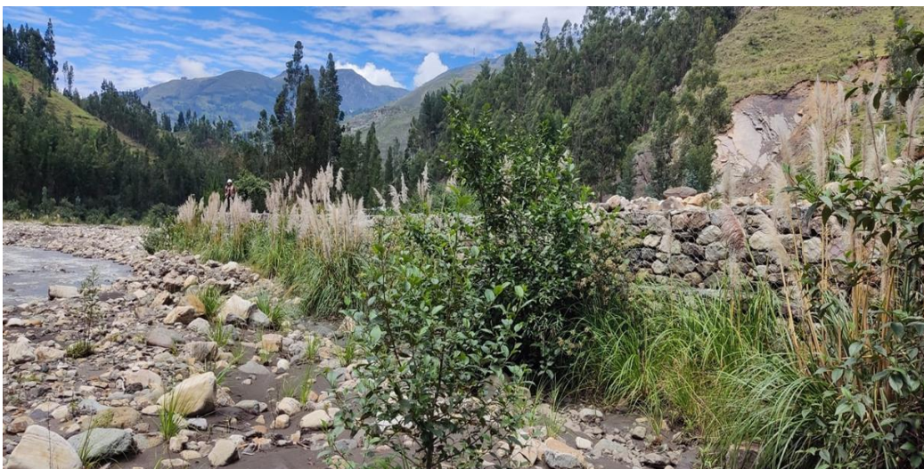
Figura 10. Vista desde la margen izquierda de la defensa ribereña.
