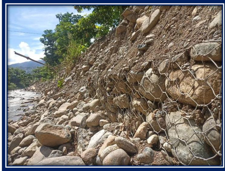
**Figura 13:** Vista acumulación de piedras en la malla del muro de gaviones del rio Omayá
