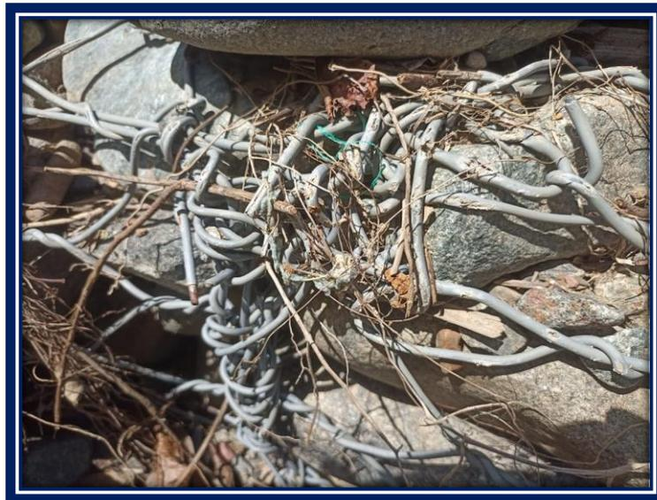
**Figura 14:** Evaluación de nudos del muro de gaviones del rio Omayá
