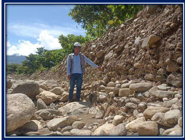
**Figura 11:** Daños en el enmallado del muro de gaviones del río Omayá Progresiva 1+100 al 1+200
