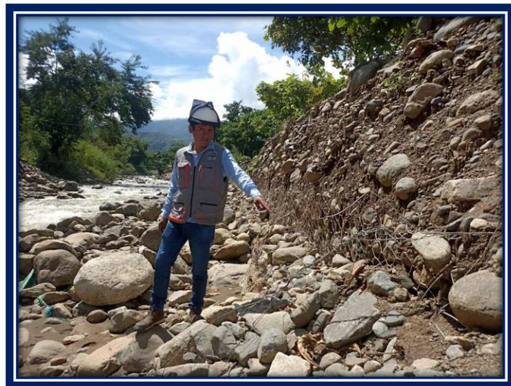
**Figura 12:** Enmallado en pésimo estado del muro de gaviones del río Omayá Progresiva 1+100 al 1+200
