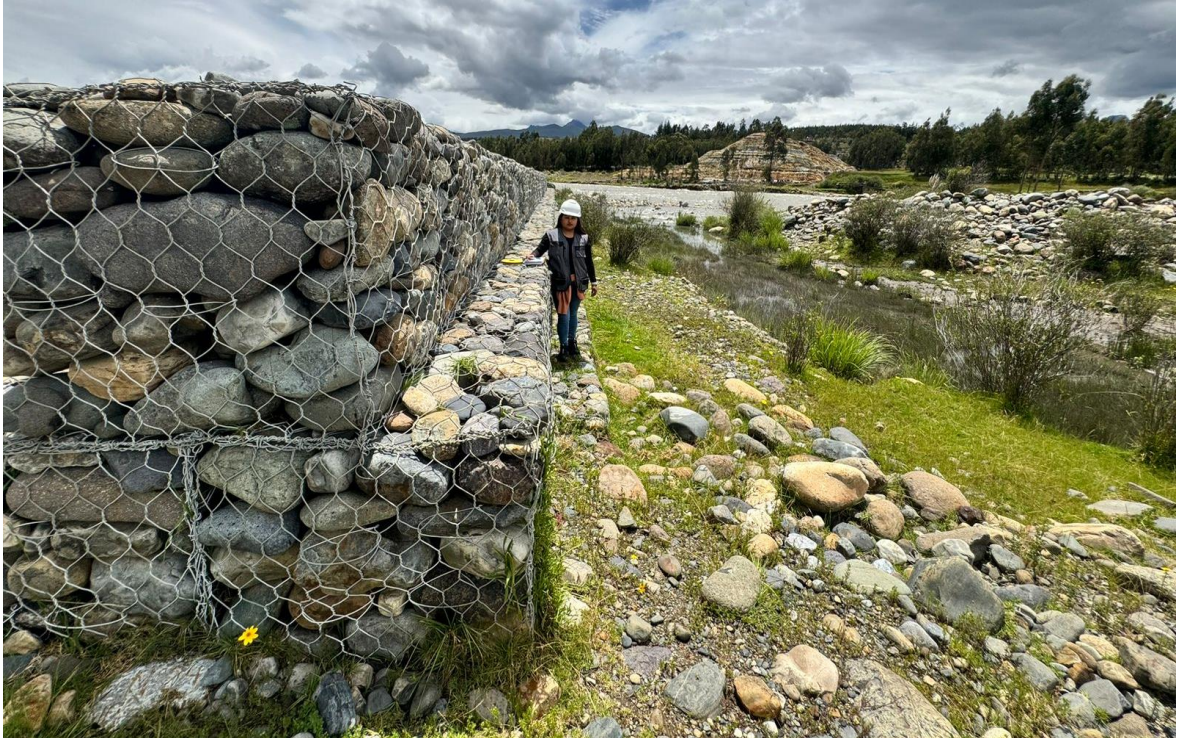
Figura 15. Vista panorámica del muro de gavión tipo caja
