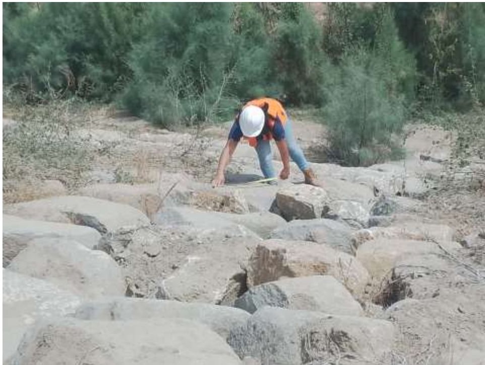
Figura 19: Tesista- medición del enrocado centro poblado Umaro san antonio
