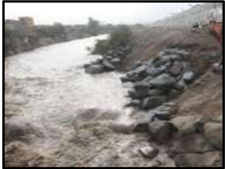
Figura 4: Deslizamiento de Talud
