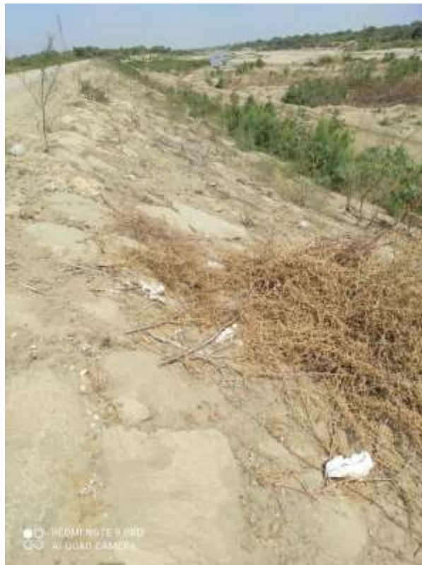
Figura 21: Enrocado Tramo III centro poblado Umaro san antonio
