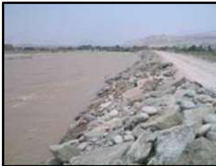
Figura 1: Enrocado
