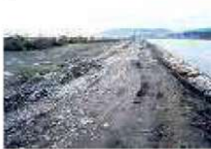
Figura 6.4. Talud peinado con maquinaria
