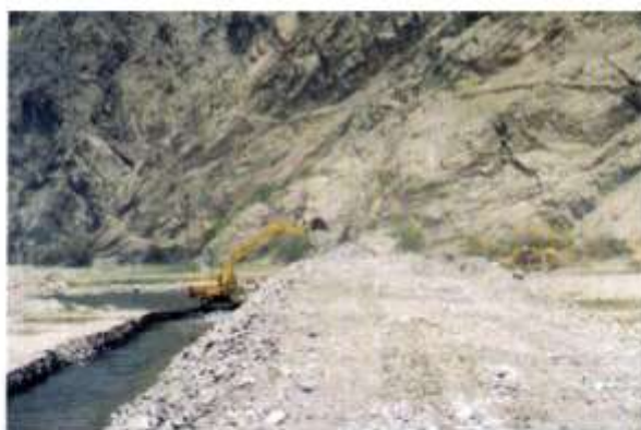
Foto N°4. Tractor iniciando armado de terraplén
