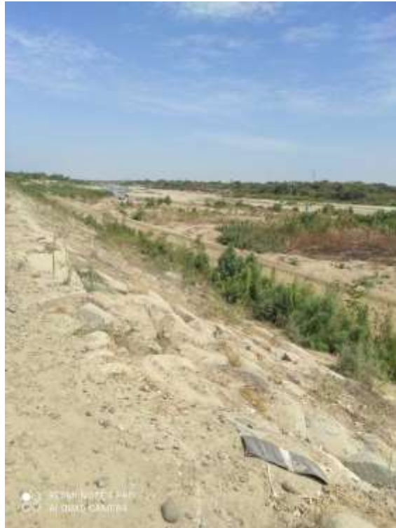
Figura 20: Enrocado del centro poblado Umaro san antonio
