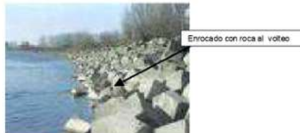
Figura 6.2. Fotografía de un enrocado con roca al volteo
