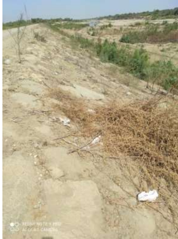
Figura 22: Enrocado - Progresiva 0+800 a 0+850 - centro poblado Umaro san antonio
