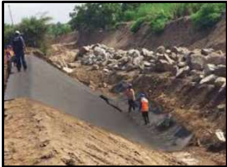
Figura 3: Colocación de geo textil
