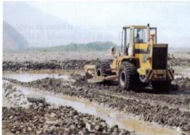
Foto N°3- Preparación de vía de acceso
