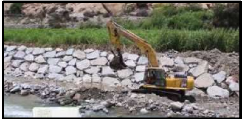
Figura 2: Colocación de piedra
