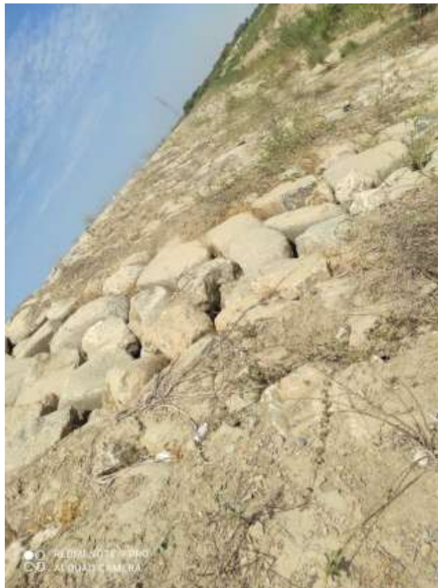
Figura 23: Enrocado- tramo IV. centro poblado Umaro san antonio
