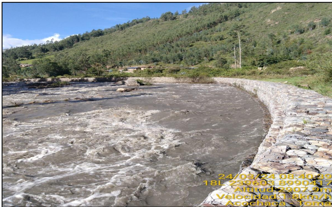
Figura 11: Ubicación de la defensa ribereña en el margen derecho de río Acochaca, distrito de Acochaca, provincia de Asunción, departamento de Ancash.
