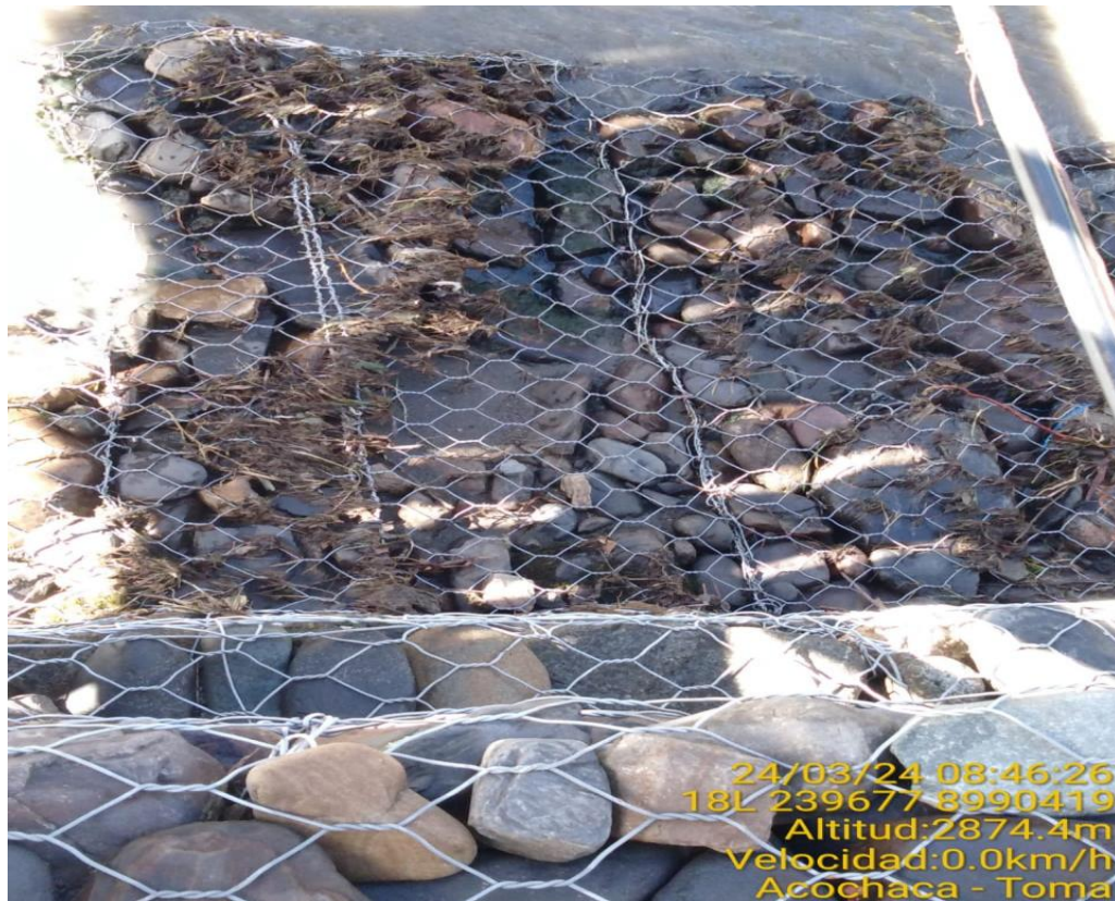
Figura 21: Imagen N° 11: Se aprecia la vista de la zapata tipo colchón. Fuente: Elaboración propia.
