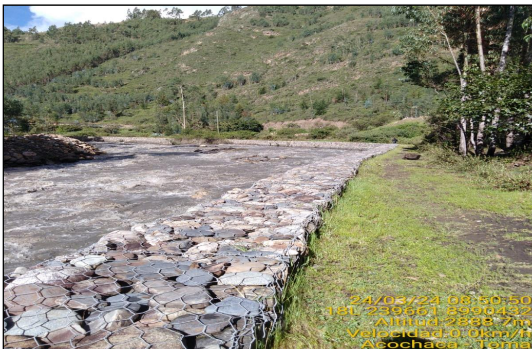
Figura 19: Imagen N a 09: Se aprecia la longitud de todo el tramo de estudio del muro de gaviones.
