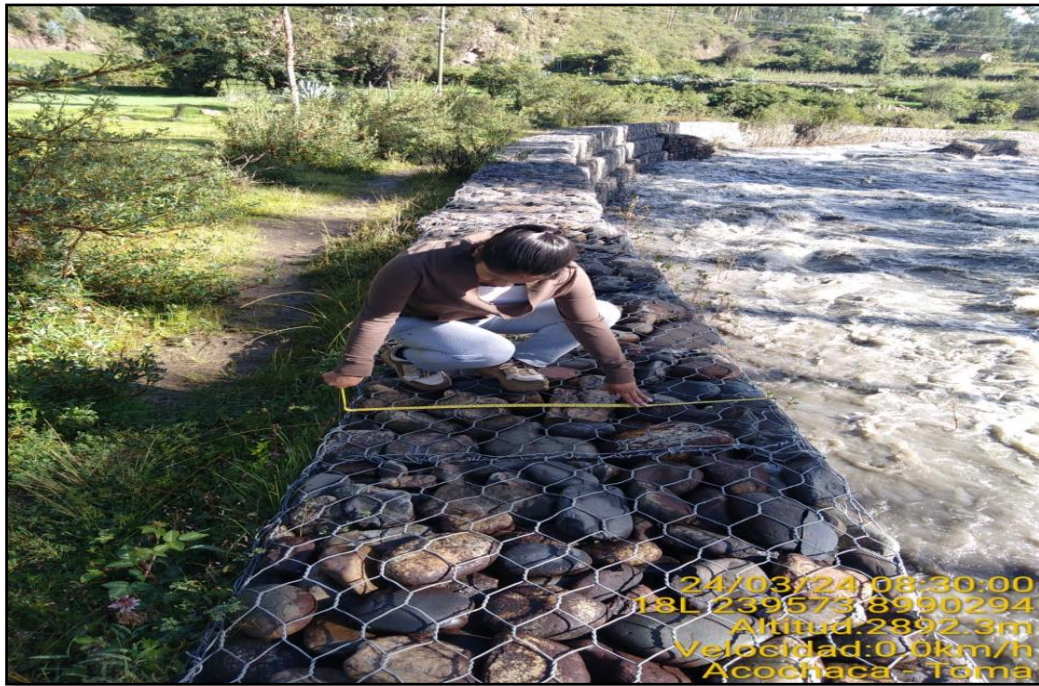
Figura 13: Medición de la anchura del muro de gaviones (tipo caja). Fuente: Elaboración propia.
