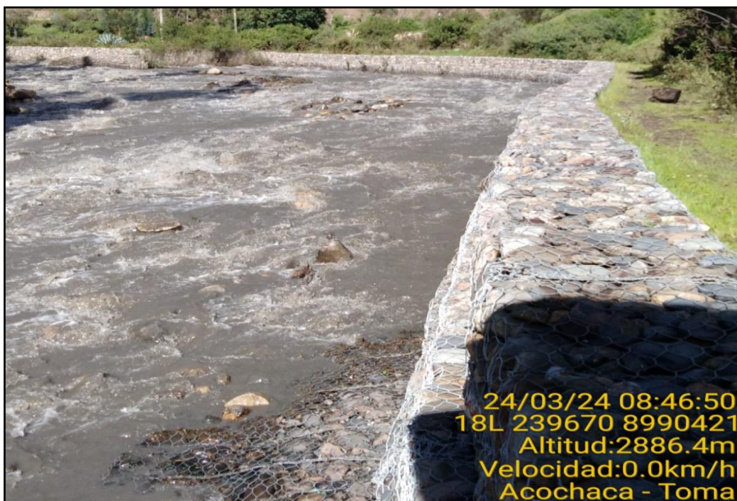
Figura 18: Imagen N a 08: Vista de la zapata tipo colchón.
