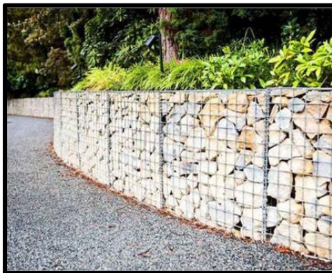
Figura 3: En la imagen podemos visualizar gaviones para decoración. Fue extraída de Fracassi (17).
