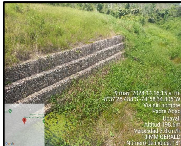
Figura 2: Inicio del muro de gaviones
