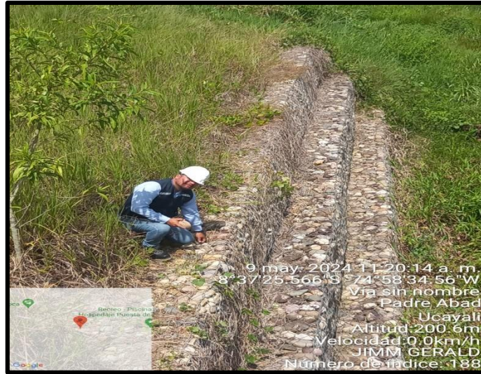
Figura 4: Medición de las hiladas del muro de gaviones a evaluar
