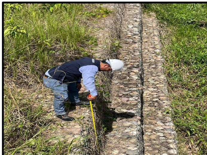
Figura 6: Medición de la altura de las hiladas de muro de gaviones
