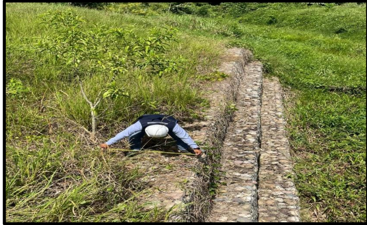
Figura 7: Medición de la anchura de las hiladas de muro de gaviones
