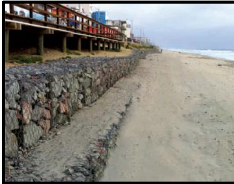
Figura 14: En la imagen podemos visualizar Gaviones en las playas. Fue extraída de Fracassi (17).
