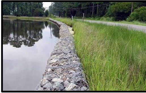
Figura 2: En la imagen podemos visualizar un muro de contención de aguas. Fue extraída de Fracassi (17).
