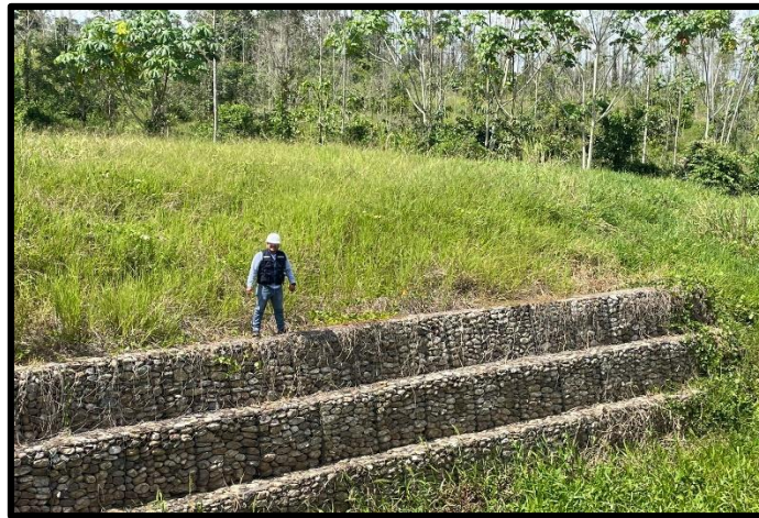
Figura 5: Vista de las hiladas del muro de gaviones
