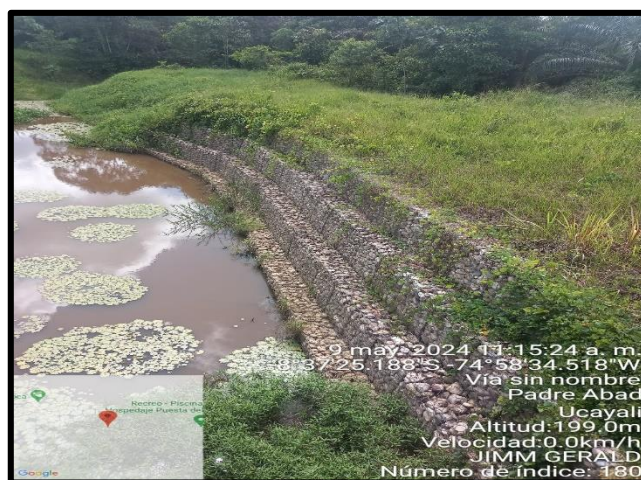
Figura 3: Panorama del muro de gaviones a evaluar
