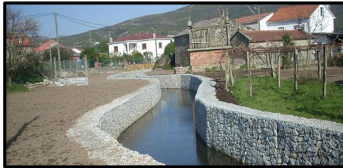
Figura 1: En la imagen podremos visualizar uno de los tipos de gaviones. Fue extraída de Fracassi (17).
