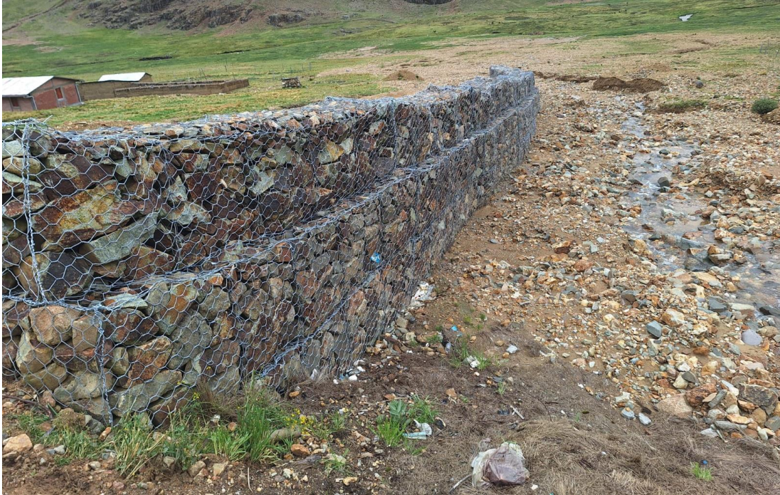
Figura 32: Muro de gaviones del rio Santa Fé.
