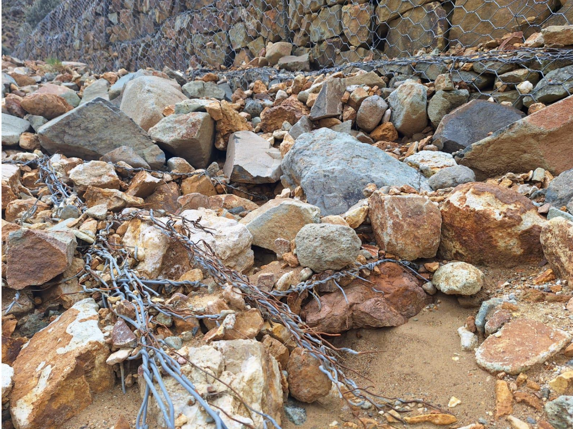
Figura 42: Evaluación del muro de gaviones progresiva 0+700 – 0+800.
