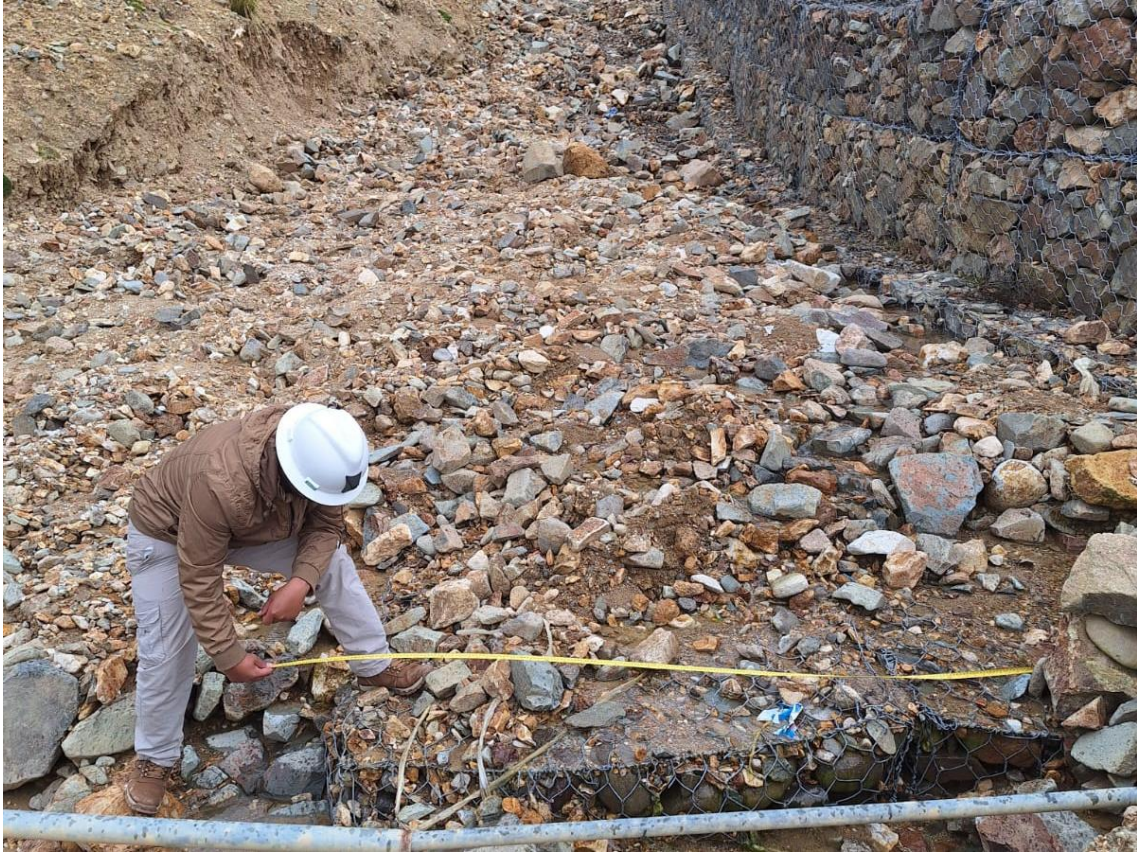
Figura 34: Evaluación del muro de gaviones progresiva 0+000 – 0+100.
