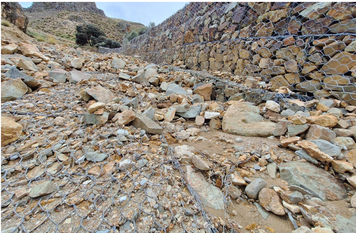
Figura 43: Evaluación del muro de gaviones progresiva 0+700 – 0+800.
