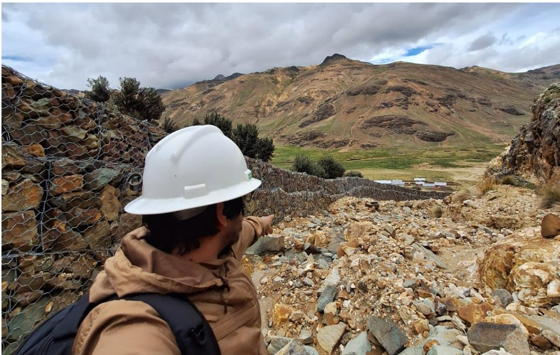
Figura 45: Evaluación del muro de gaviones progresiva 0+800 – 0+900.
