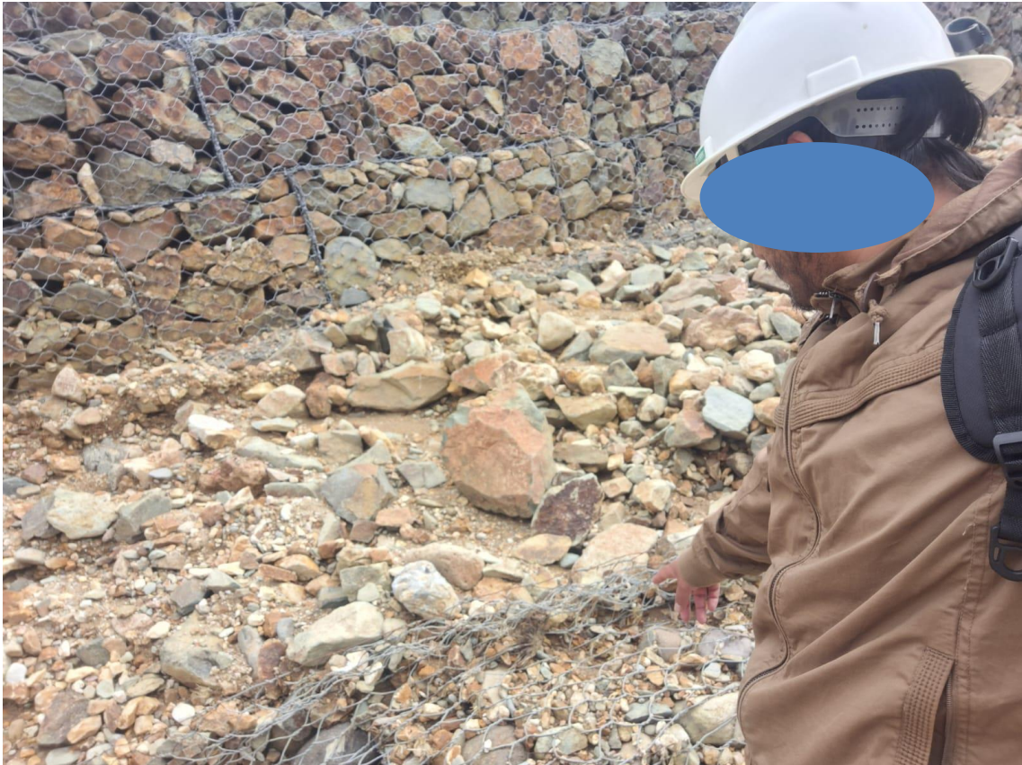
Figura 40: Evaluación del muro de gaviones progresiva 0+600 – 0+700.
