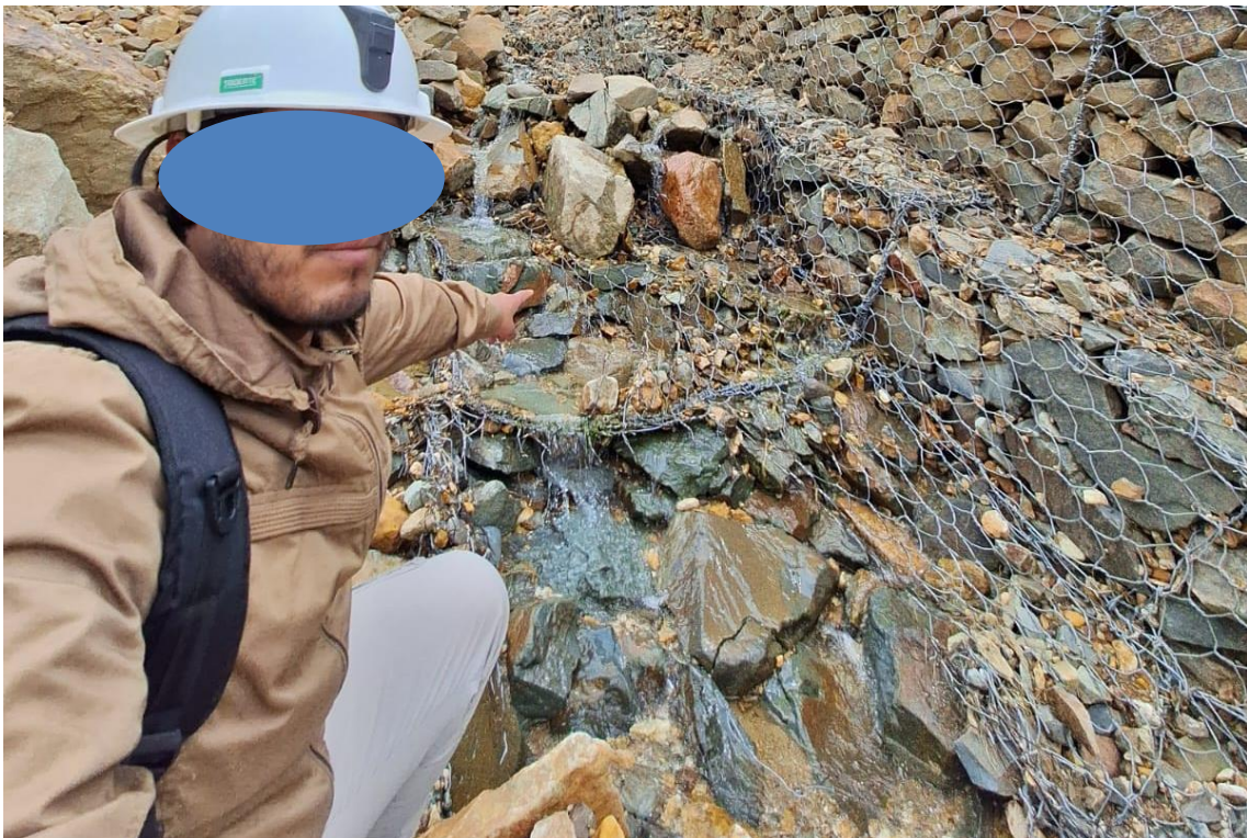
Figura 47: Evaluación del muro de gaviones progresiva 0+900 – 1+000.
