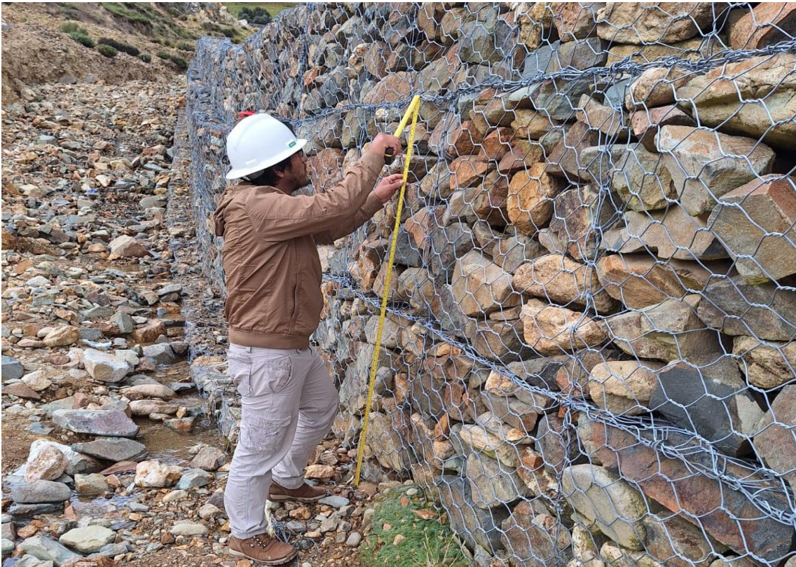
Figura 37: Evaluación del muro de gaviones progresiva 0+300 – 0+400.
