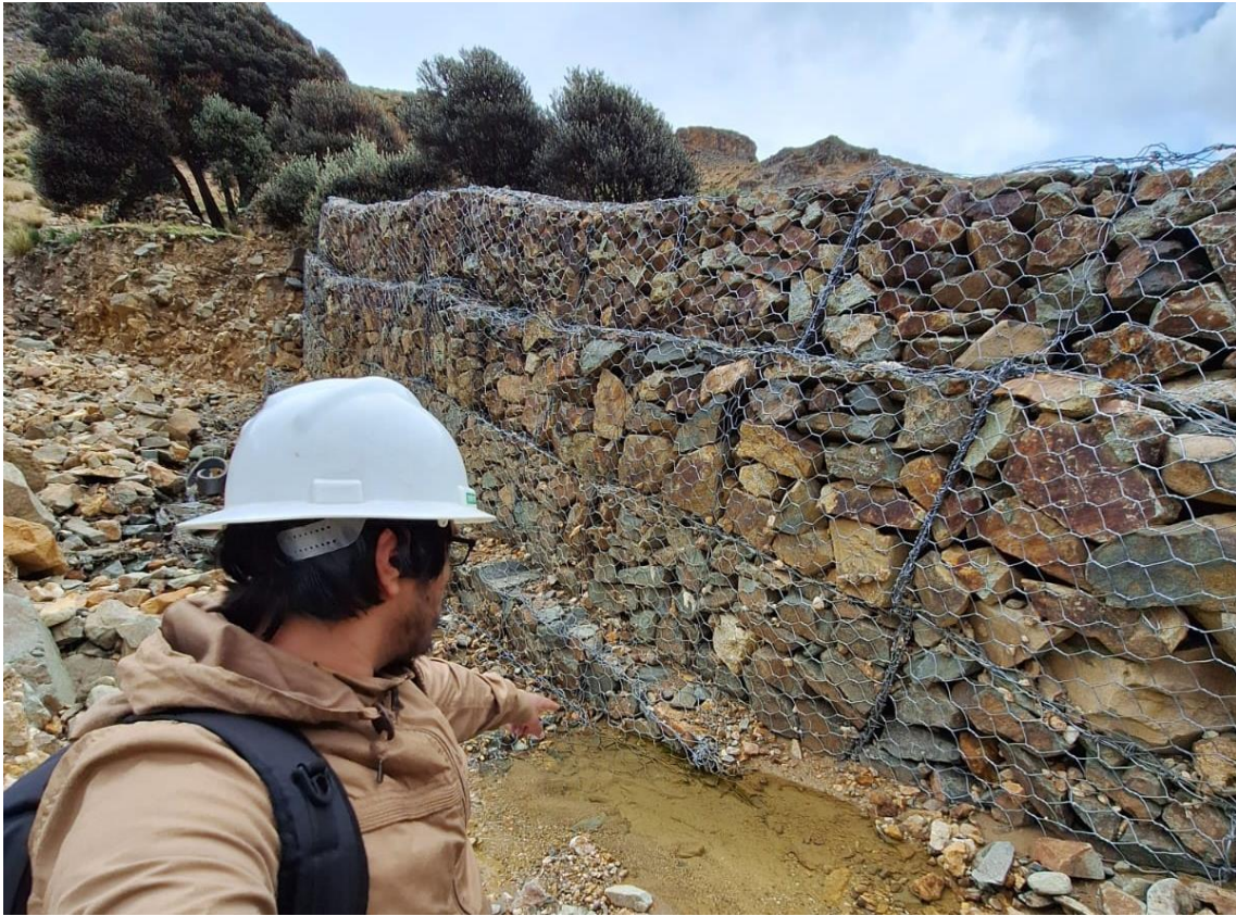
Figura 46: Evaluación del muro de gaviones progresiva 0+900 – 1+000.
