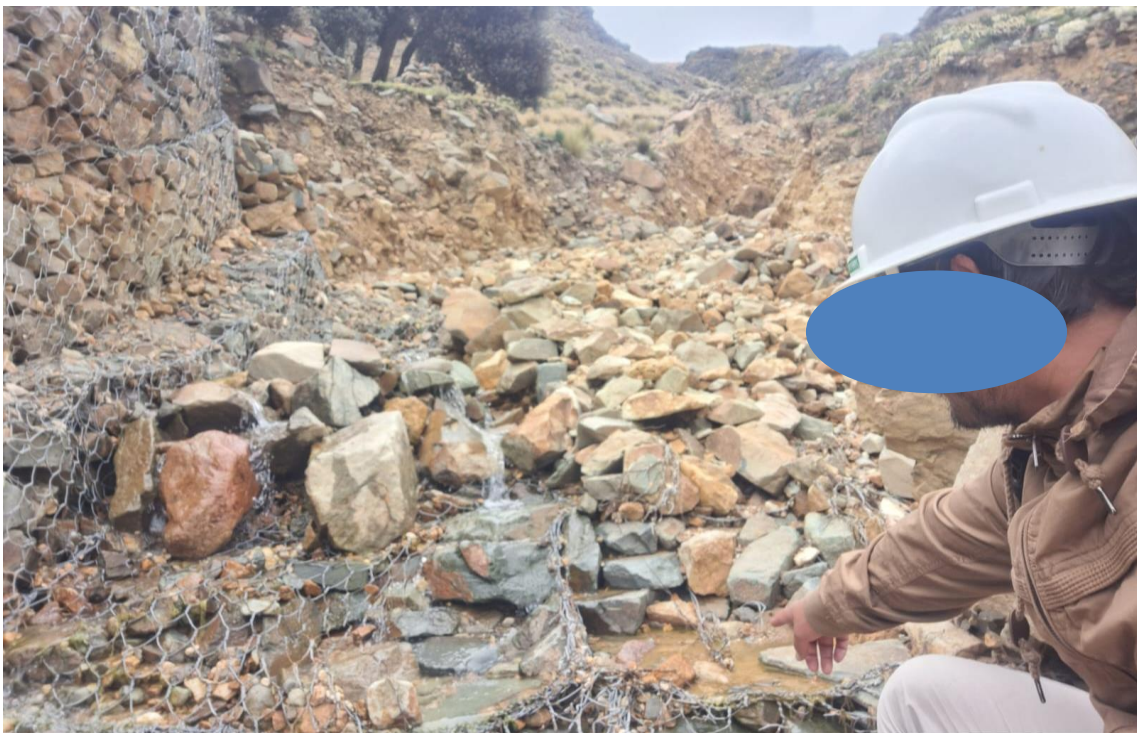
Figura 41: Evaluación del muro de gaviones progresiva 0+700 – 0+800.
