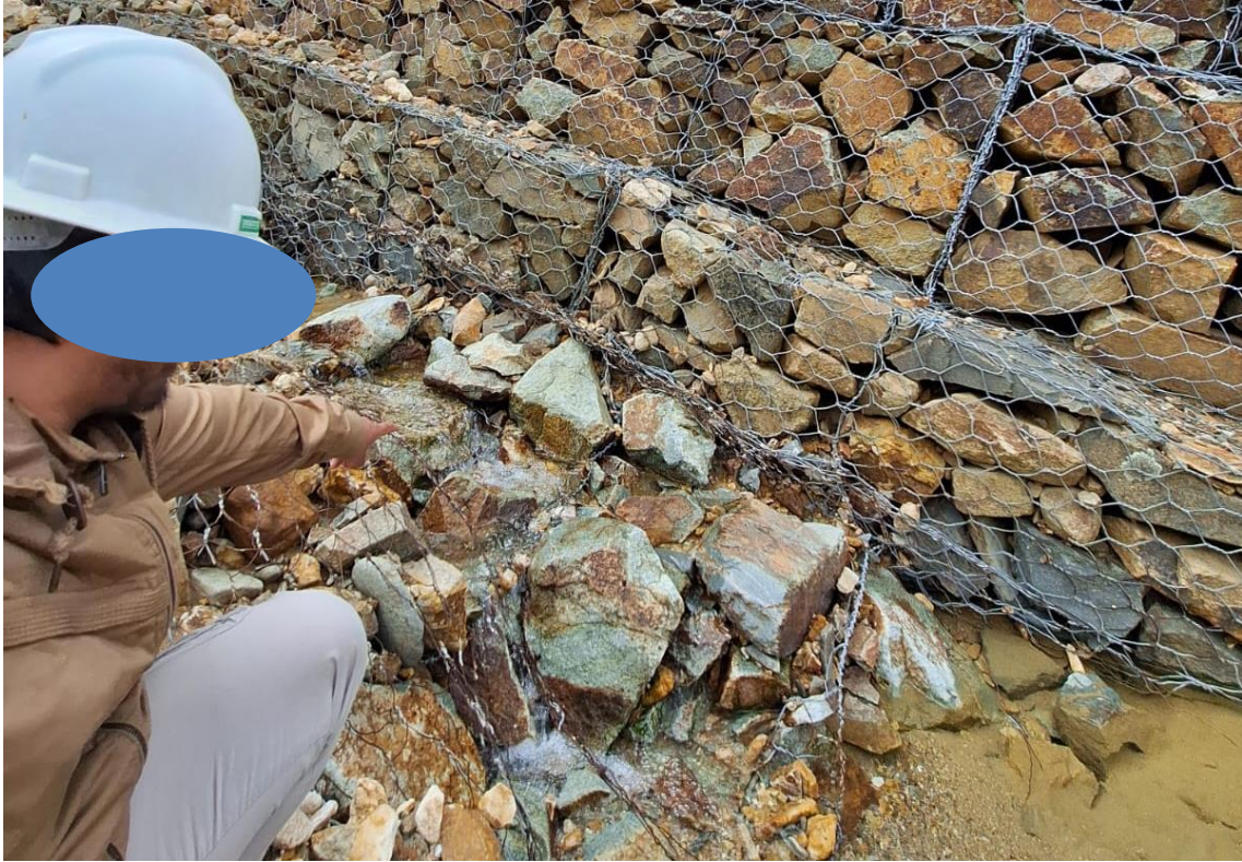
Figura 38: Evaluación del muro de gaviones progresiva 0+400 – 0+500.
