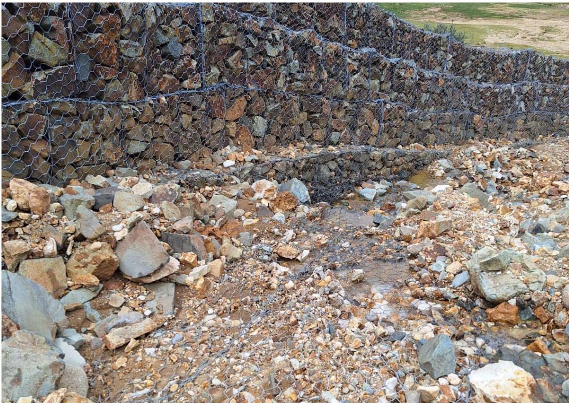
Figura 39: Evaluación del muro de gaviones progresiva 0+500 – 0+600.
