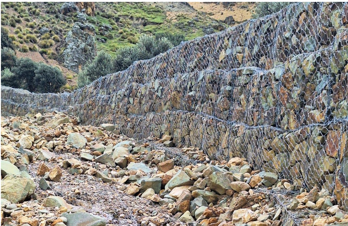
Figura 35: Evaluación del muro de gaviones progresiva 0+100 – 0+200.
