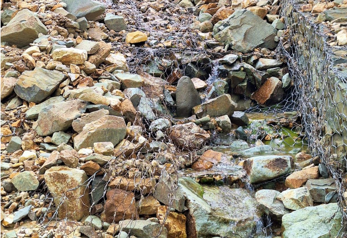
Figura 36: Evaluación del muro de gaviones progresiva 0+200 – 0+300.
