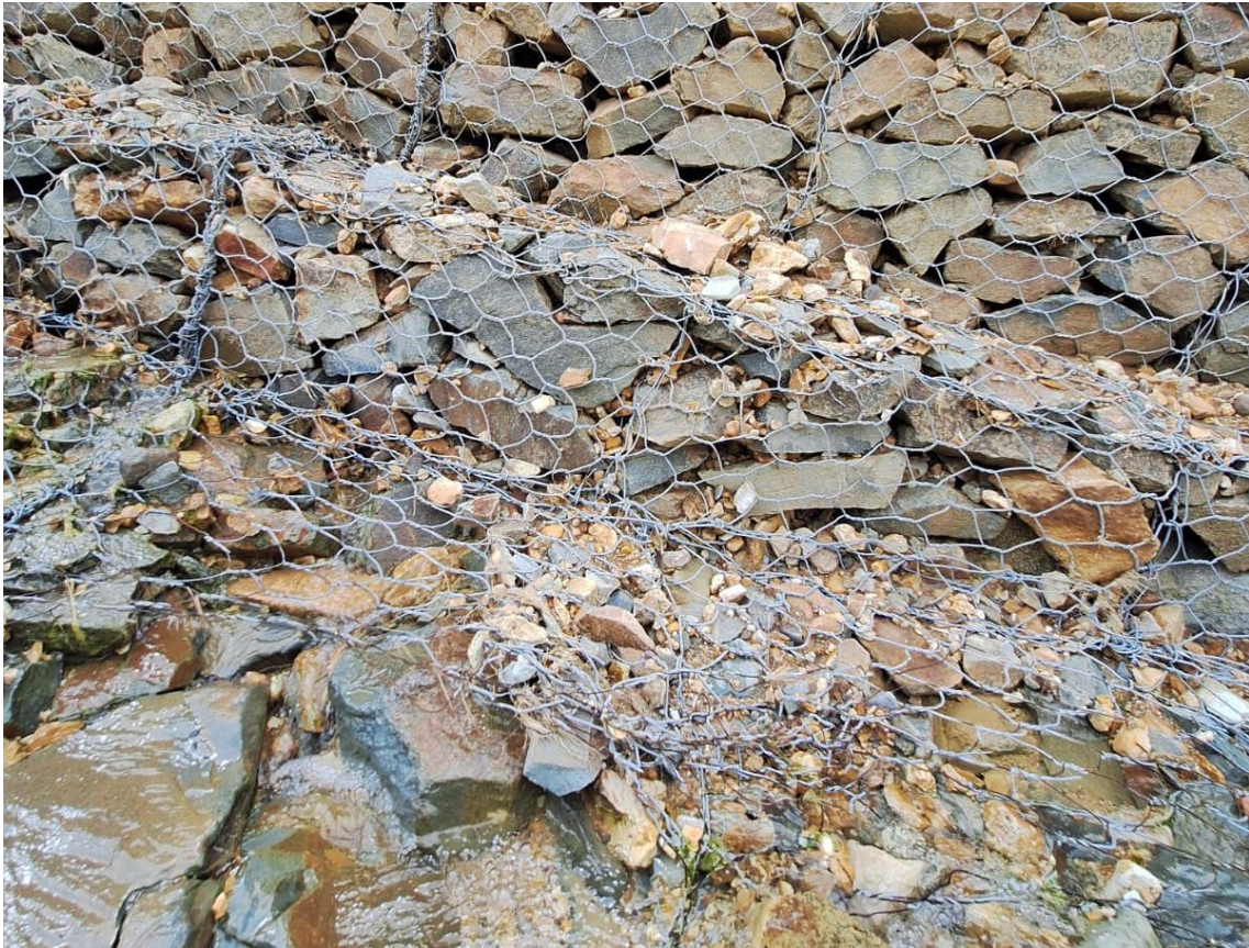
Figura 44: Evaluación del muro de gaviones progresiva 0+800 – 0+900.
