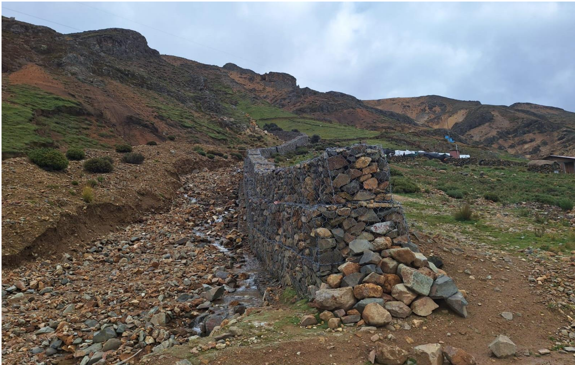
Figura 33: Muro de gaviones del rio Santa Fé.
