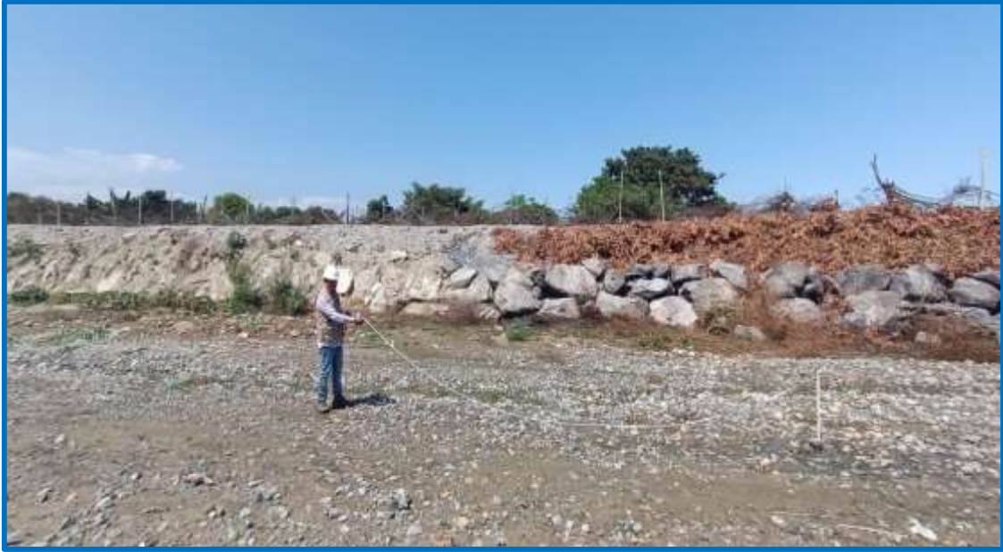
Figura 3. Toma de medida desde la progresiva 0+000 hasta 0+020.
