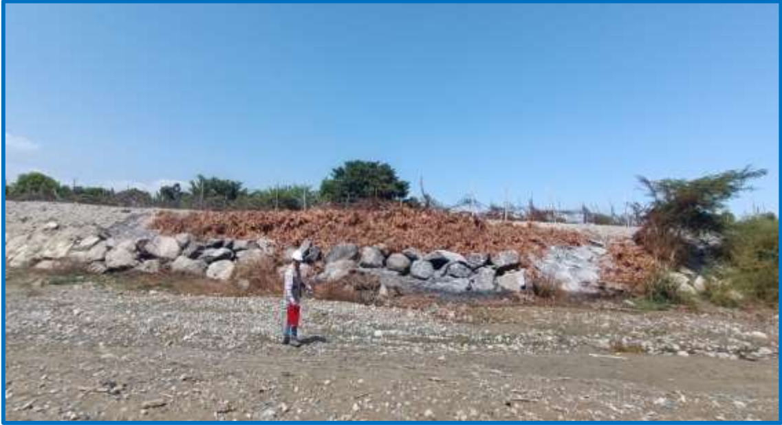
Figura 5. Toma de medida desde la progresiva 0+040 hasta 0+060.
