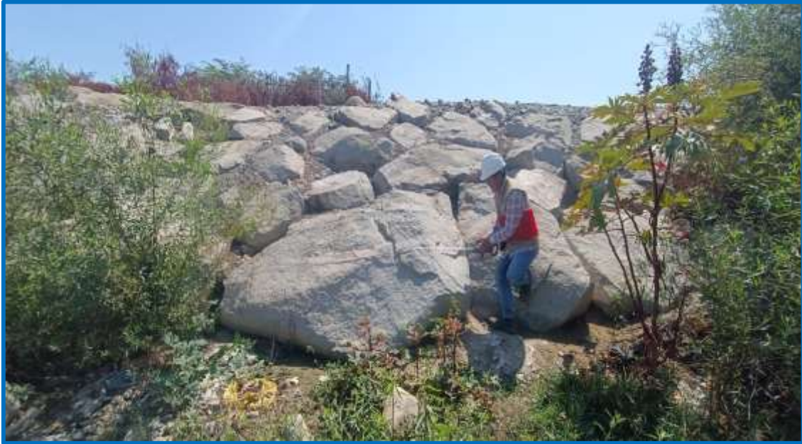
Figura 15. Se observa la toma de medida a las rocas de la defensa ribereña, desde la progresiva 0+100 hasta 0+150.
