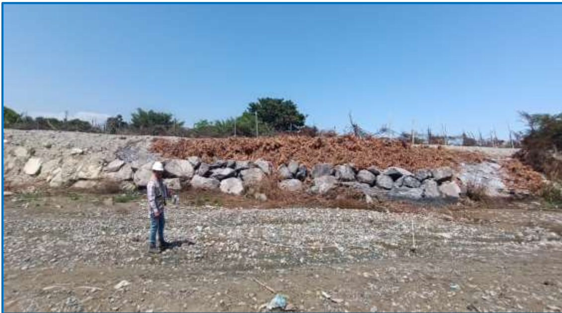
Figura 4. Toma de medida desde la progresiva 0+020 hasta 0+040.
