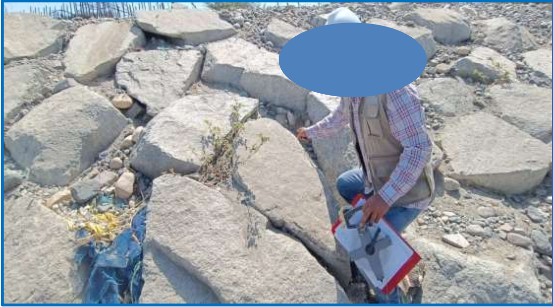
Figura 19. Se observó juntas con grandes espaciamentos desde la progresiva 0+100 hasta 0+190.
