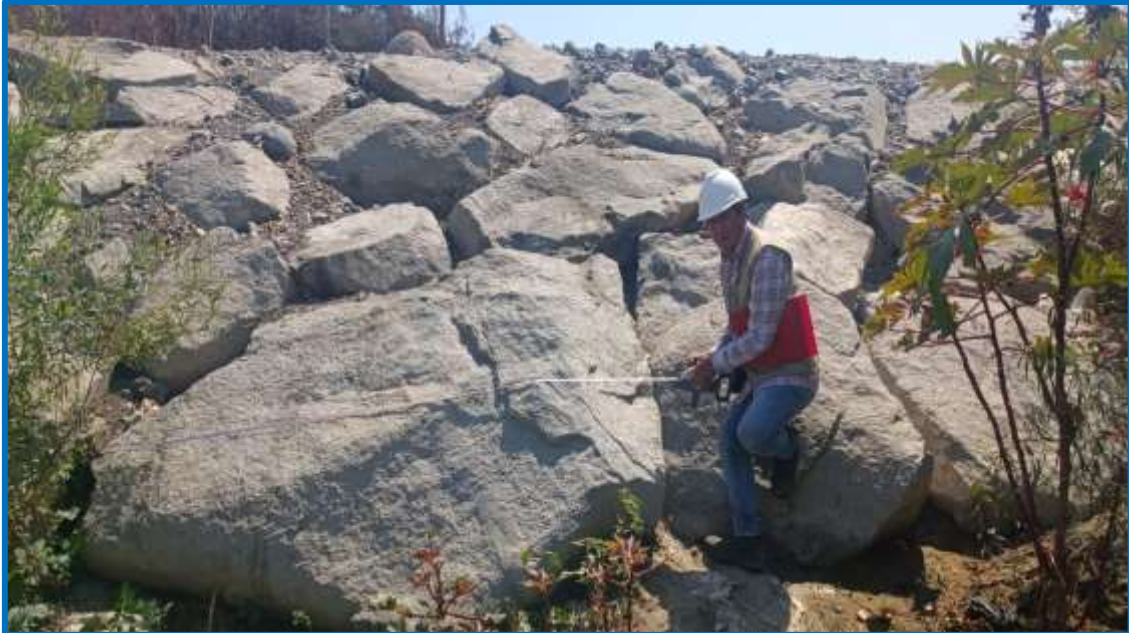
Figura 14. Se observa la toma de medida a las rocas de la defensa ribereña, desde la progresiva 0+050 hasta 0+100.
