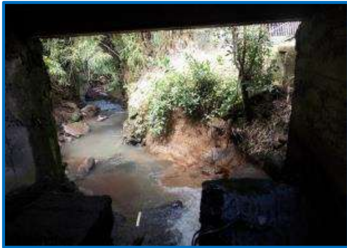
Figura 8. Socavación
