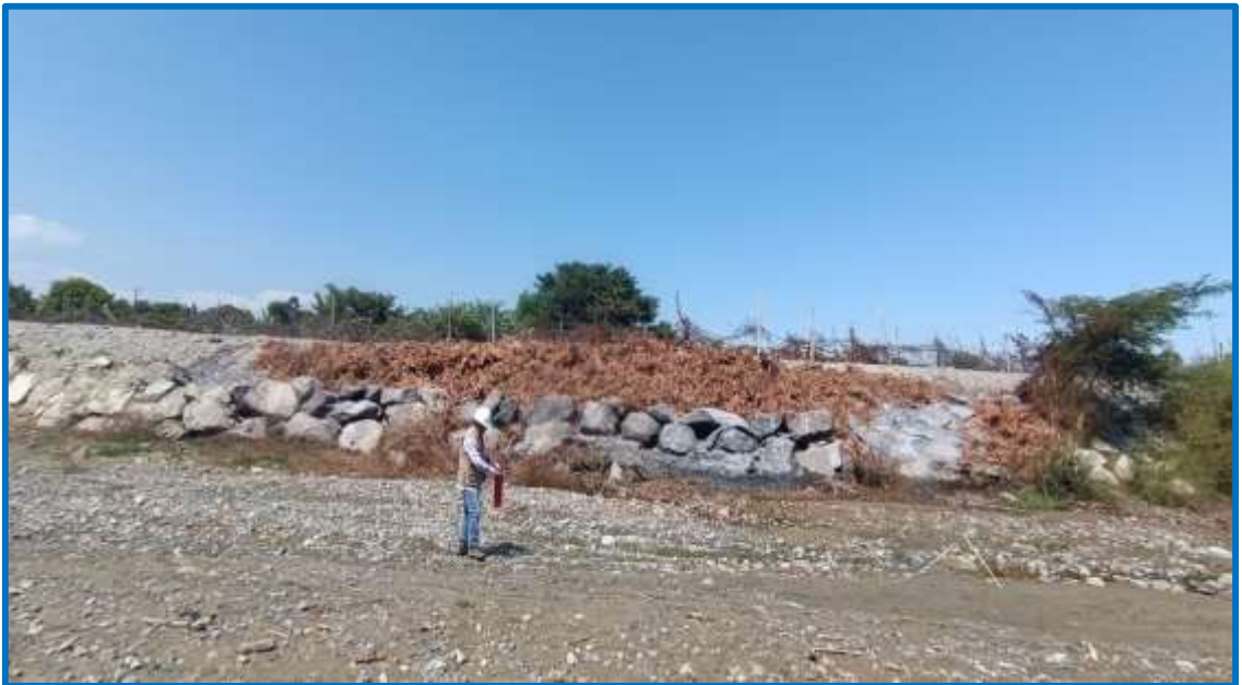
Figura 6. Toma de medida desde la progresiva 0+060 hasta 0+080.
