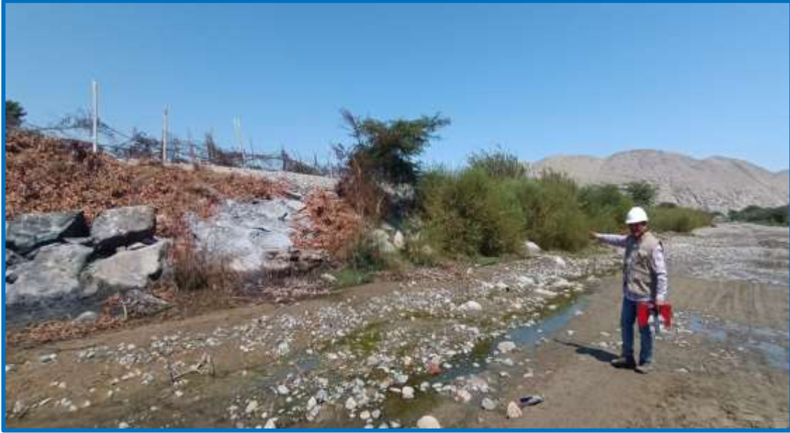
Figura 7. Toma de medida desde la progresiva 0+080 hasta 0+100.
