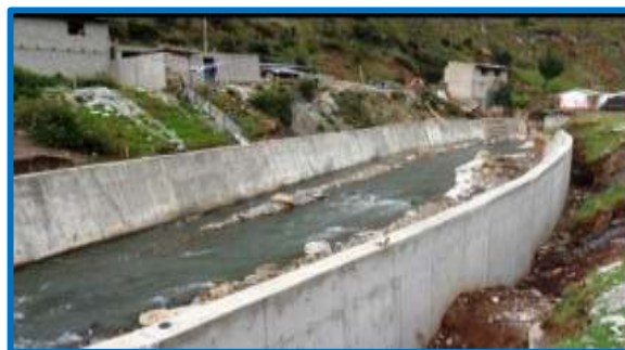
Figura 13. Muro de concreto armado
