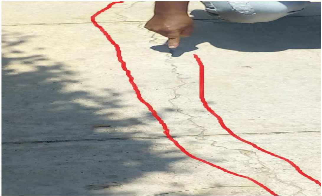
Figura N° 83: Paño del parque de esparcimiento La Chacrita, con la patología Grieta Lineal, con severidad media.
