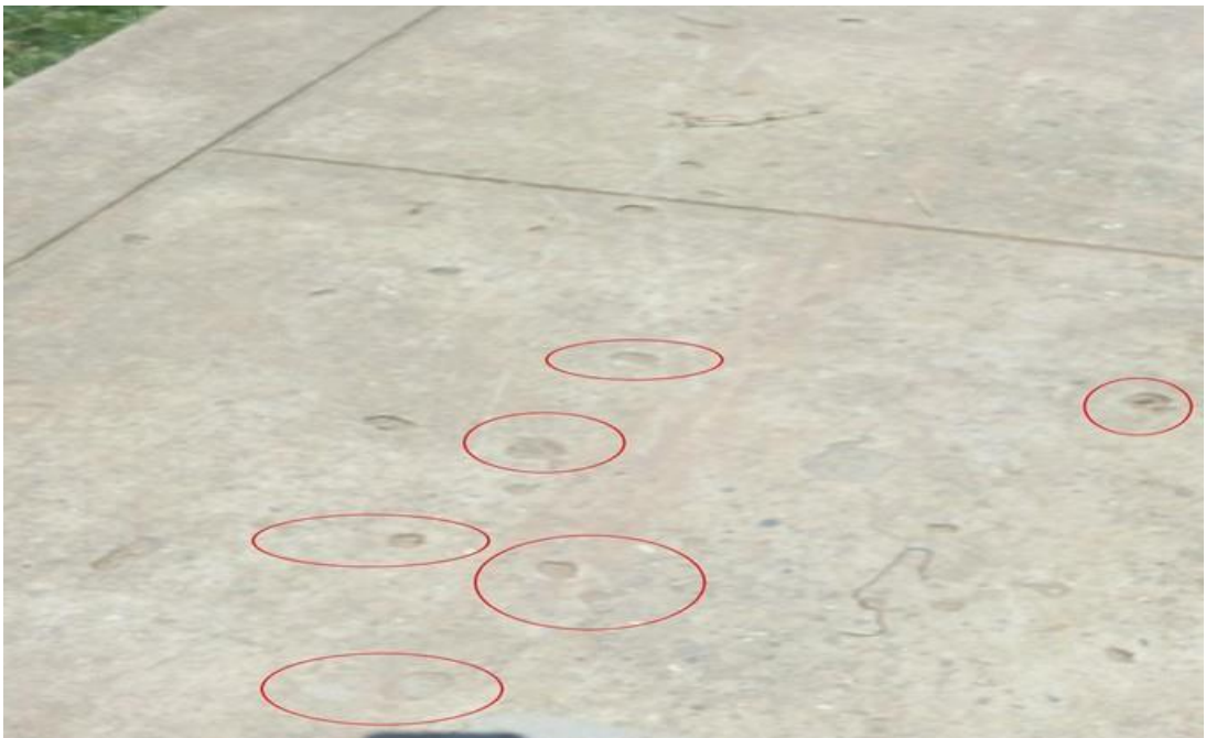
Figura N° 80: Paño de vereda del parque de esparcimiento Roca Fuerte, con la patología Popouts, sin severidad.
