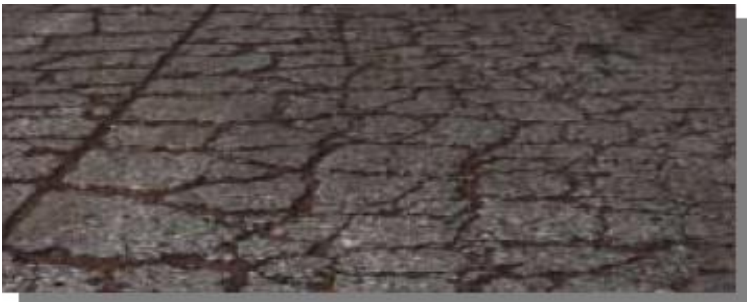
Figura N° 12: Vista típica de un Losa Dividida.
