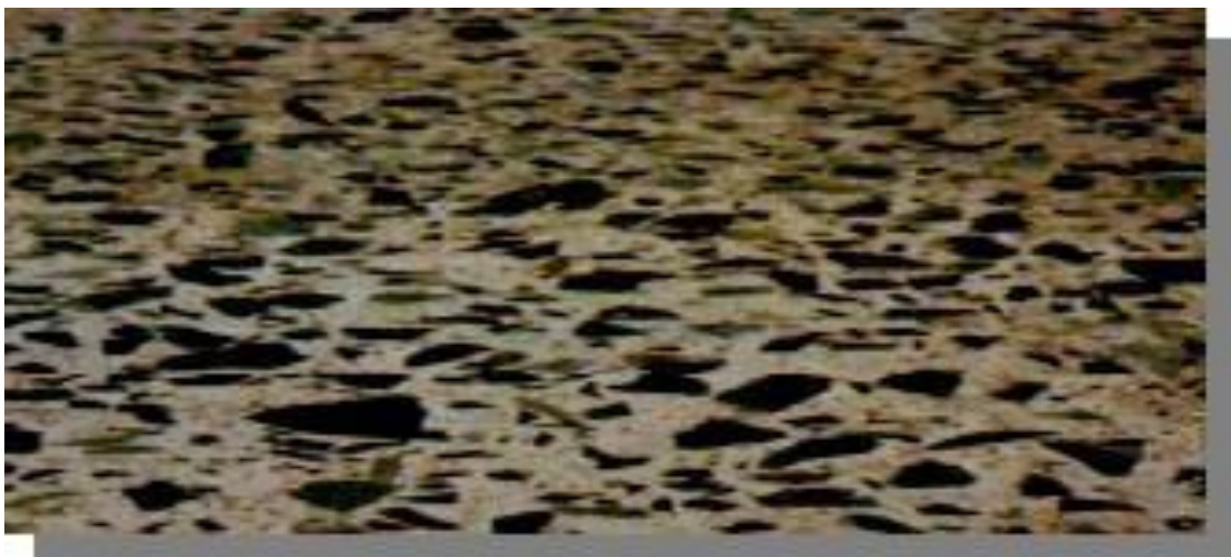
Figura N° 13: Vista típica de Pulimentos de Agregados
