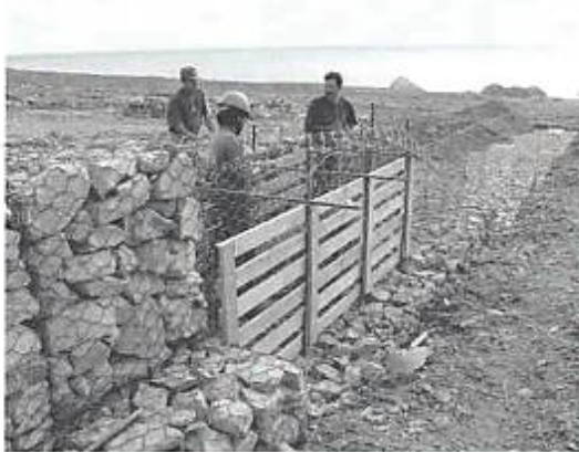
Fig. 5.10 Aplicación de moldajes y fijación de diafragmas
