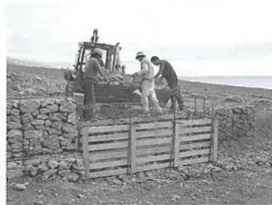
Fig. 5.11 a) y b) Traslado de Material de relleno y llenado
