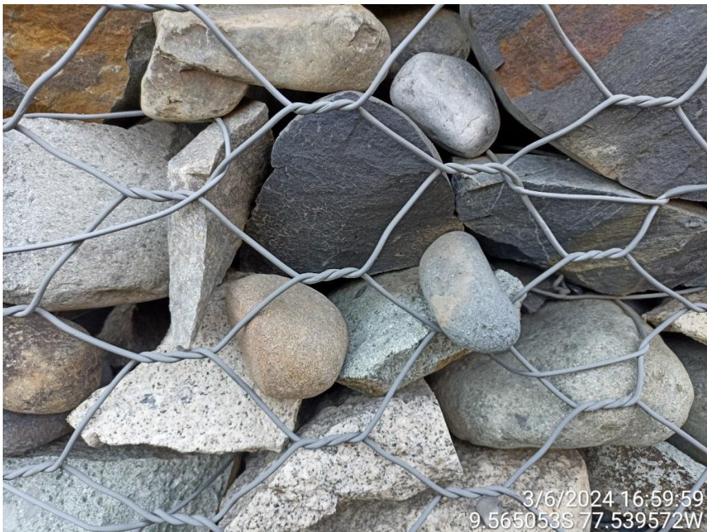
Fotografía 14: Presencia de rocas que no superan el tamaño mínimo y salen por la malla hexagonal, km 0+0+080
