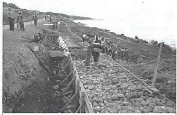
Fig. 5.12 a) y b) y c) Utilización de Moldajes y Geotextil en obra en gaviones
