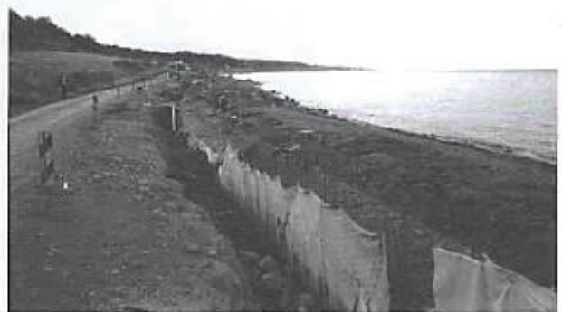
Obra: Protección Camino San Juan. Punta Arenas MOP Vialidad. 2003
