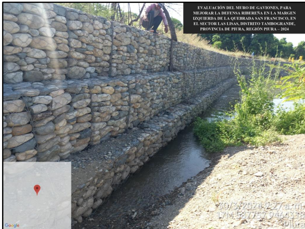
Figura 27: Realizando algunas observaciones sobre el muro de gaviones, elaboración propia, 2024.
