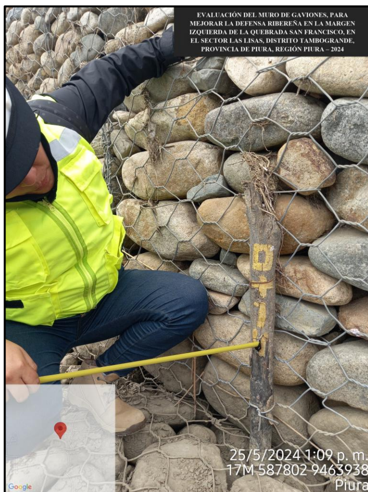
Figura 33: Verificando la progresiva existente del muro de gaviones, elaboración propia, 2024.
