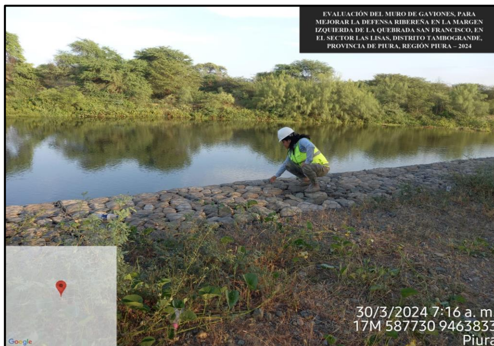
Figura 23: Realizando observaciones sobre el muro de gaviones, elaboración propia, 2024.
