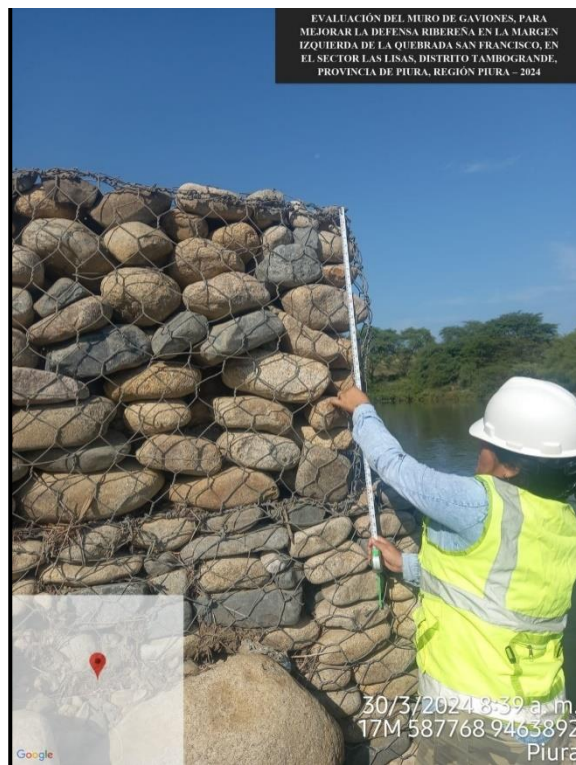
Figura 25: Realizando algunas mediciones sobre el muro de gaviones, elaboración propia, 2024.
