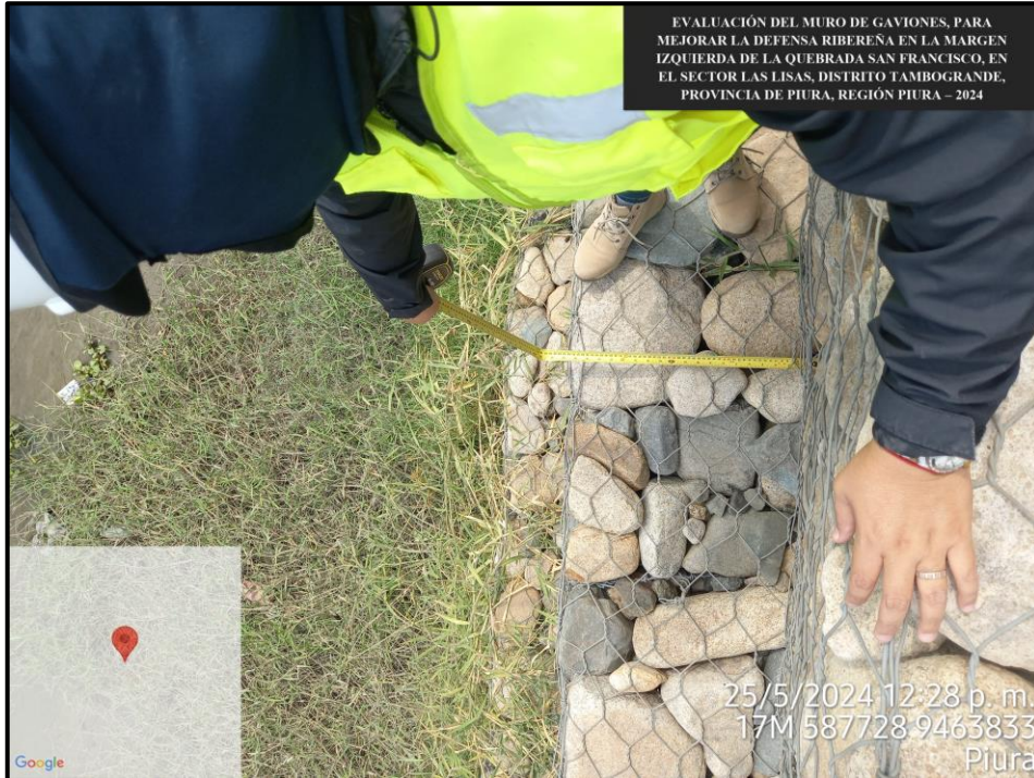
Figura 30: Realizando dimensionamiento de caja del muro de gaviones, elaboración propia, 2024.
