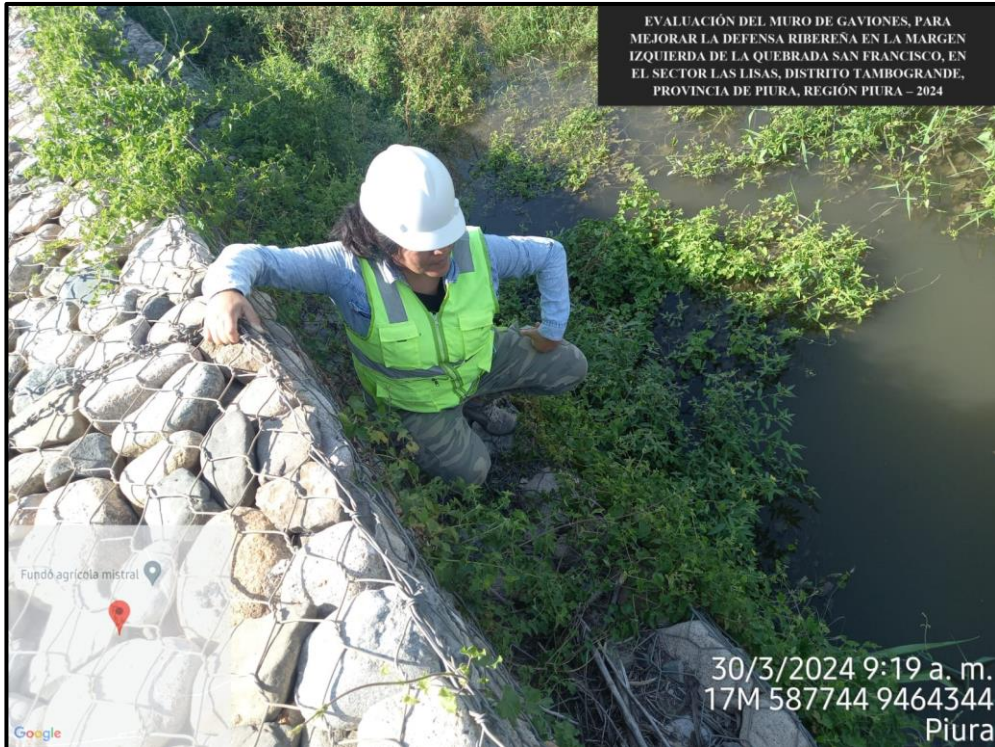
Figura 26: Visualizando las condiciones de maleza que se encuentran sobre el muro de gaviones, elaboración propia, 2024.
