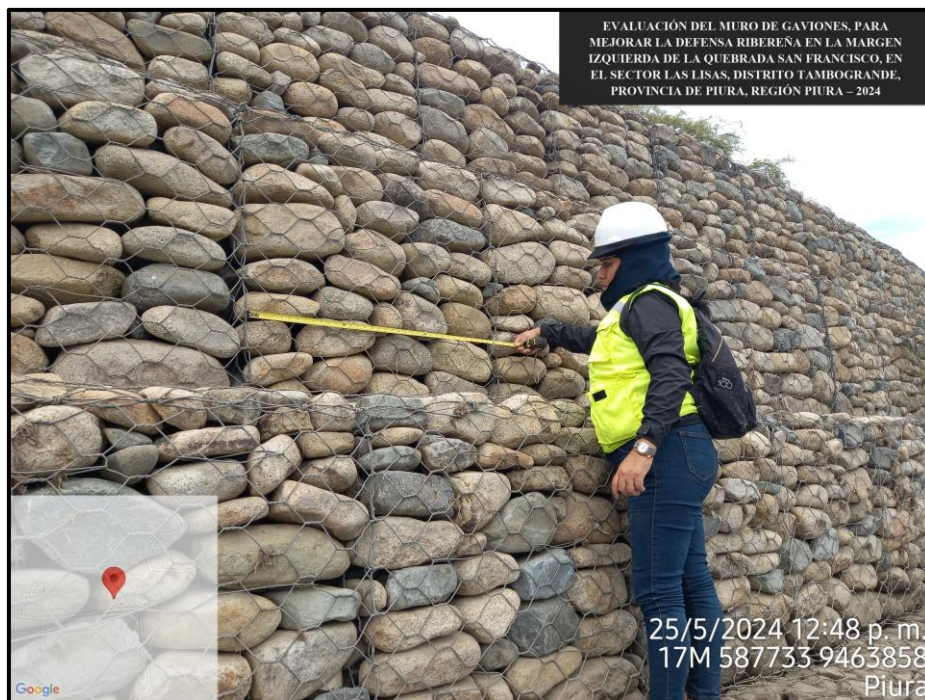
Figura 32: Realizando medida del ancho del muro de gaviones, elaboración propia, 2024.
