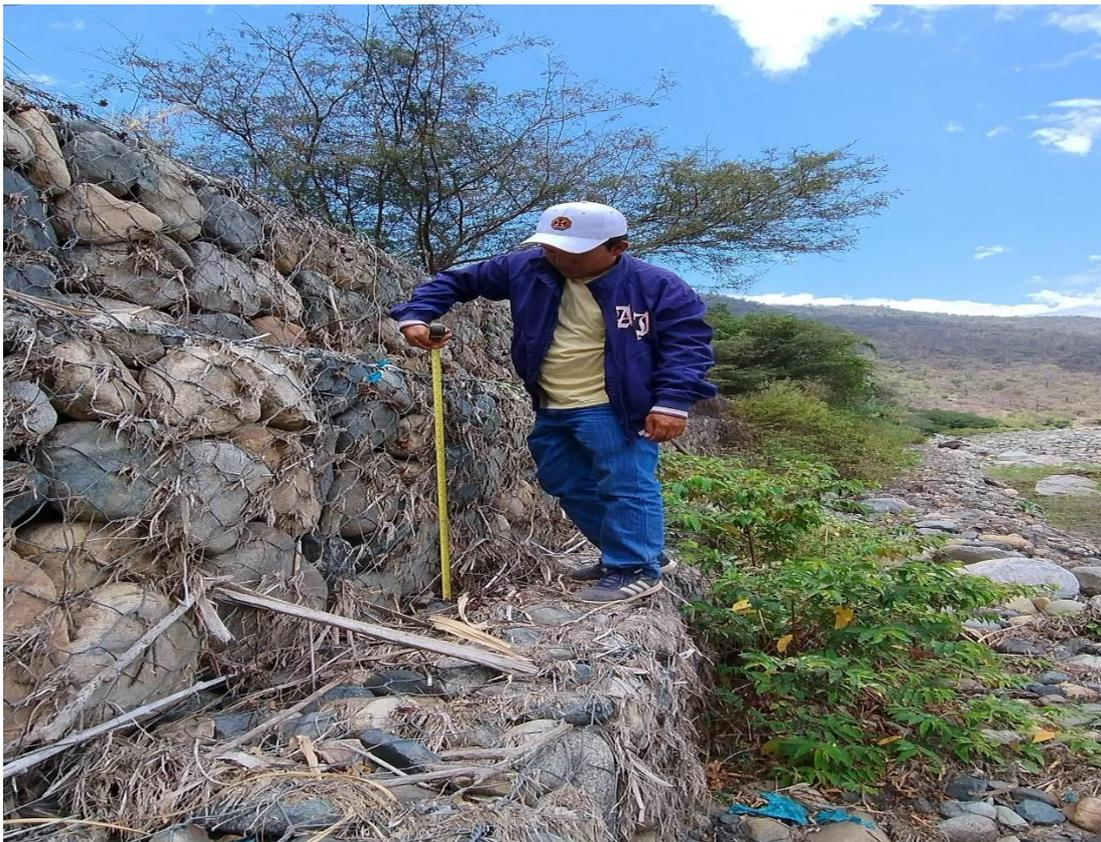
**Fotografía N° 06:** Altura del tercer gavión
