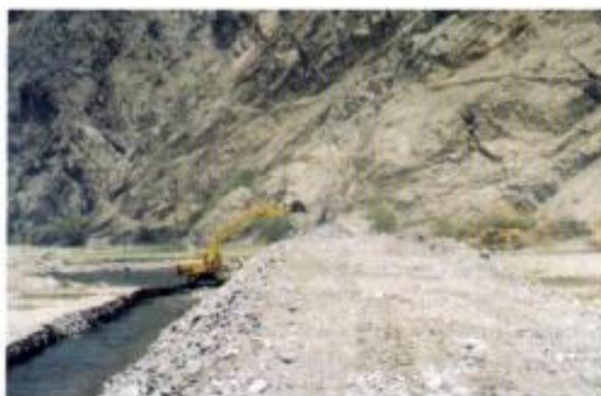
Foto N°4. Tractor iniciando armado de terraplén
