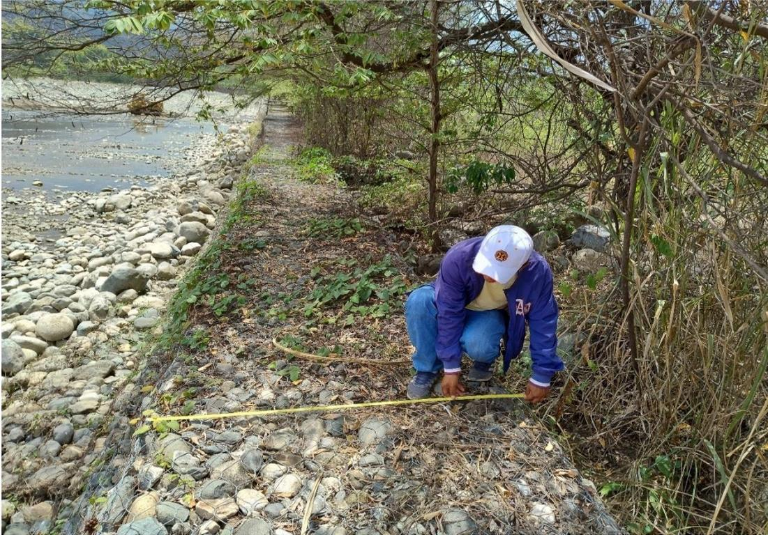
**Fotografía N° 09:** Medición del ancho de la parte superior del muro de gaviones
