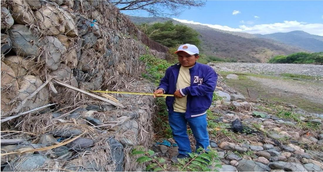
**Fotografía N° 05:** Medición del ancho del gavión
