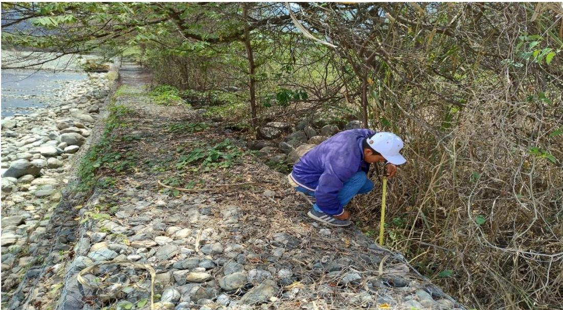
**Fotografía N° 10:** Medición de la altura del muro por la parte posterior
