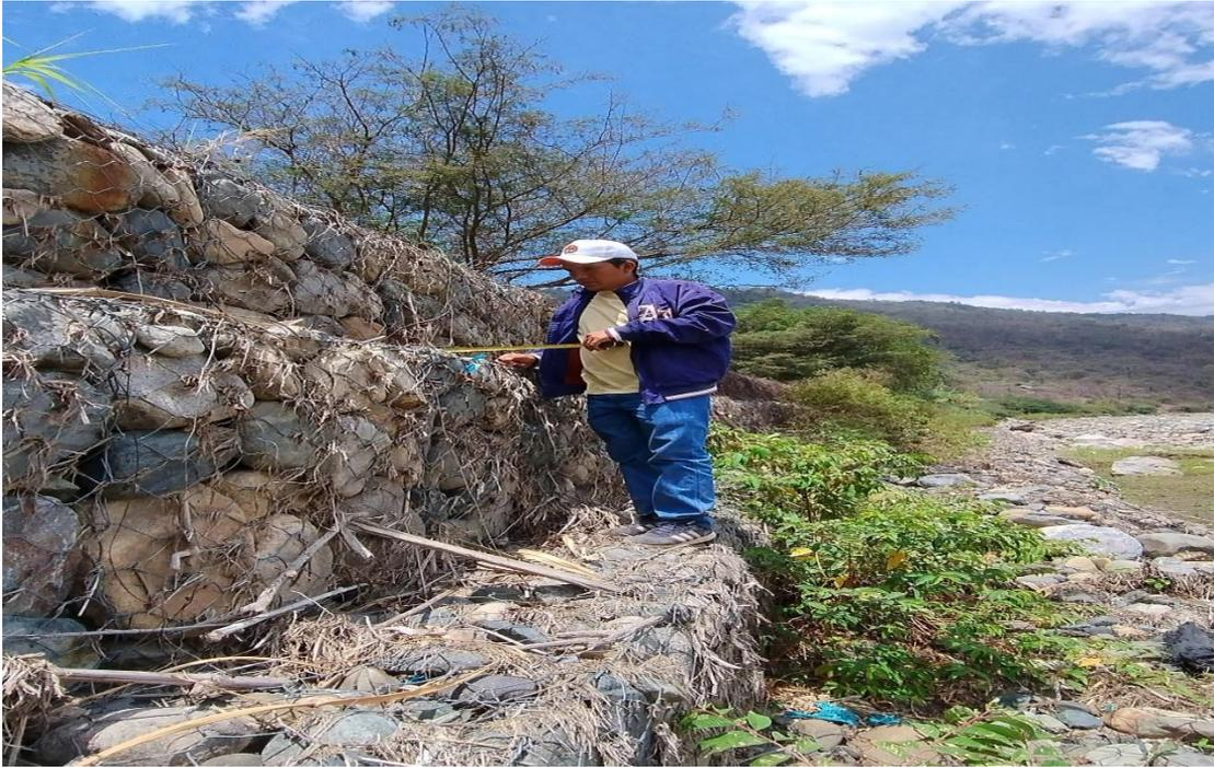
**Fotografía N° 07:** Medición del ancho del tercer gavión
