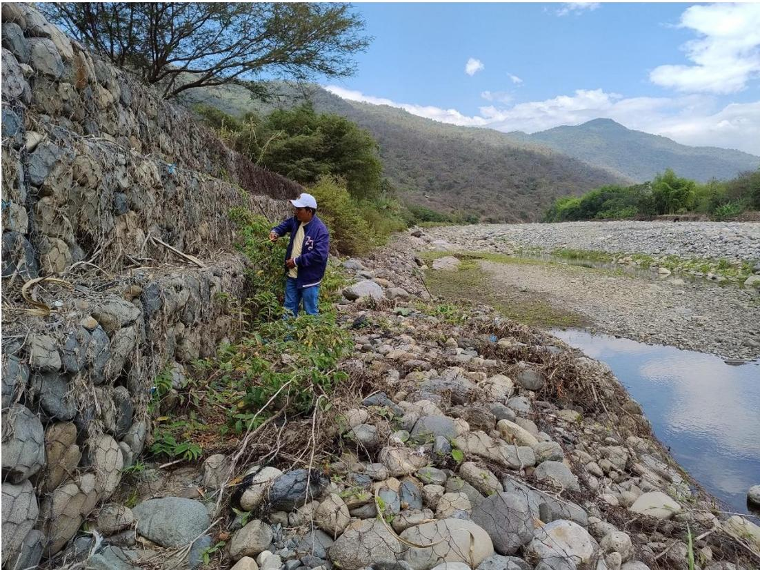
**Fotografía N° 04:** Medición del ancho del gavión
