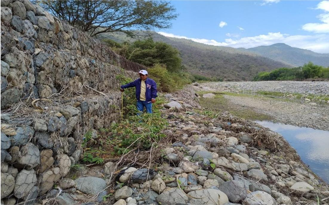
**Fotografía N° 03:** Medición de la altura del gavión
