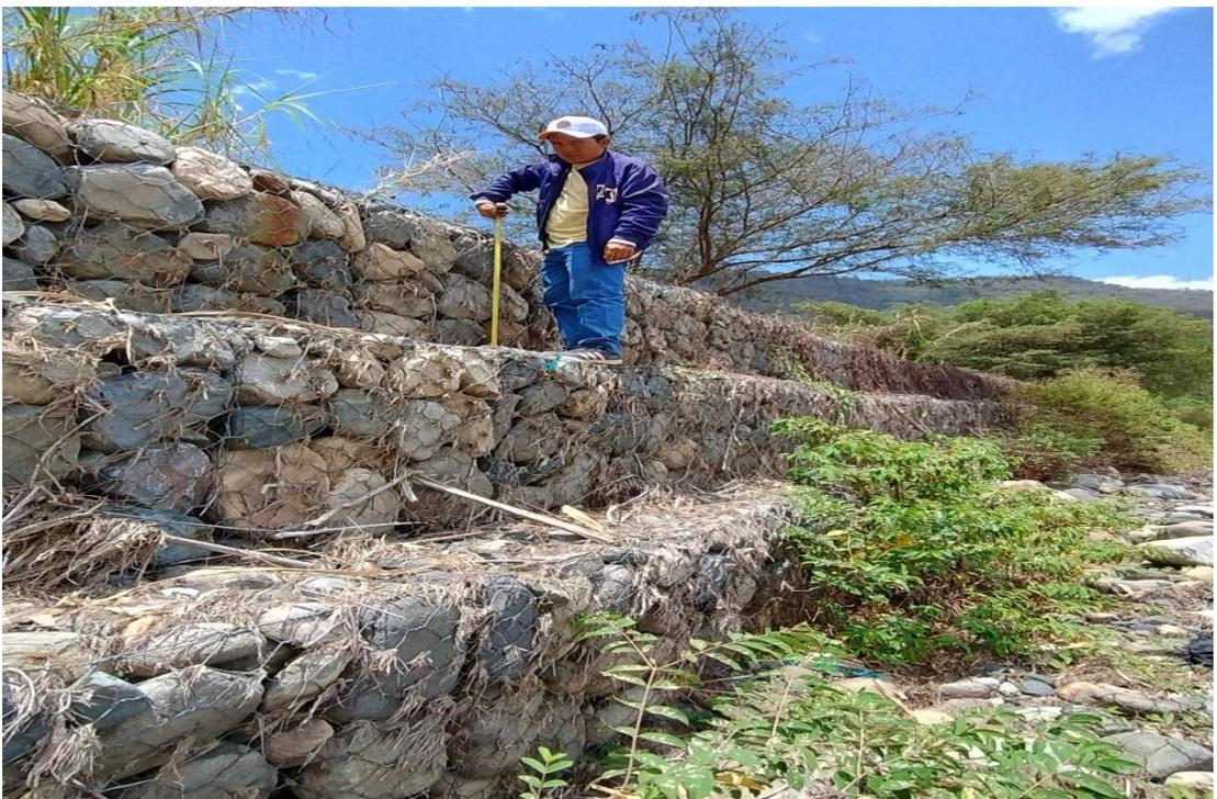
**Fotografía N° 08:** Medición de la altura del cuarto gavión
