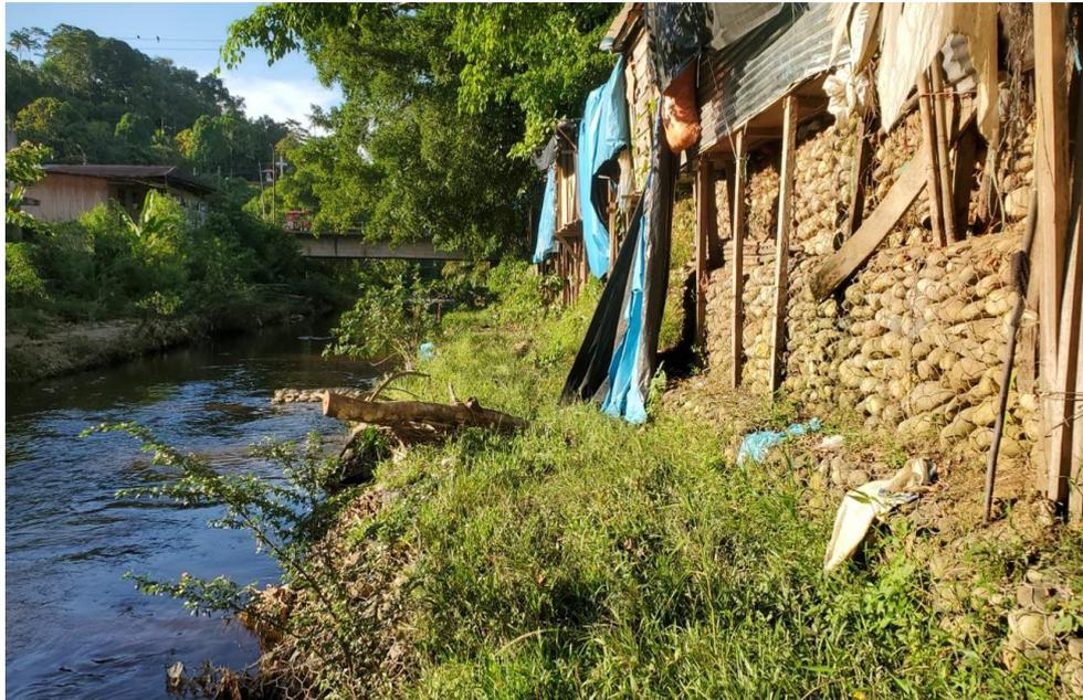
Figura 8: Encontramos una vivienda construida encima del muro de gaviones
