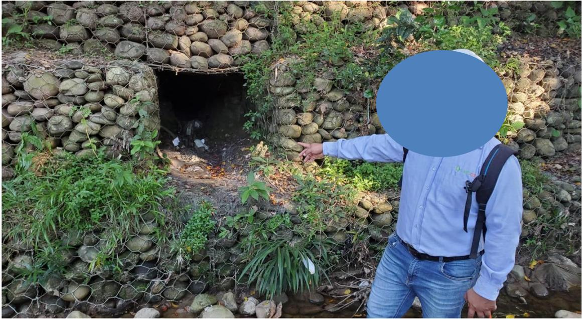
Figura 11: Encontramos un punto de vacío en el muro de gaviones
