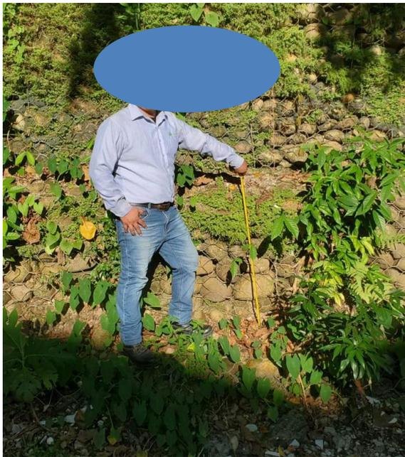
Figura 2: Medición de la altura del cajón del muro de gaviones
