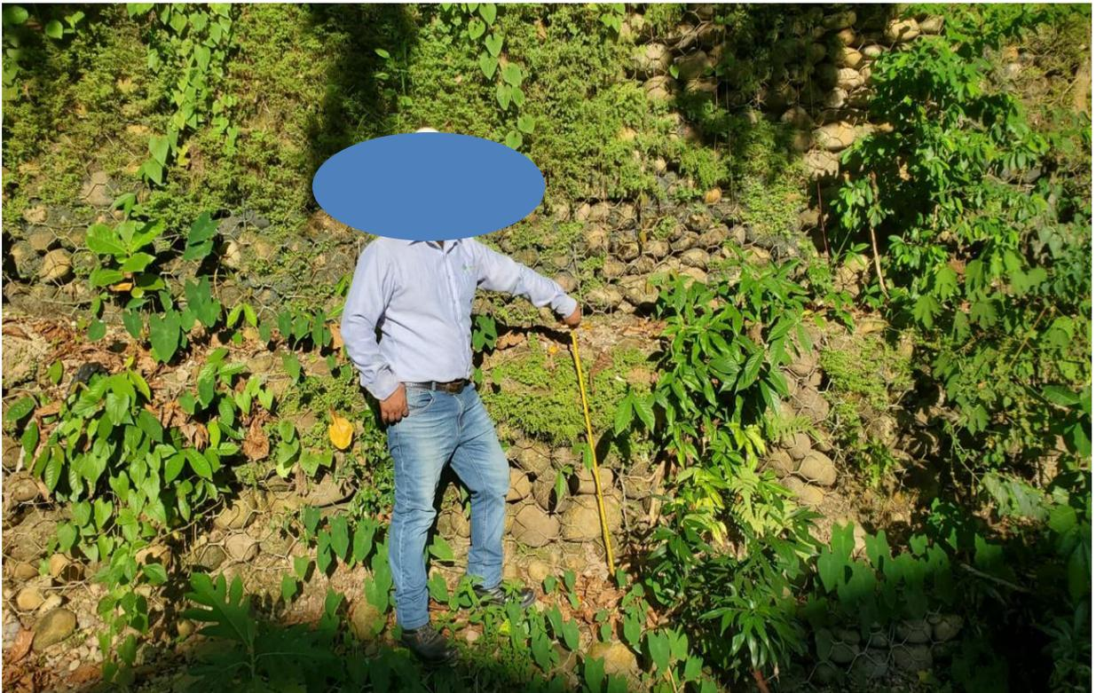
Figura 4: Verificación de la altura de la hilada
