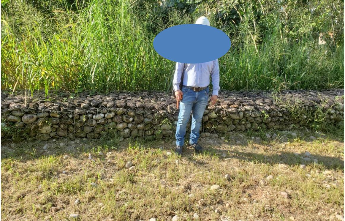
Figura 15: Ultima hilada del muro de gaviones
