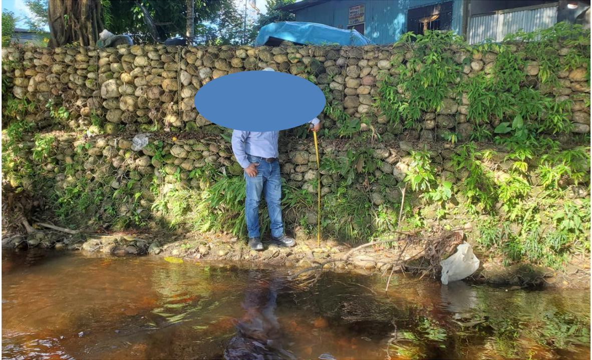
Figura 17: Verificando la altura de cada cajón del muro de gaviones
