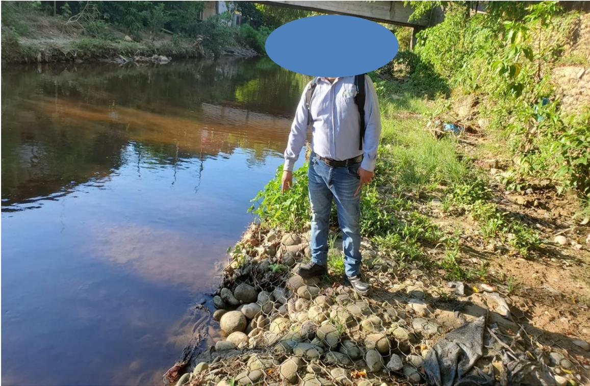
Figura 7: Cuenta con una base de muro de colchón los muro de gaviones
