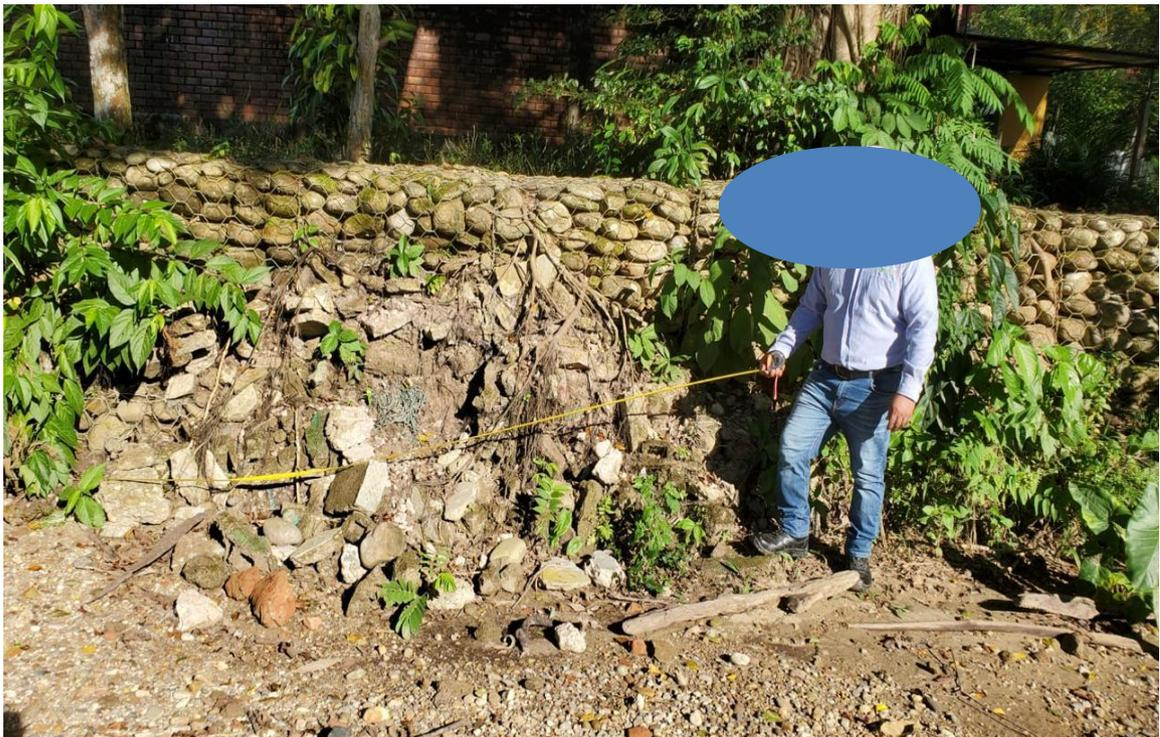
Figura 18: Verificando la longitud de cada cajón del muro de gaviones
