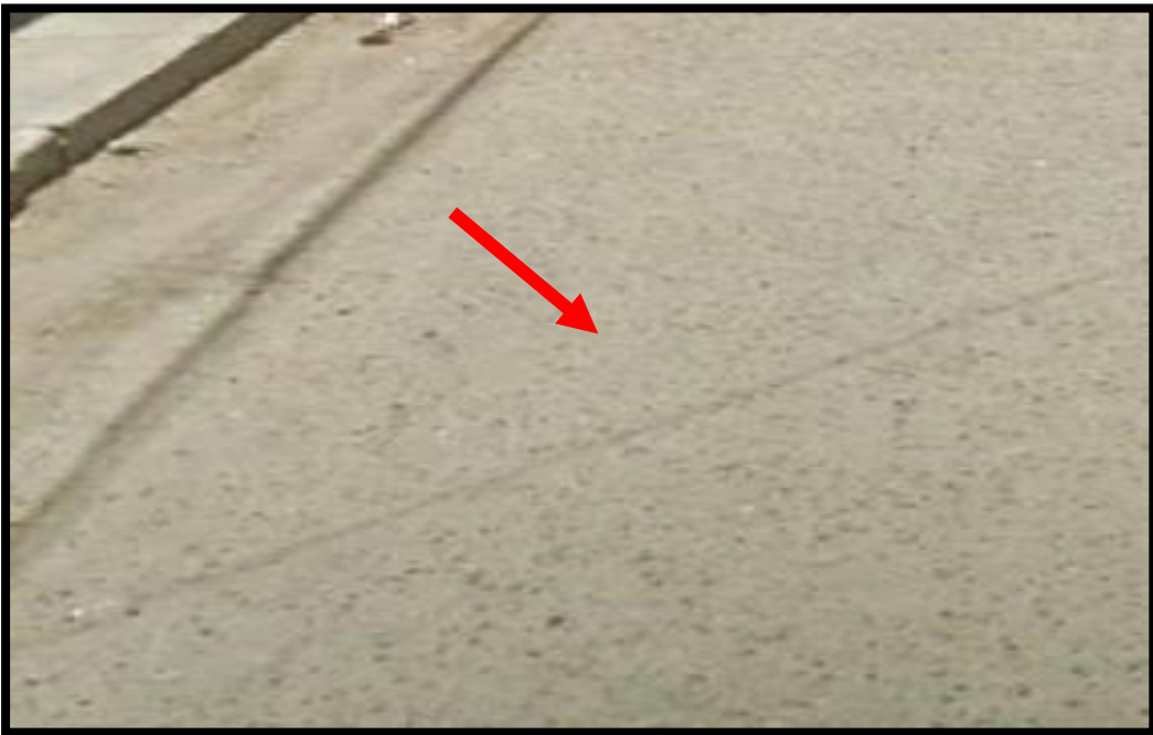
Grafico N° 52: Presentación de peladura por intemperismo de media severidad. Fuente: Propia.
