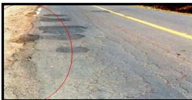
Gráfico N° 13: Fisuras de borde.
