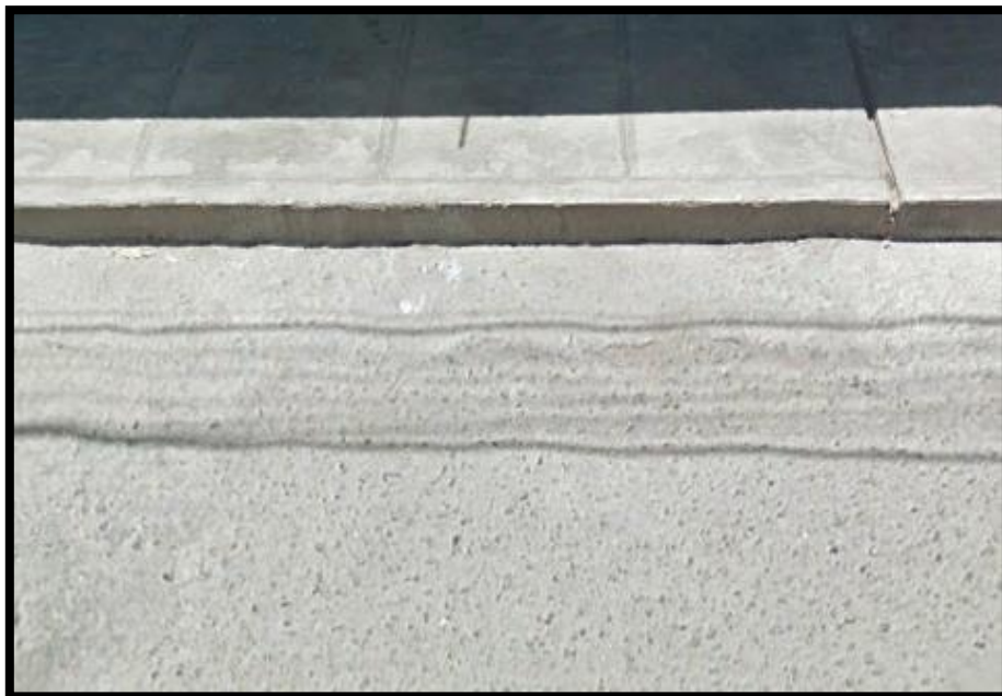
Gráfico N° 63: Calzada con falla de corrugación.
