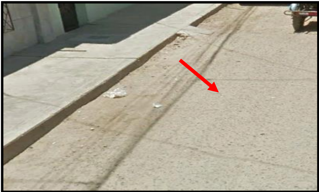
Grafico N° 48: Presentación de peladura por intemperismo de media severidad. Fuente: Propia.
