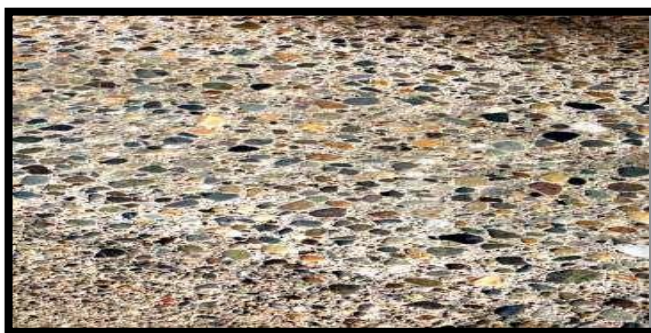
Gráfico N° 27: Agregado Pulido.
