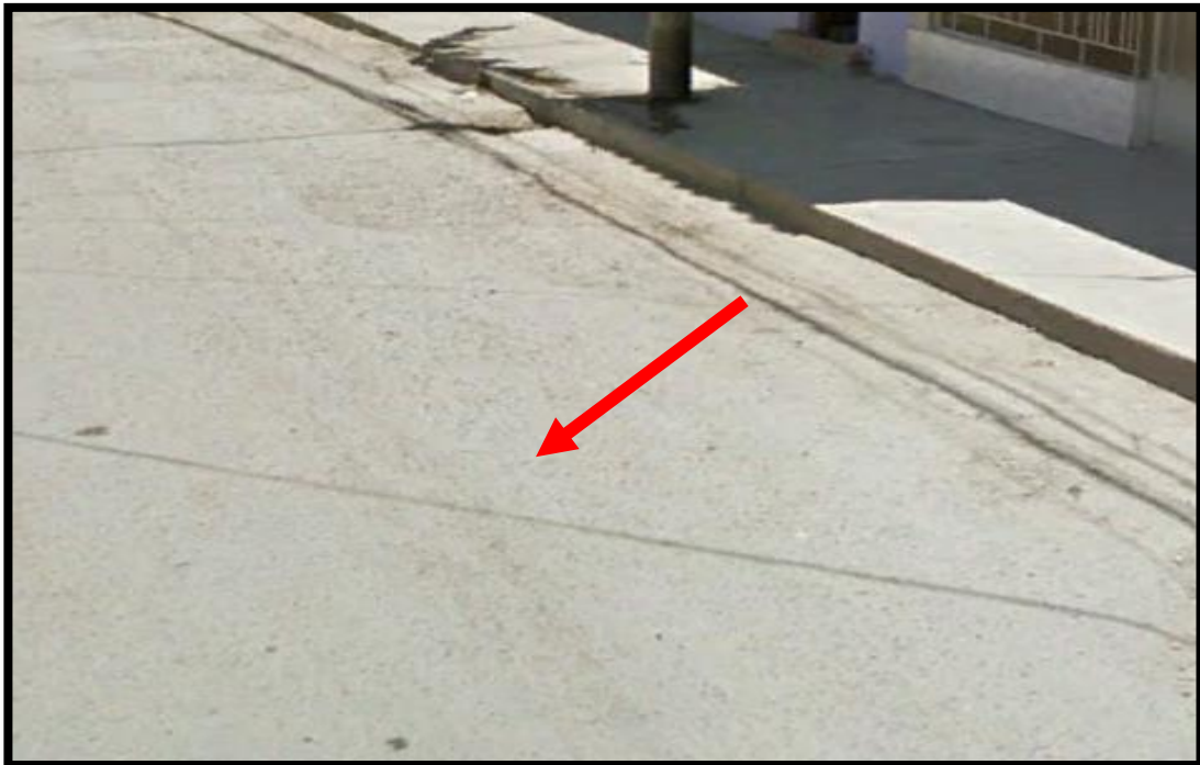
Gráfico N° 34: Presentación de ahuellamiento de severidad media.
