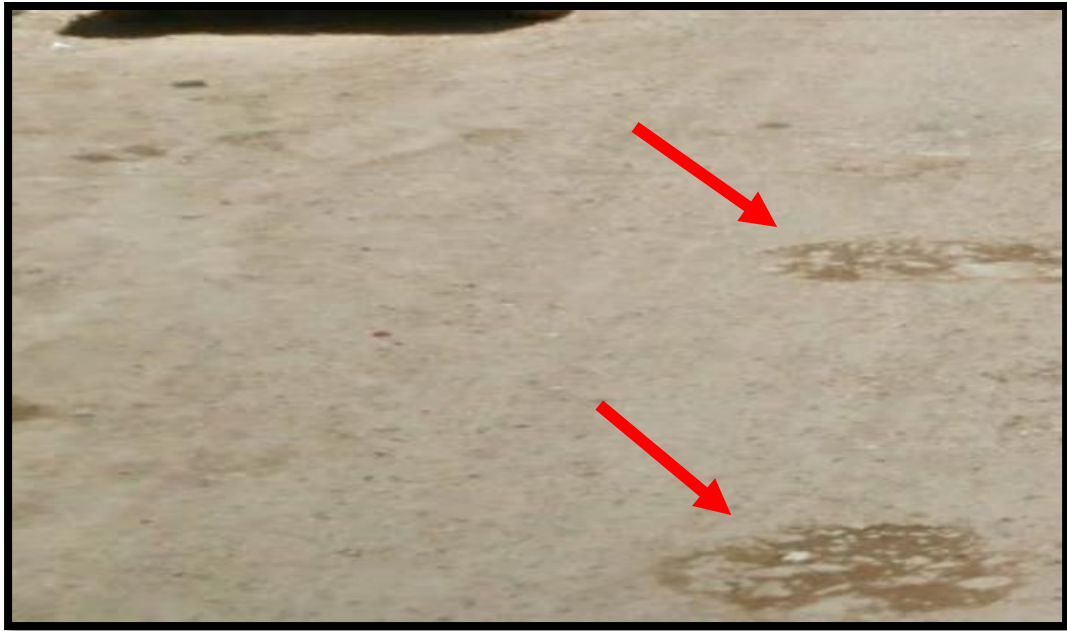
Grafico N° 47: Presentación de baches de baja y media severidad. Fuente: Propia.
