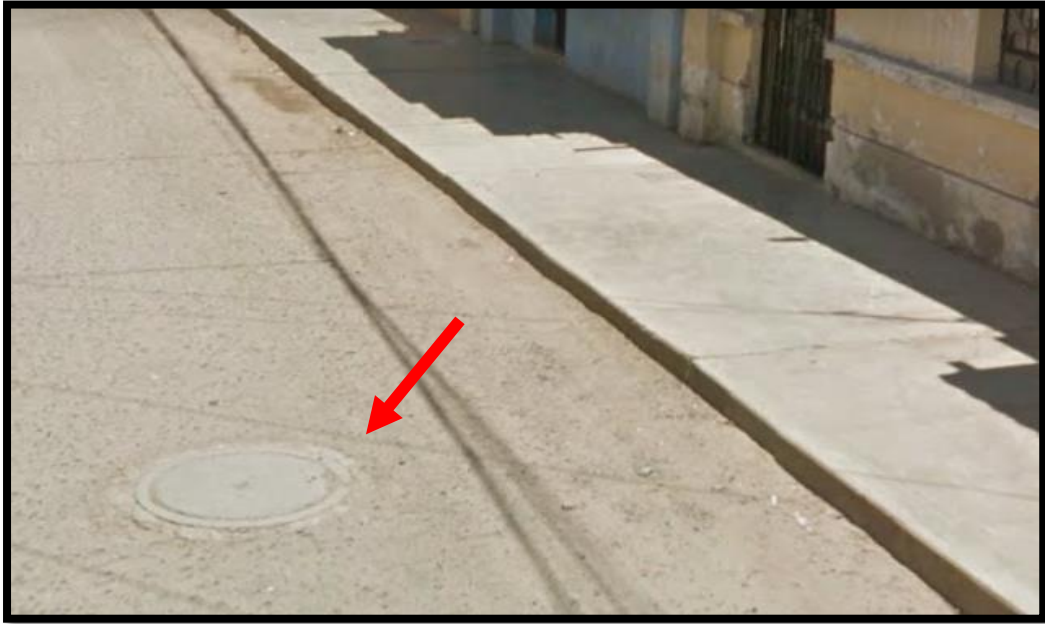
Grafico N° 51: Presentación de parche de corte utilitario de media severidad. Fuente: Propia.
