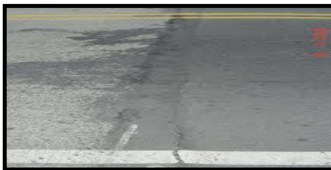
Gráfico N° 15: Fisura transversal.
