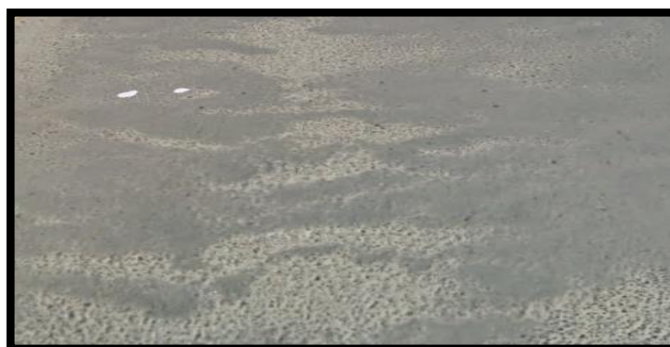
Gráfico N° 17: Abultamientos y hundimientos.
