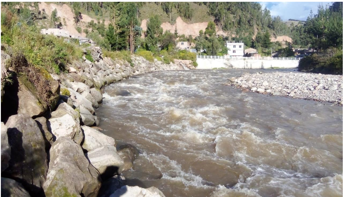
Figura 11: 50 metros lineales de enrocado
