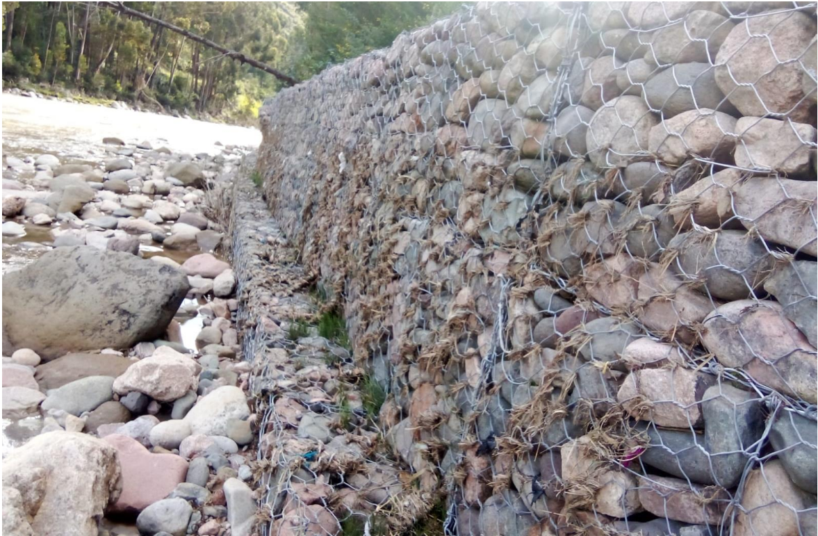
Figura 13: Vegetación en el muro de gavión
