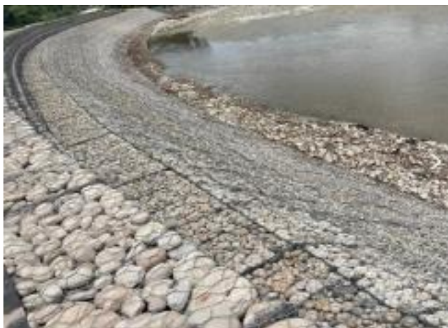
Figura 4: Muro de gavión tipo colchón
