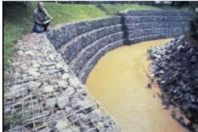
Figura 2: Muro de gaviones
