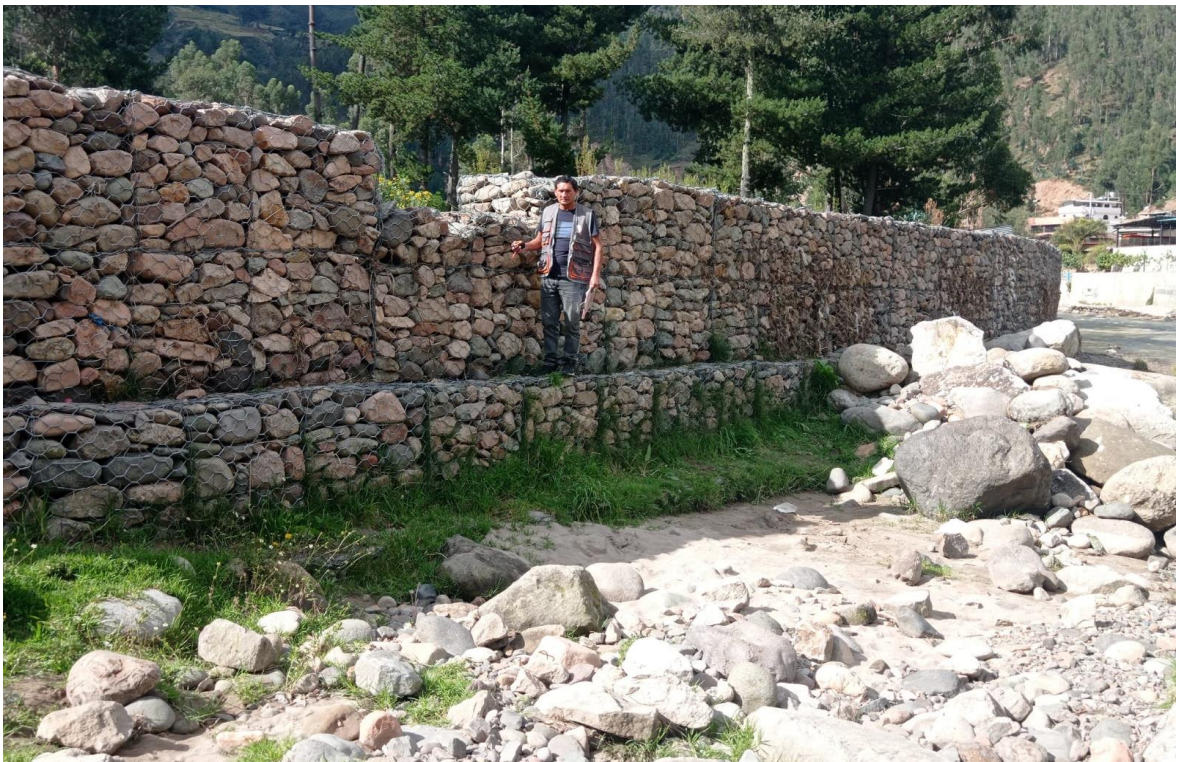
Figura 18: Abertura del muro de gavión
