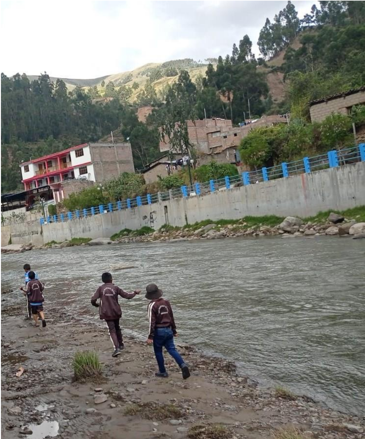
Figura 12: Muro de contención margen derecho
