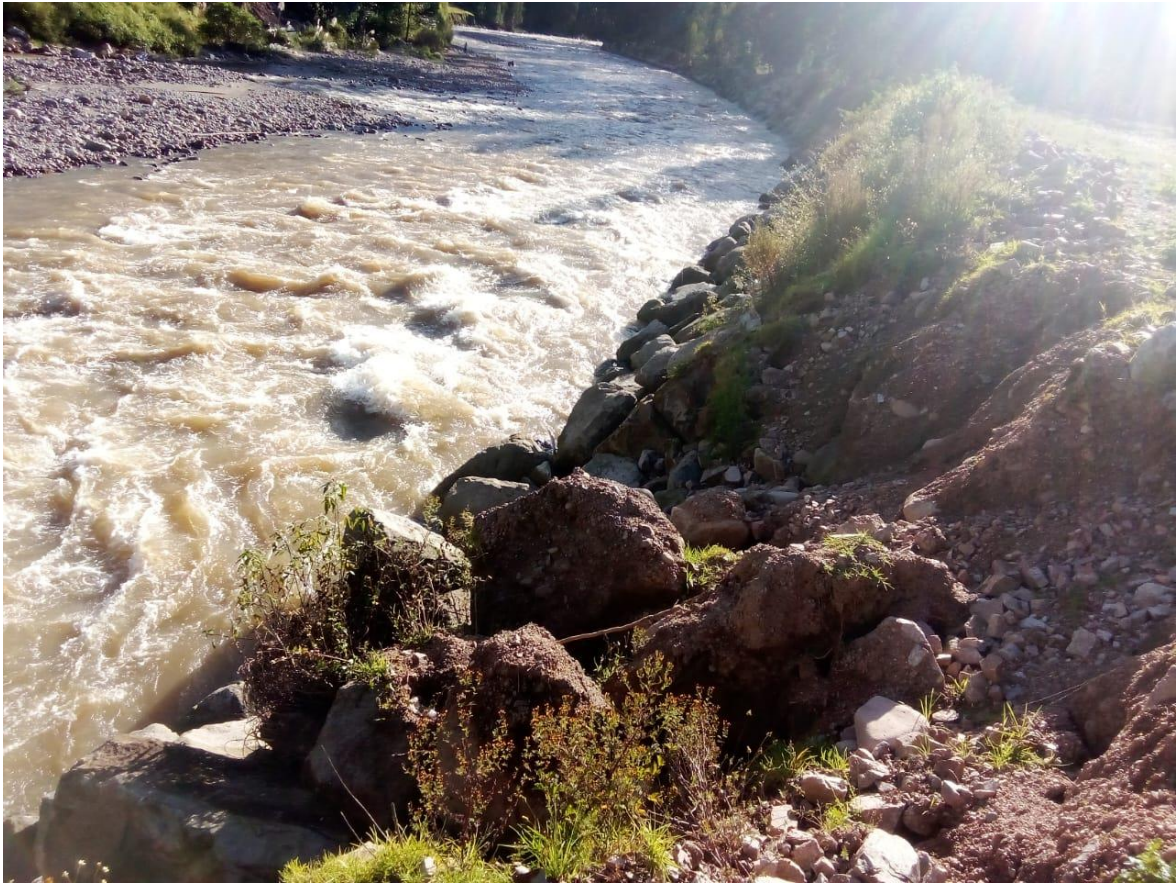
Figura 8: Deslizamiento de las rocas
