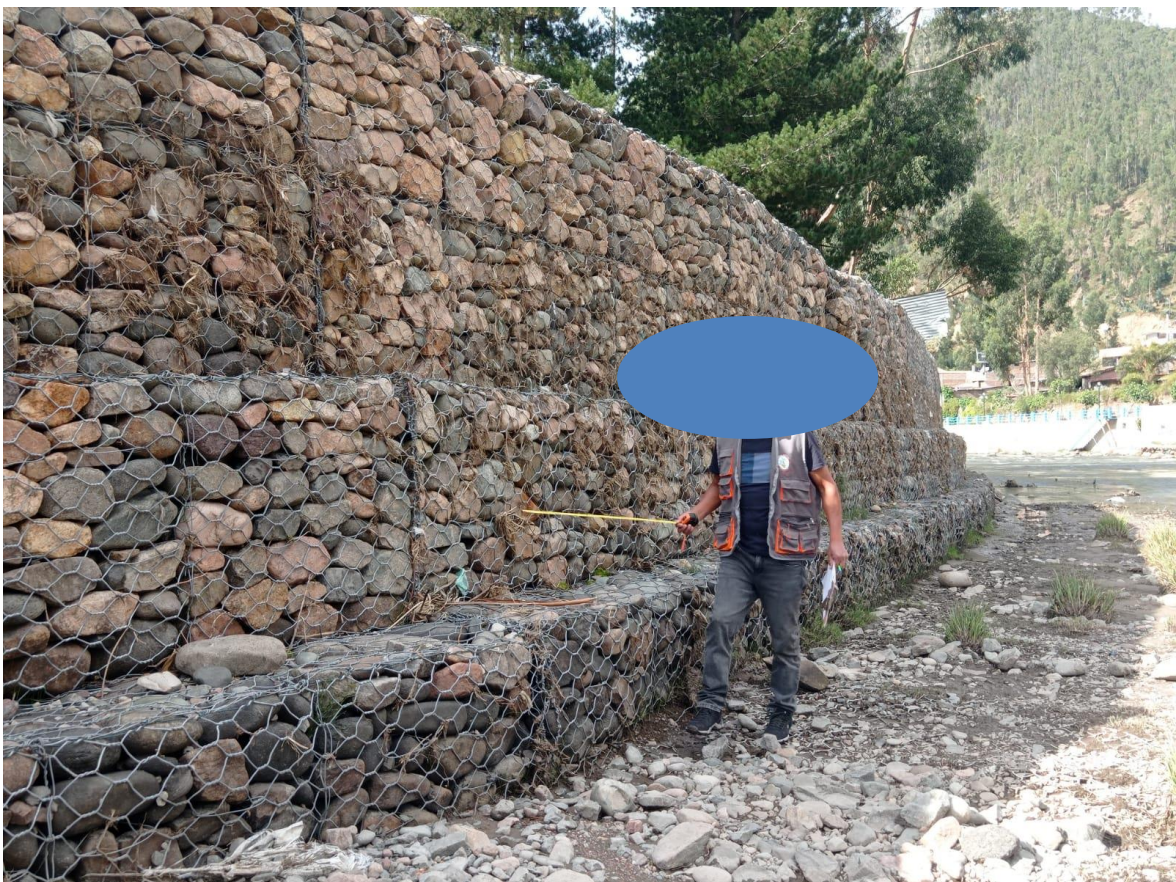
Figura 16: Defensa tipo caja de 4 niveles
