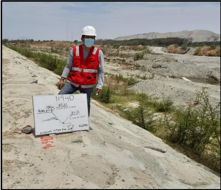
Figura 66: Evaluación progresiva 1+940 Fuente: Elaboración propia
