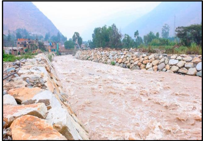
Figura 06: Defensa ribereña tipo enrocado
