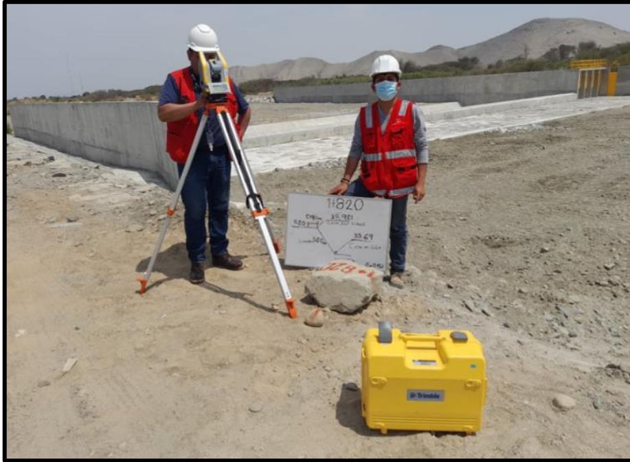
Figura 64: Evaluación progresiva 1+820 Fuente: Elaboración propia
