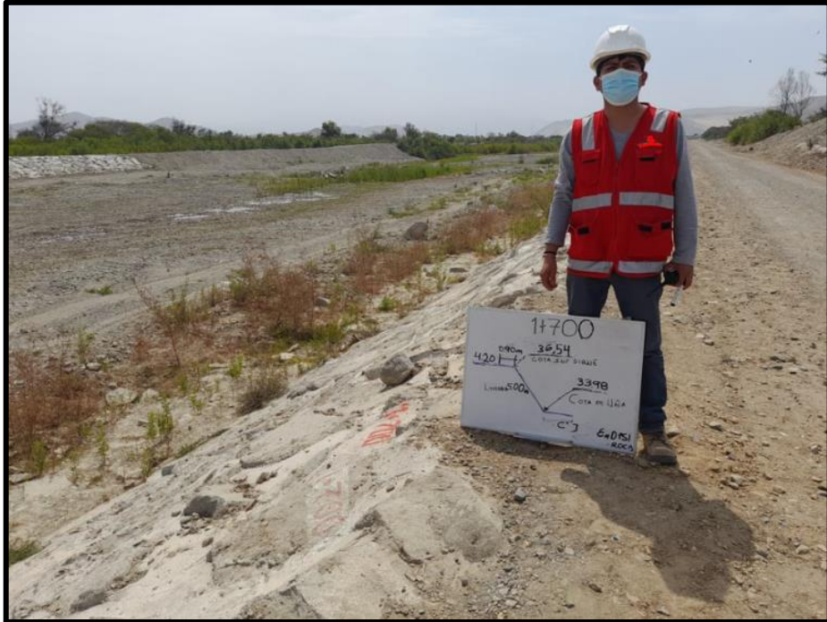
Figura 62: Evaluación progresiva 1+700 Fuente: Elaboración propia
