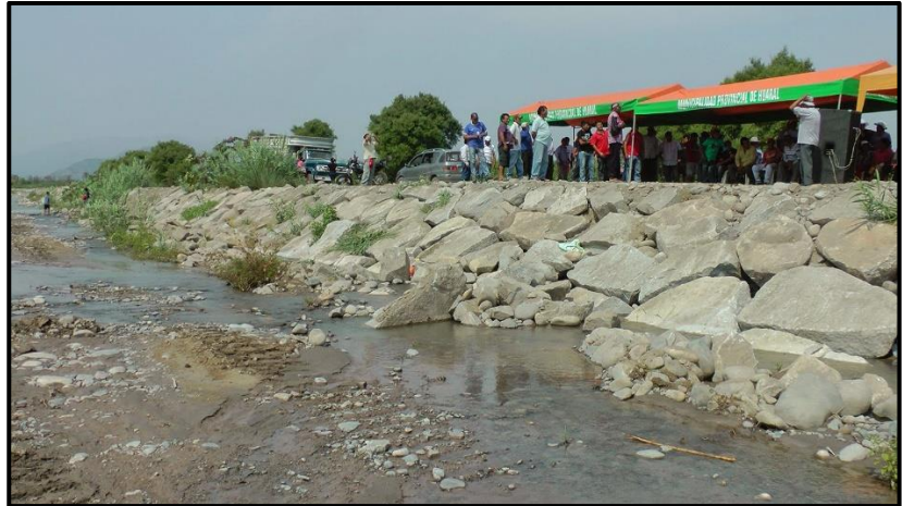
Figura 12: Pantalla de muro de enrocado
