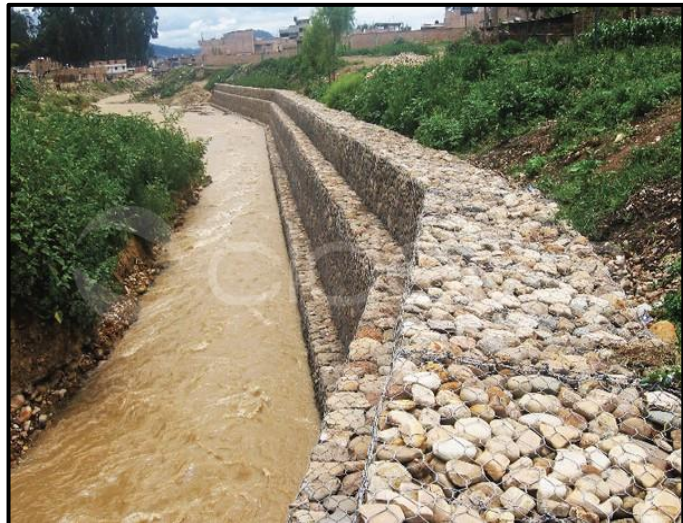
Figura 03: Defensa ribereña tipo gaviones
