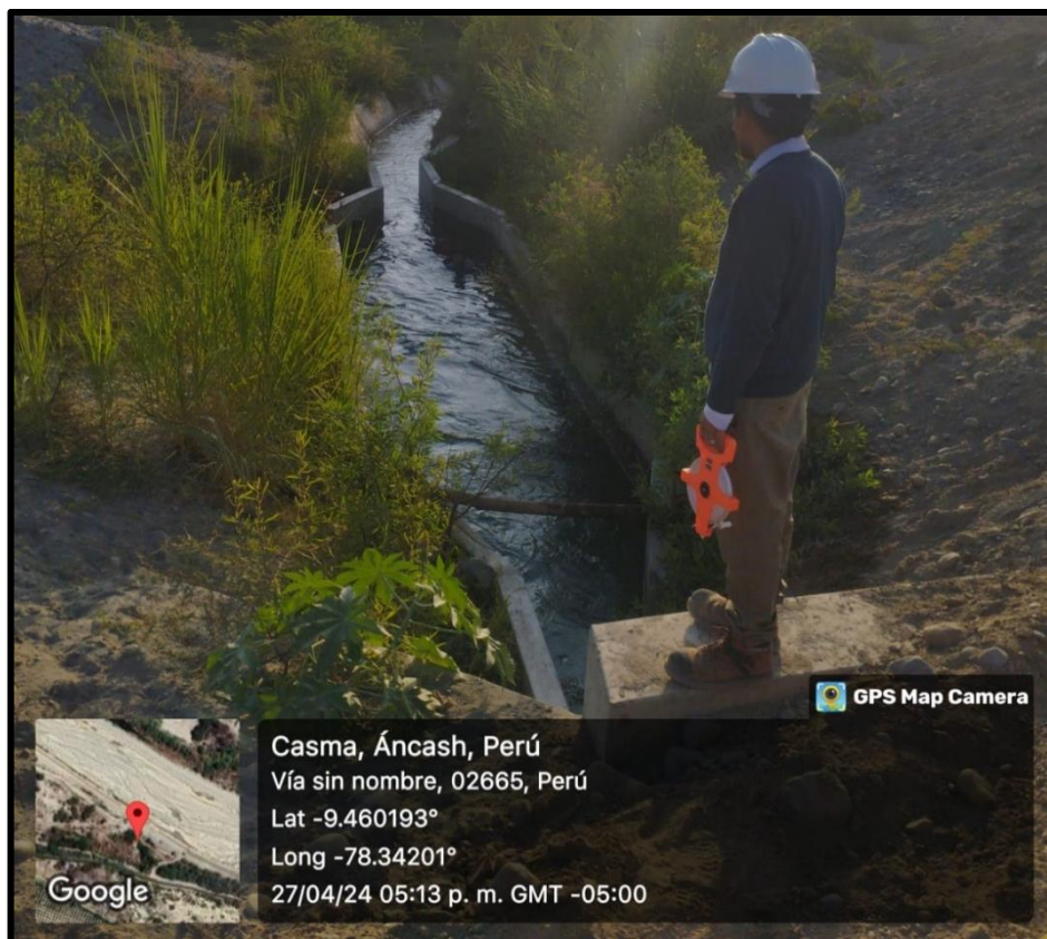
Figura 74: Desarenador del alcantarillado del enrocado – segunda visita Fuente: Elaboración propia
