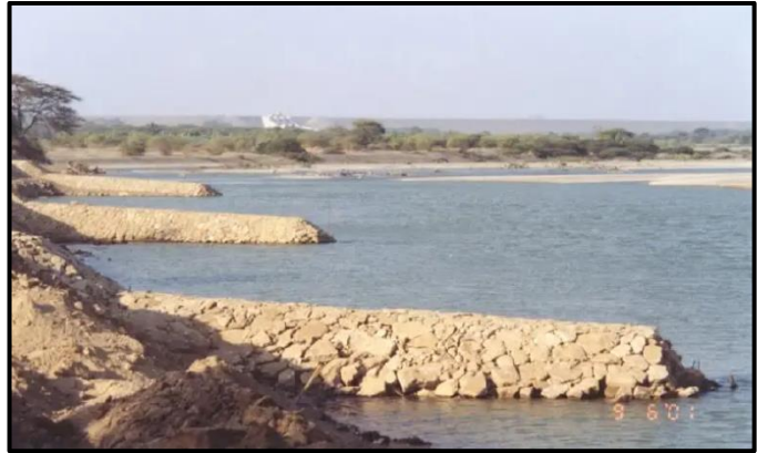
Figura 02: Defensa ribereña tipo espigones
