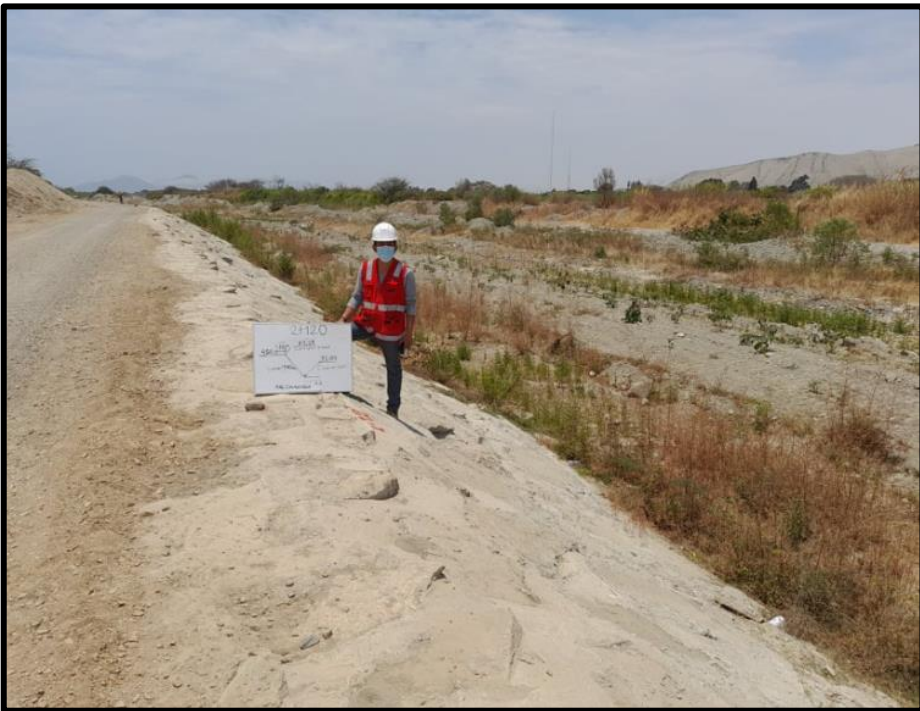
Figura 67: Evaluación progresiva 2+120 Fuente: Elaboración propia
