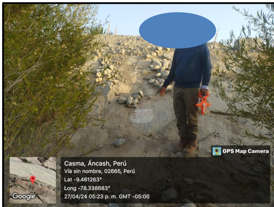
Figura 71: Pantalla de muro de talud – segunda visita Fuente: Elaboración propia
