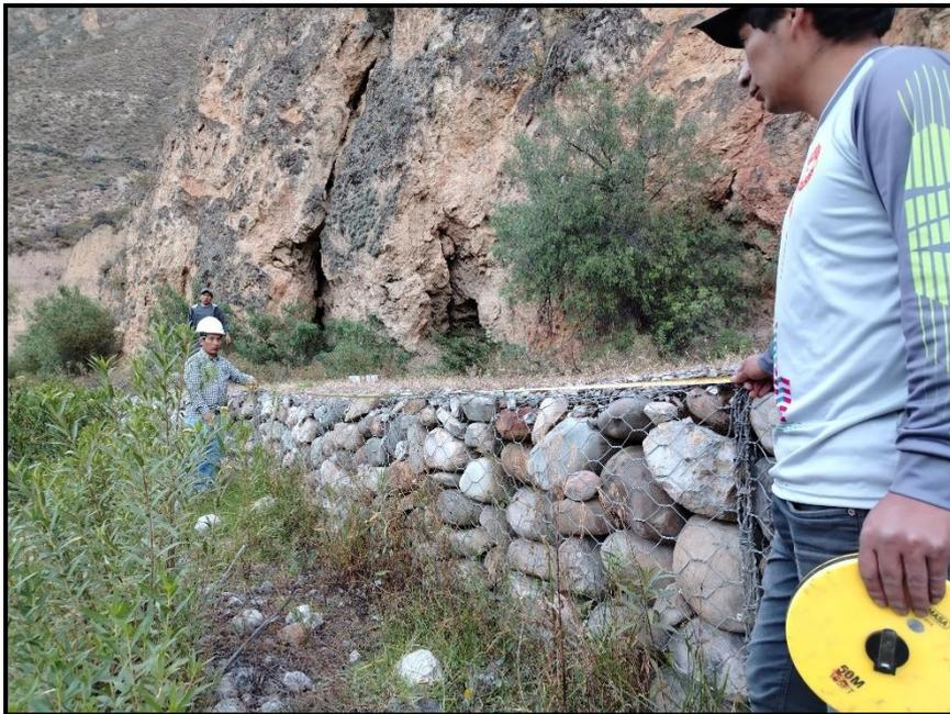
**Figura 61:** Medición entre amarres (cajas de 5mx1.5mx1m)
