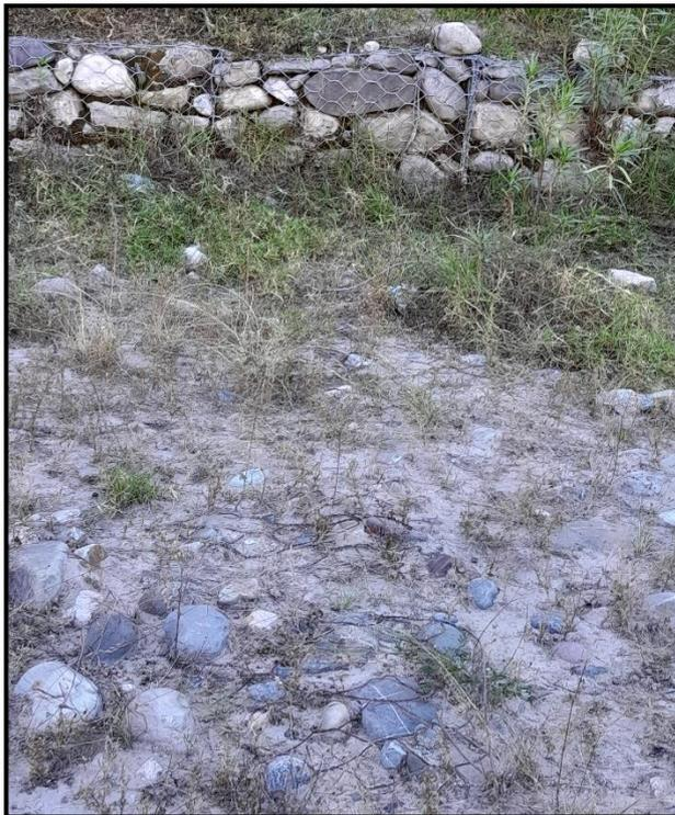
**Figura 65:** Mallas del colchón antisocavante expuestas y deterioradas
