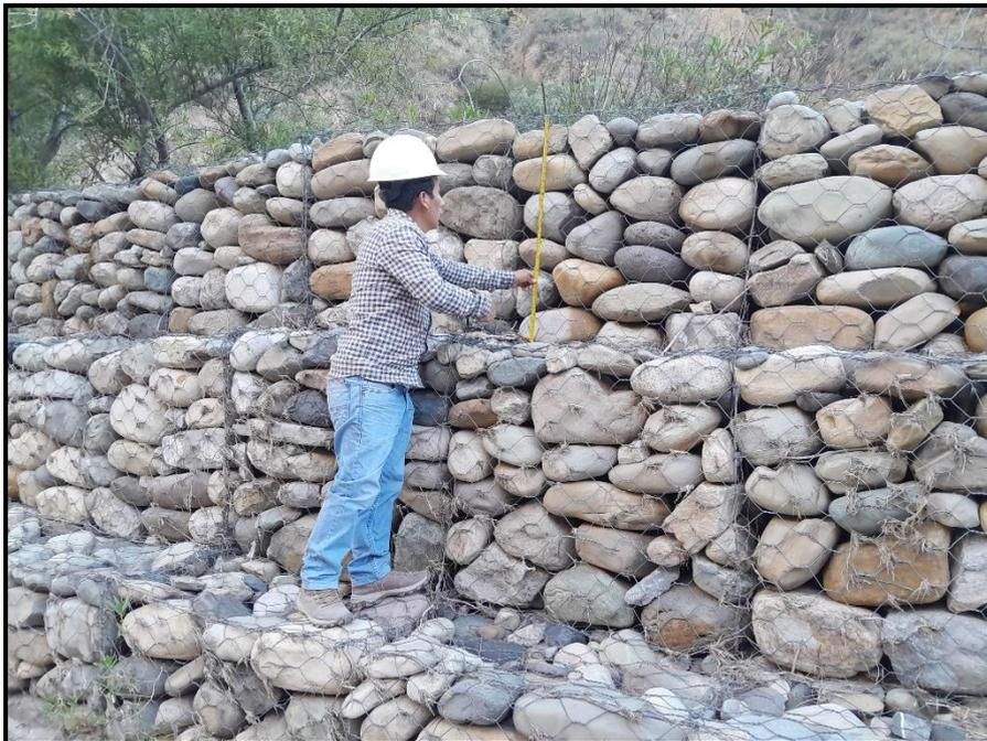
**Figura 41:** Toma de las medidas del muro de gavión N°01
