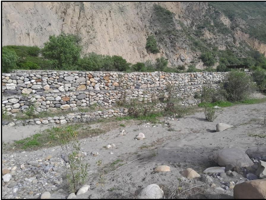
**Figura 48:** Colchón antisocavante del muro enterrado por sedimentos
