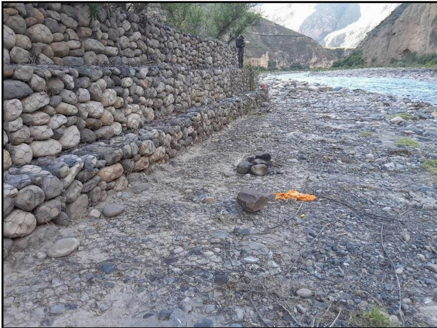
**Figura 42:** Muro de gavión N°01, donde se observa la malla del colchón
