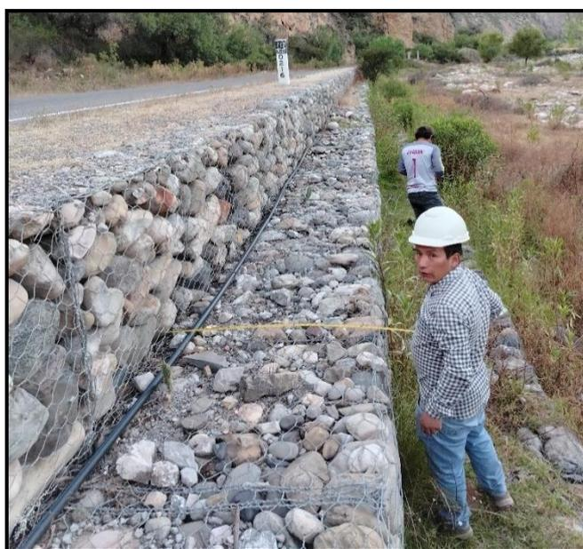
**Figura 22:** El muro no presenta ningún tipo de falla
