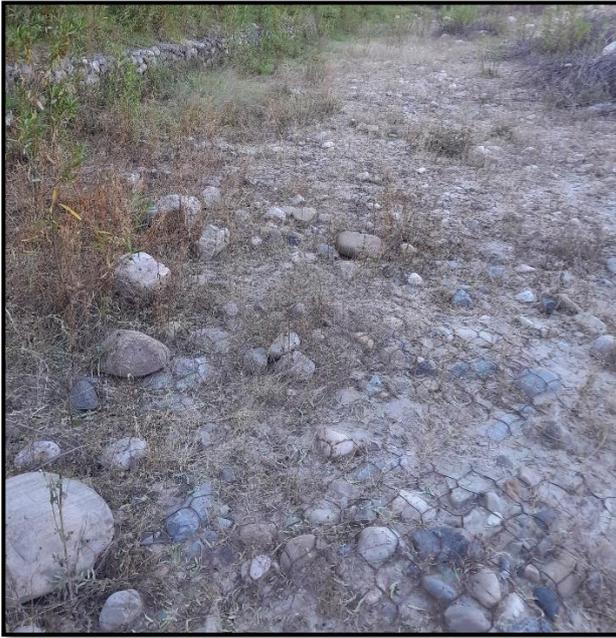
**Figura 66:** Mallas del colchón antisocavante expuestas y corroídas
