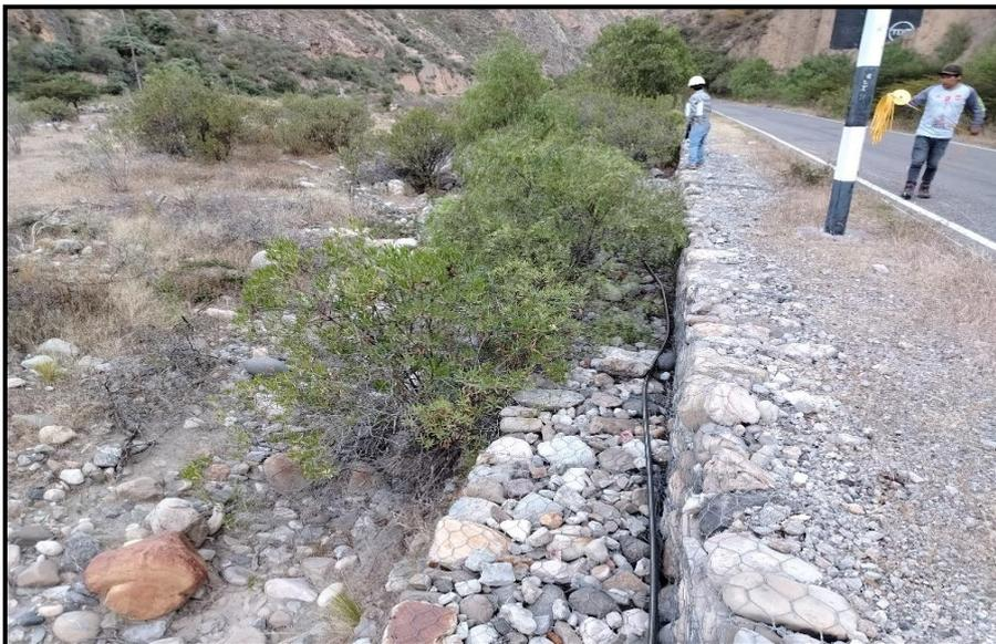
**Figura 25:** Vegetación en la base y escalones del muro
