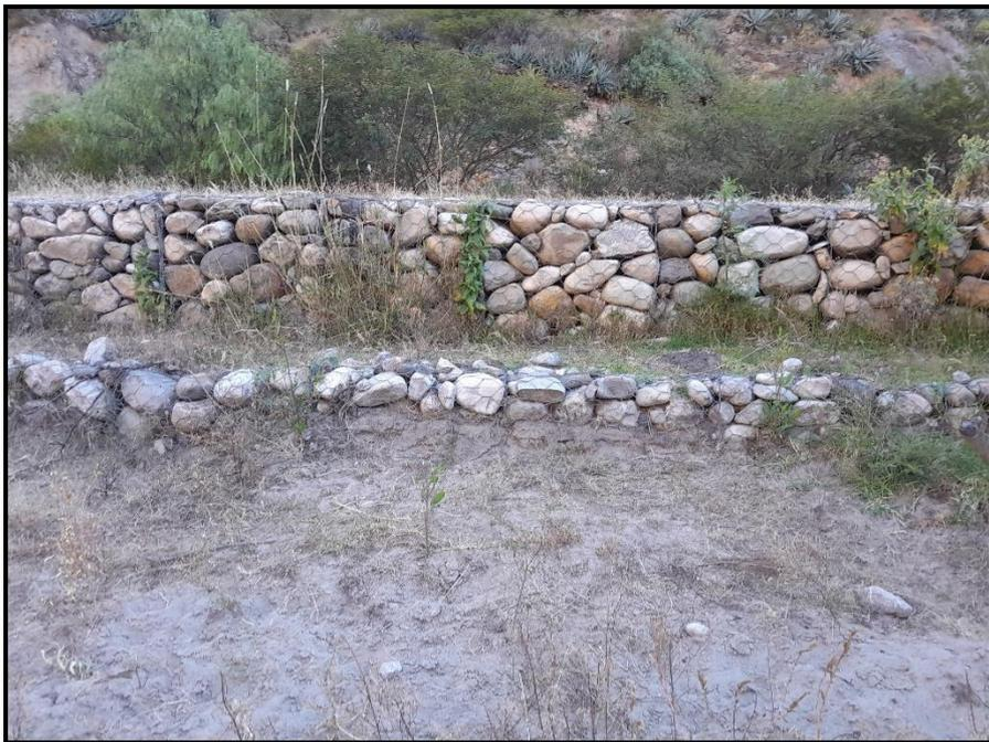
**Figura 49:** El primer y segundo nivel del muro enterrado por sedimentos
