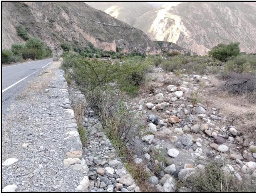
**Figura 56:** Presencia de arbustos en la base de toda la longitud del muro N°02
