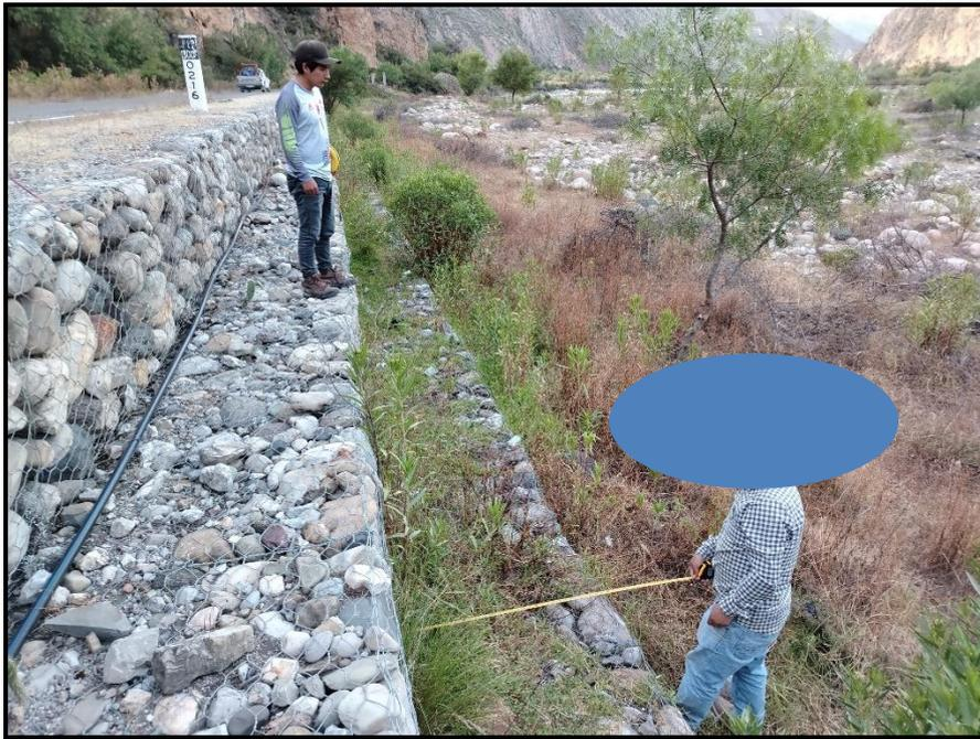
**Figura 62:** Medición de los escalones del muro
