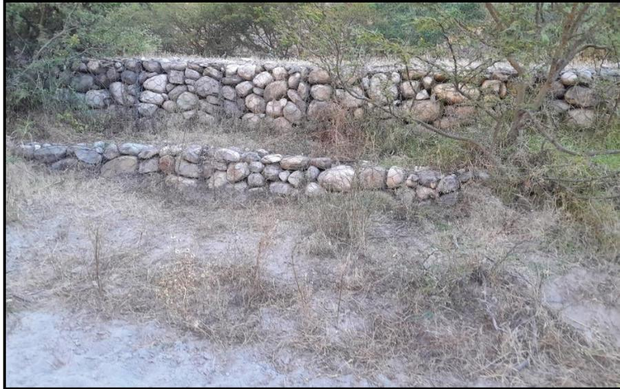
**Figura 20:** Primer y segundo nivel y colchón antisocavante cubierta por sedimentos
