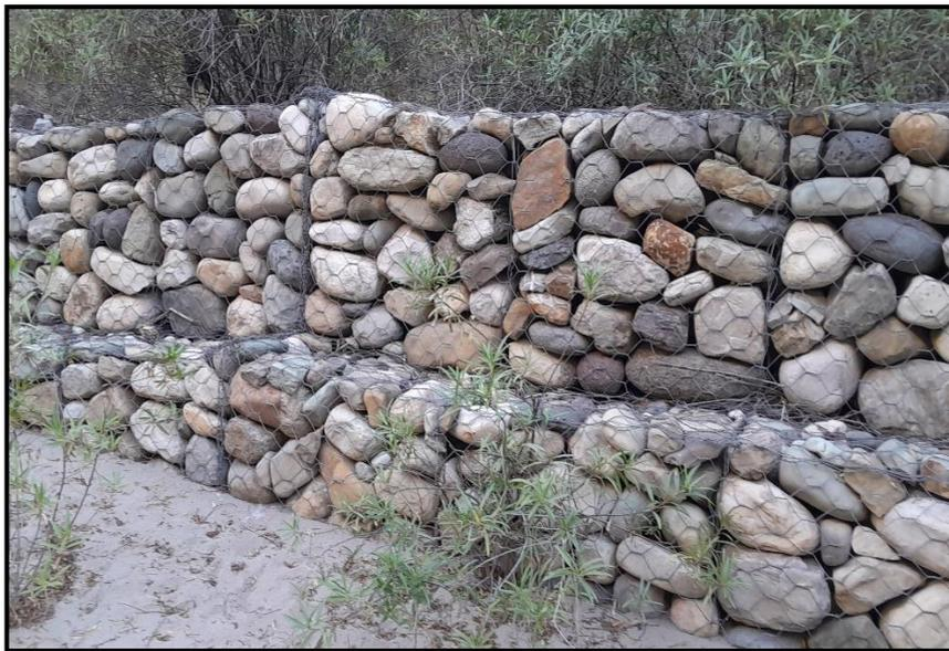
**Figura 16:** Relleno del muro (rocas) en condiciones normales
