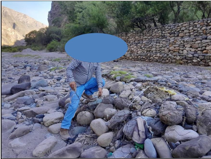
**Figura 45:** Malla del colchón antisocavante corroído y deteriorado
