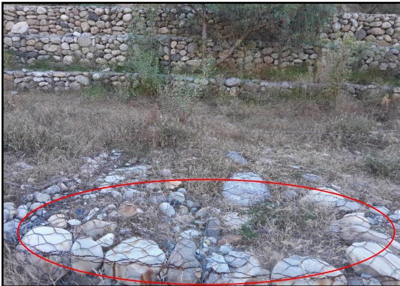
**Figura 29:** La corrosión de las mallas del colchón antisocavante
