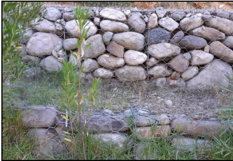
**Figura 28:** La escuadría de las mallas hexagonales deformados
