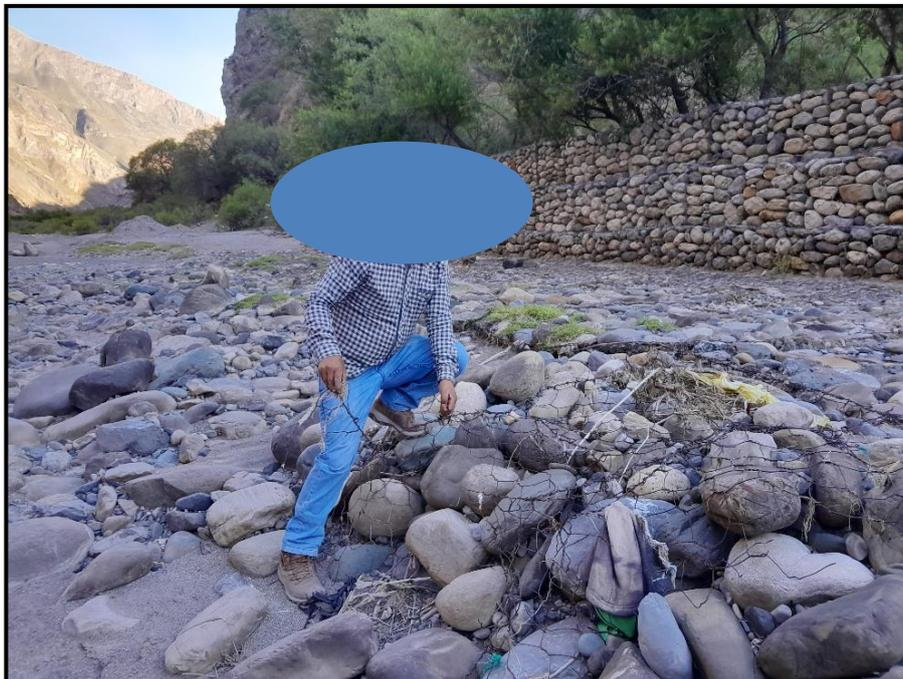
**Figura 15:** Malla de colchón antisocavante corroído y deteriorado
