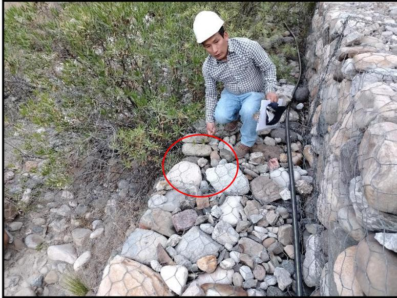
**Figura 30:** Rotura de las mallas del gavión
