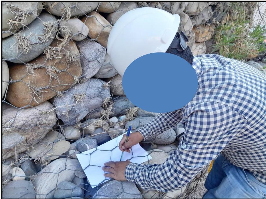
**Figura 14:** Determinación de las escuadrías de la malla hexagonal
