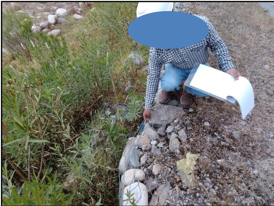
**Figura 59:** Rotura de malla, desalojo del relleno y asentamiento de la corona
