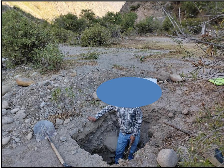
**Figura 70:** Excavación de calicata de 1.0mx1.50 m
