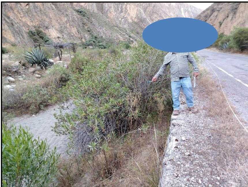
**Figura 55:** Presencia de arbustos en la base y encima del primer y segundo del muro N°02
