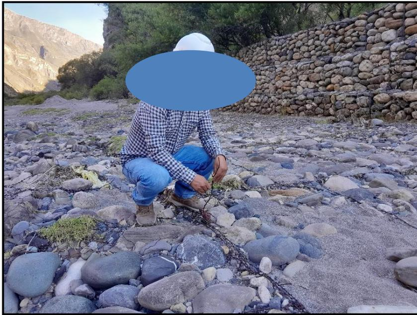
**Figura 12:** Erosión de la superficie del colchón antisocavante
