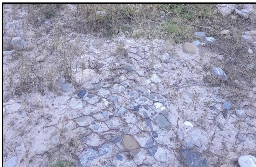
**Figura 18:** Colchón antisocavante erosionado y corroído
