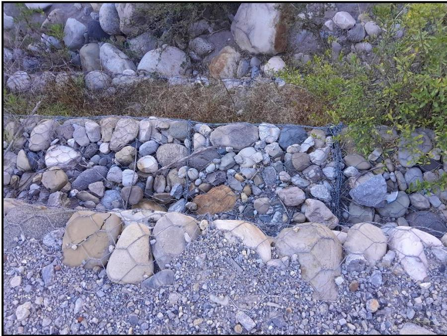
**Figura 52:** Niveles del muro de gavión N°02
