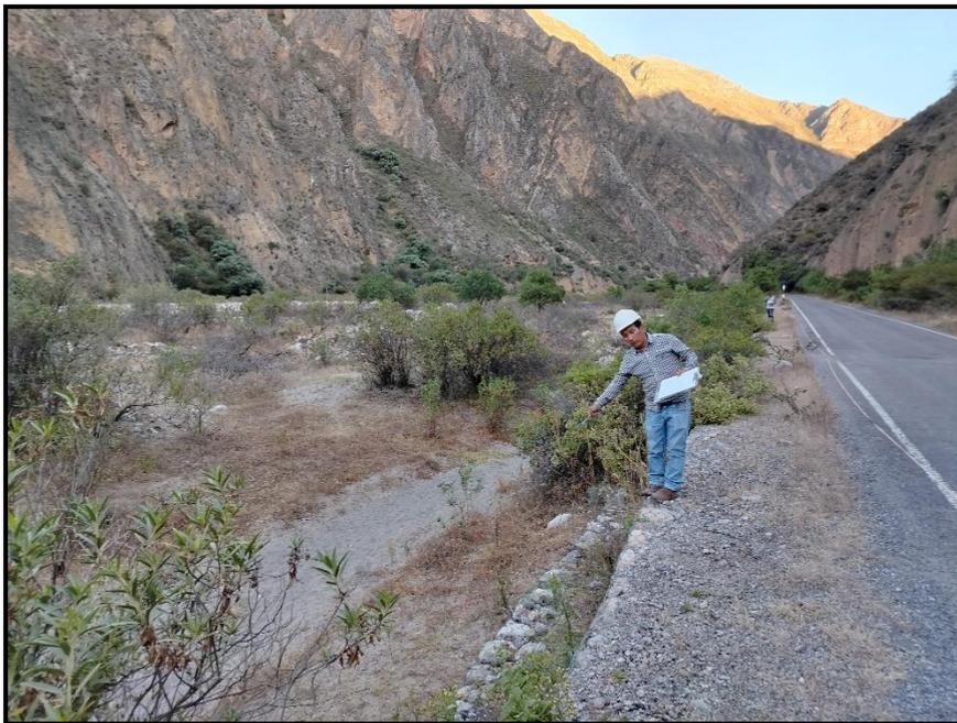
**Figura 53:** Sedimentos que entierra el colchón y parte del muro de gavión N°02
