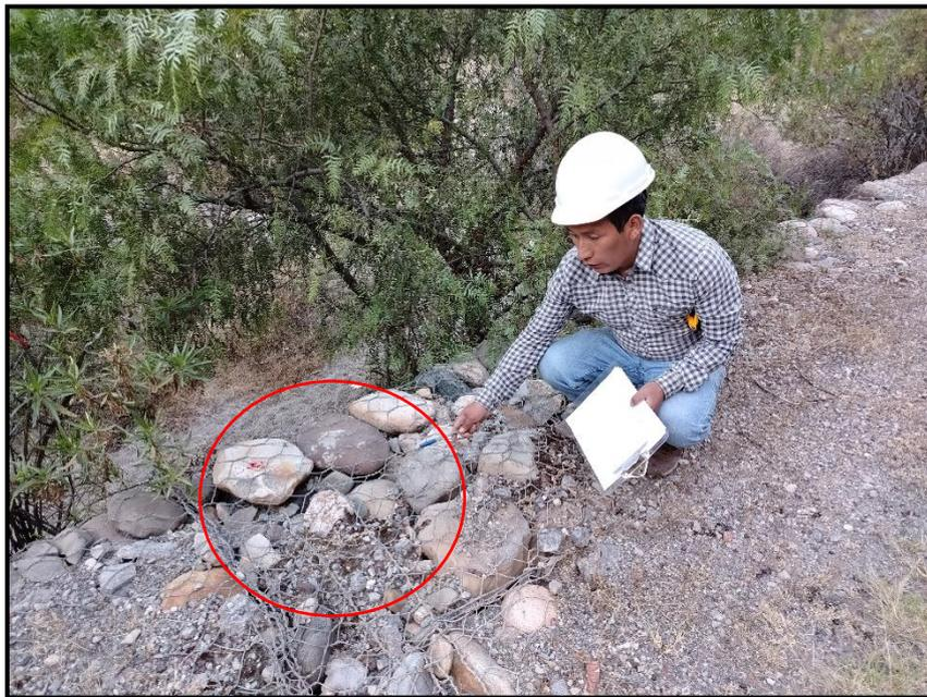
**Figura 23:** Asentamiento de la corona del muro por desalojo de relleno
