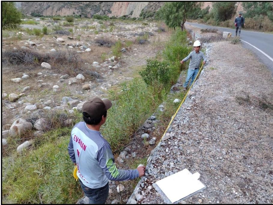
**Figura 60:** Medición entre amarres (cajas de 5mx1mx1m)
