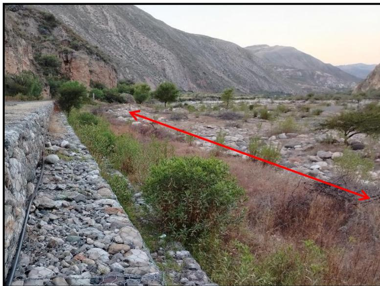
**Figura 19:** Socavación de la base del colchón antisocavante
