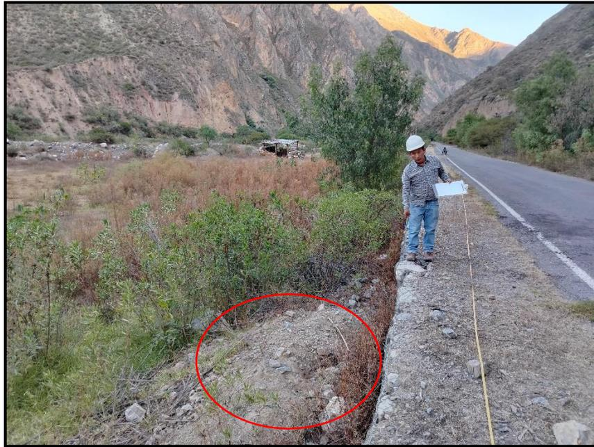
**Figura 26:** Escombros en los escalones del muro
