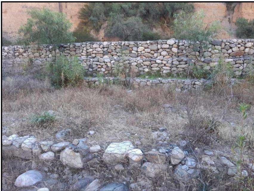
**Figura 67:** Mallas del colchón antisocavante en proceso de oxidación
