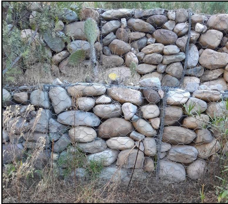
**Figura 27:** Sentido de la malla hexagonal de manera horizontal
