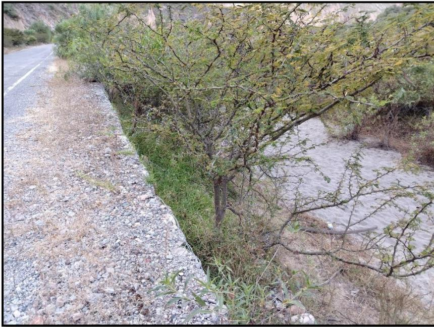
**Figura 54:** Presencia de arbustos encima del nivel dos del muro de gavión N°02
