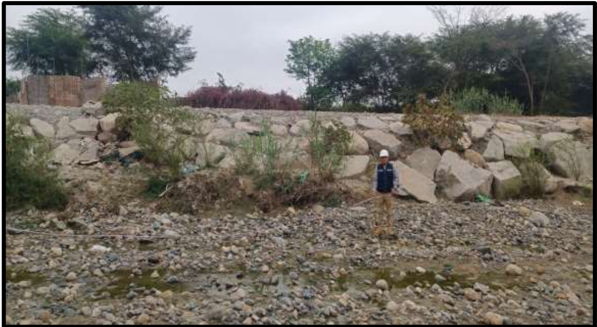
Figura 2: Primera toma de datos desde la progresiva 0+200 hasta 0+250.
