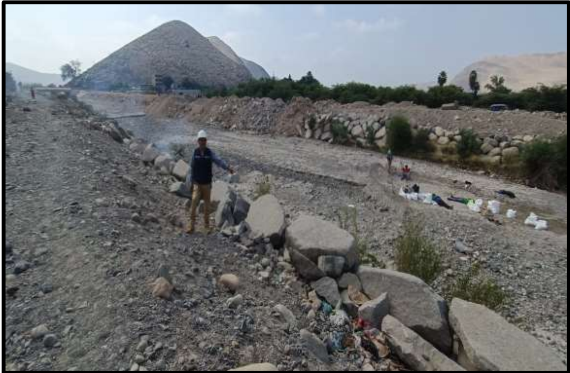
Figura 19: Foto desde la parte de arriba de la defensa ribereña de la parte final del enrocado que evaluaremos.
