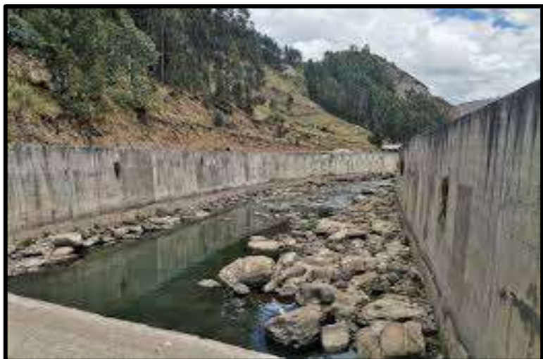
Figura 10. Muros de concreto armado.
