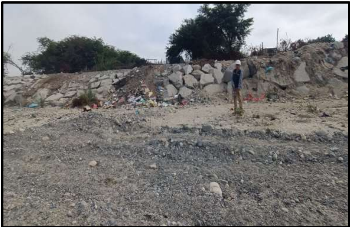
Figura 6: Quinta toma de datos desde la progresiva 0+400 hasta 0+450.
