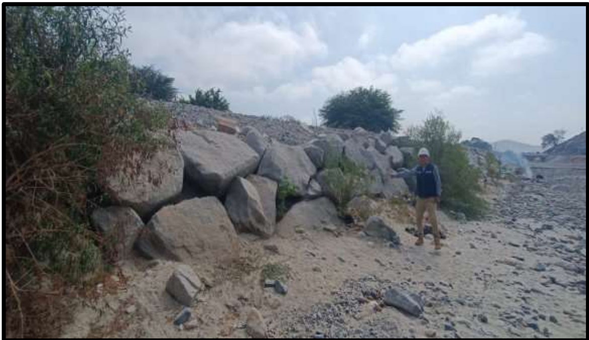
Figura 14: Se aprecia base erosionado como falta de existencia de rocas en la parte superior entre la progresiva 0+500 hasta 0+530.
