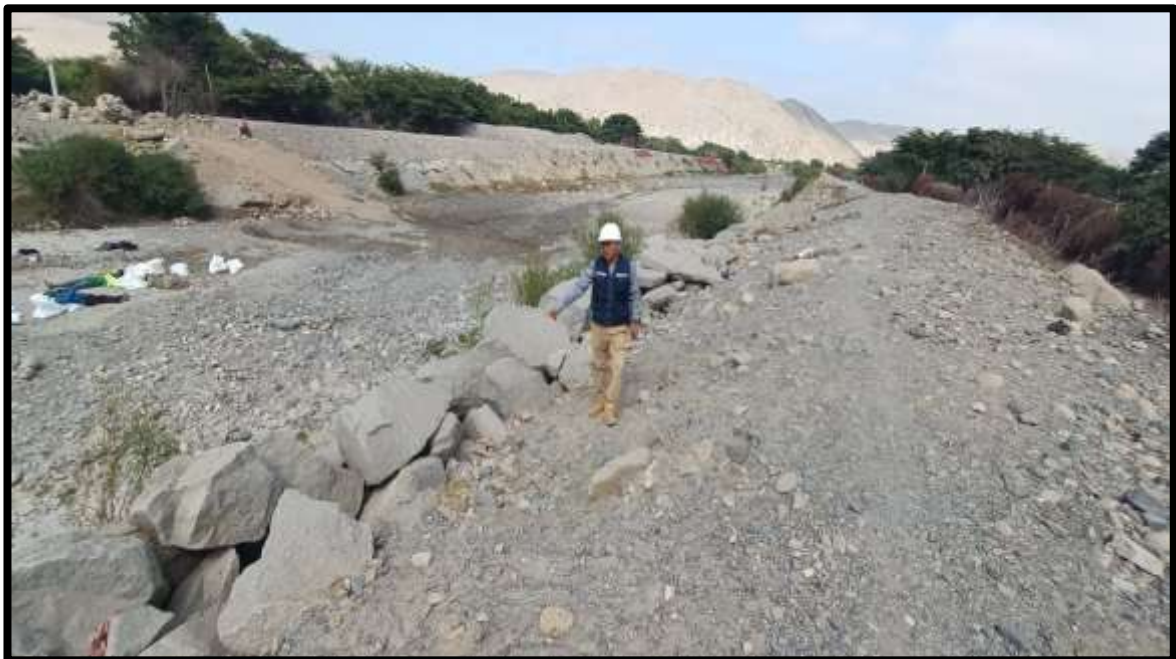
Figura 18: Foto desde la parte de arriba de la defensa ribereña al inicio del enrocado que evaluaremos.
