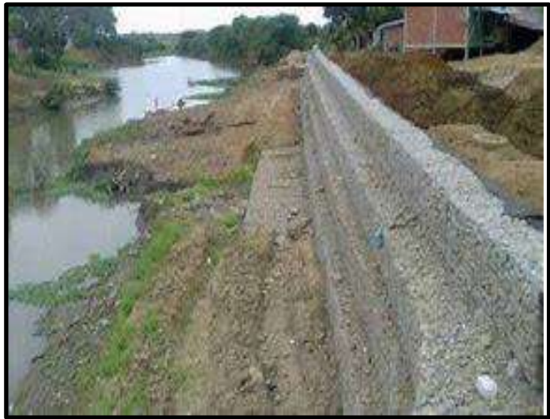
Figura 11. Muro de gaviones.
