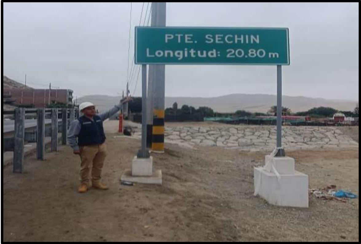
Figura 1: Punto de inicio de la defensa ribereña ubicado aguas abajo del puente Sechín.
