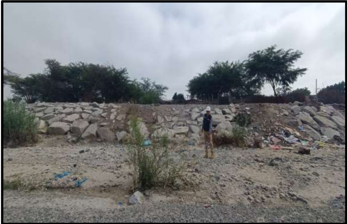
Figura 5: Cuarta toma de datos desde la progresiva 0+300 hasta 0+350.
