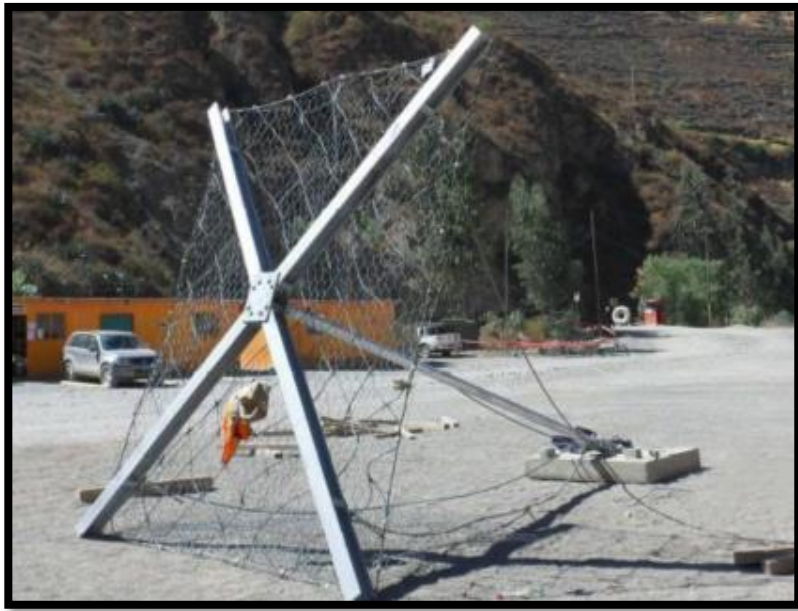
Figura 9: Defensa ribereña Sistema erdox
