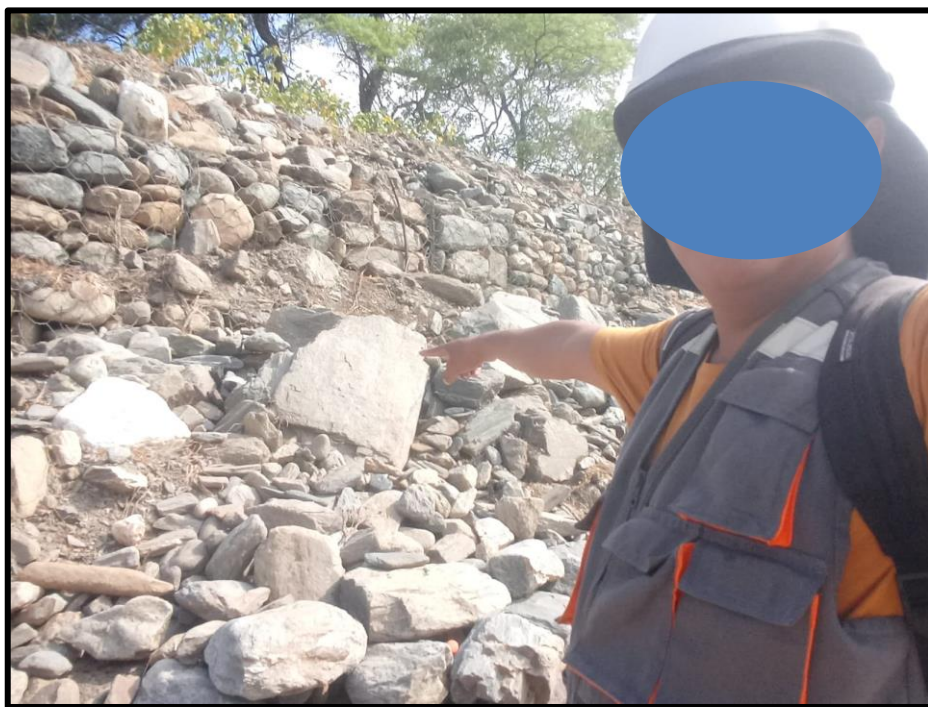
Figura 23: Tesista en la progresiva 0+000 – 1+200- muro de gavión
