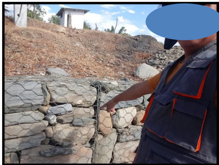
Figura 13: Tesista- evaluando el muro de gavión de quebrada Alan García
