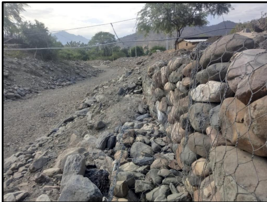
Figura 25: Tesista en la progresiva 0+800 – 1 +200- muro de gavión
