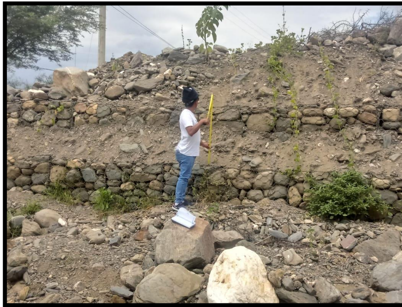
Figura 20: Tesista realizando medidas en muro de gavion
