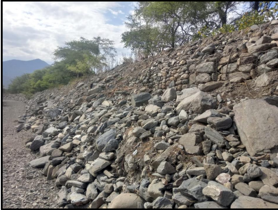
Figura 24: Tesista en la progresiva 0+200 – 0+800- muro de gavión
