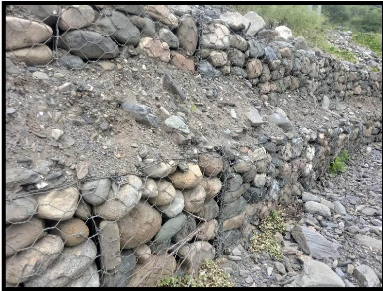
Figura 22: Muro de gavión- progresiva 0+700 - 0+ 760
