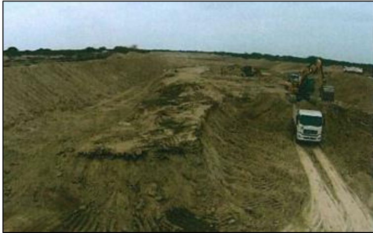
Figura 5. Extracción de material sedimentado de cauce
