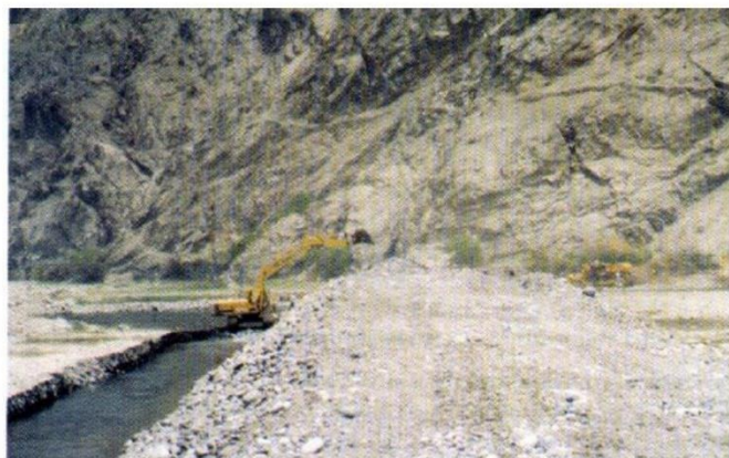
Foto N°4. Tractor iniciando armado de terraplén
