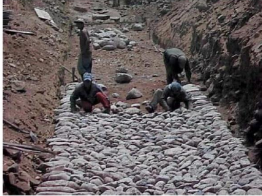
Figura 6.6. Forma de colocar las piedras para un enrocado colocado a mano
