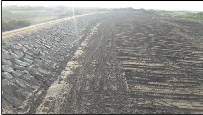
Figura 12. Diques de defensa ribereña - Continuas
