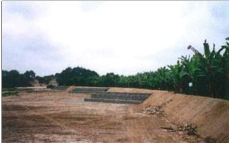
Figura 3. Protección con espigones de gaviones
