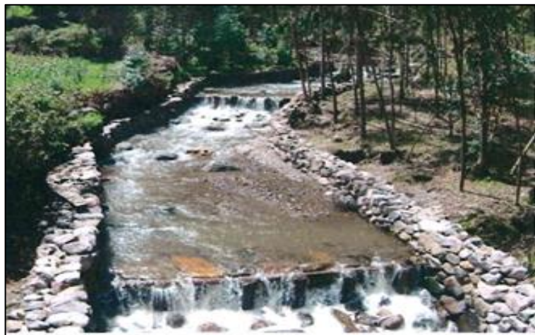
Figura 4. Disipadores de energía
