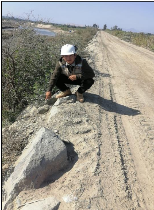
Figura 20. Enrocado de la defensa ribereña del río Lacramarca KM 7+500
