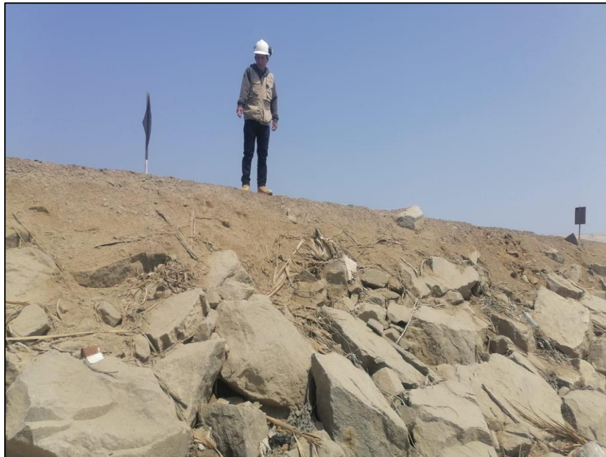
Figura 22. Evaluación del enrocado del río Lacramarca KM 7+500 al 7+800
