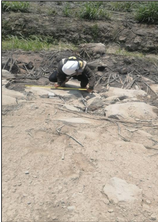
Figura 23. Medición del enrocado del río Lacramarca KM 7+500 al 7+600
