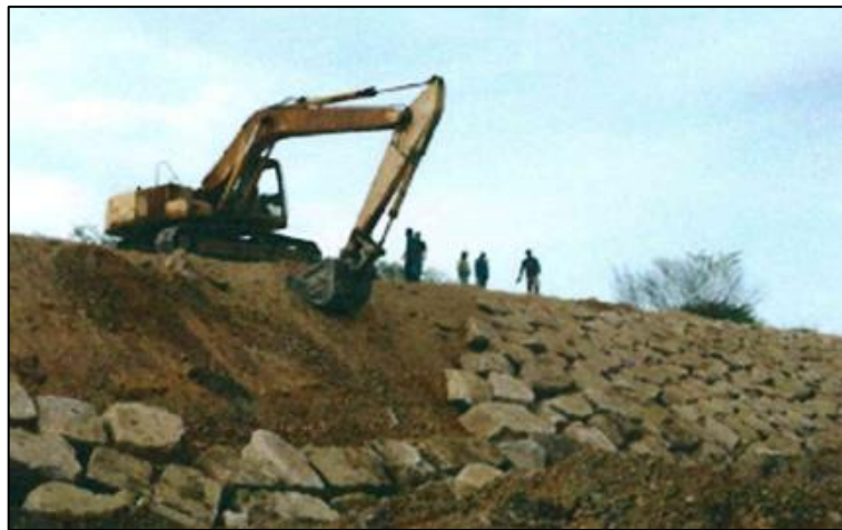
Figura 2. Conformación de dique enrocado
