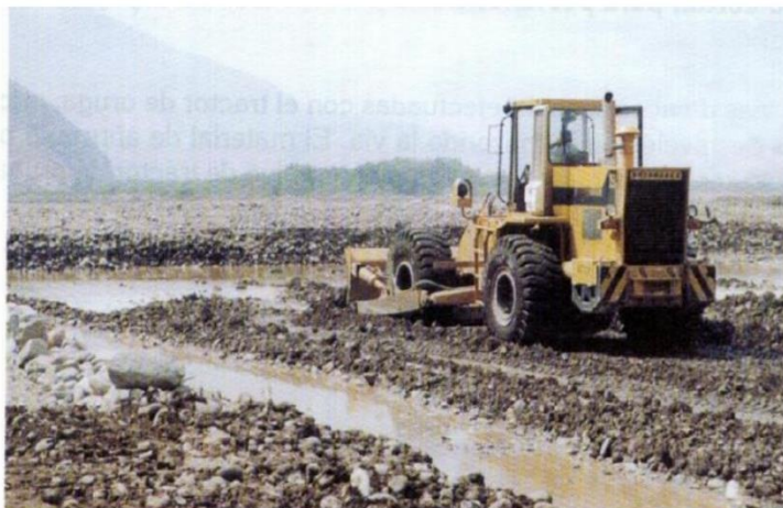
Foto N°3- Preparación de vía de acceso
