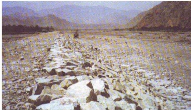
Figura 6.3. Fotografía de un enrocado con roca colocada al volteo
