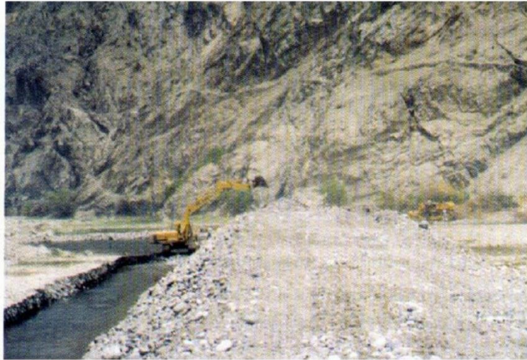
Foto N°5. Excavadora culminando la apertura de la uña de estabilidad
