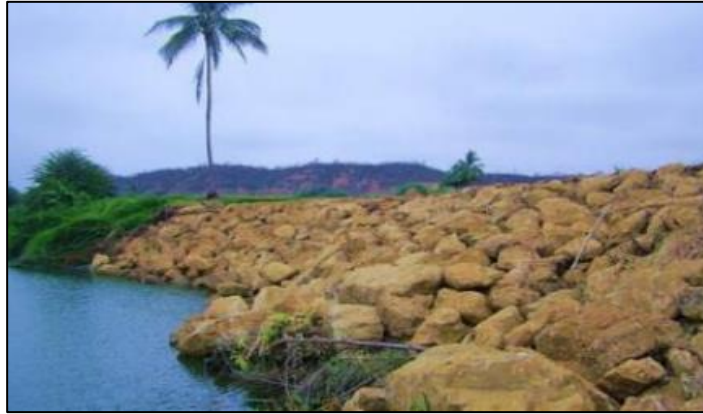
Figura 7. Enrocado con roca al volteo
