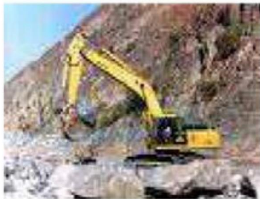
Figura 6.7. Volcado del enrocado con maquinaria
