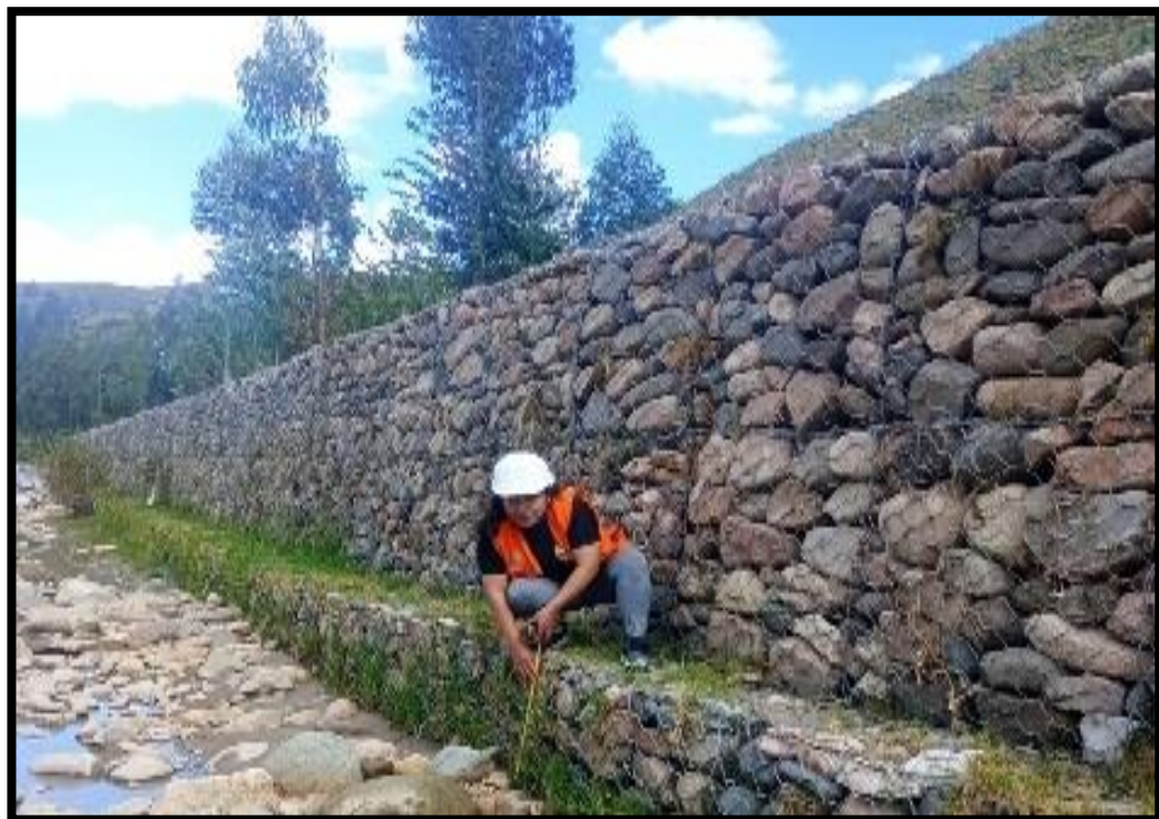
Figura 33: Evaluación de muro de gaviones progresiva 0+700 al 0+800. Fuente: Evidencia de campo 2024.
