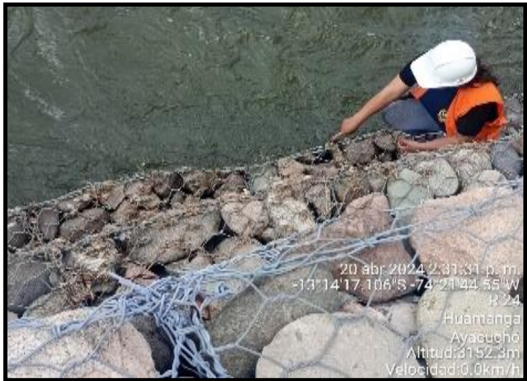
Figura 30: Evaluación de muro de gaviones progresiva 0+400 al 0+500. Fuente: Evidencia de campo 2024.
