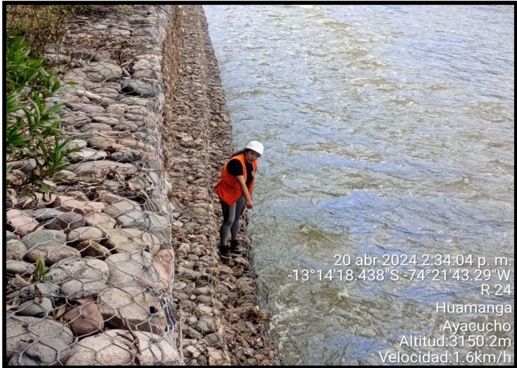
Figura 26: Evaluación de muro de gaviones progresiva 0+000 al 0+100. Fuente: Evidencia de campo 2024.
