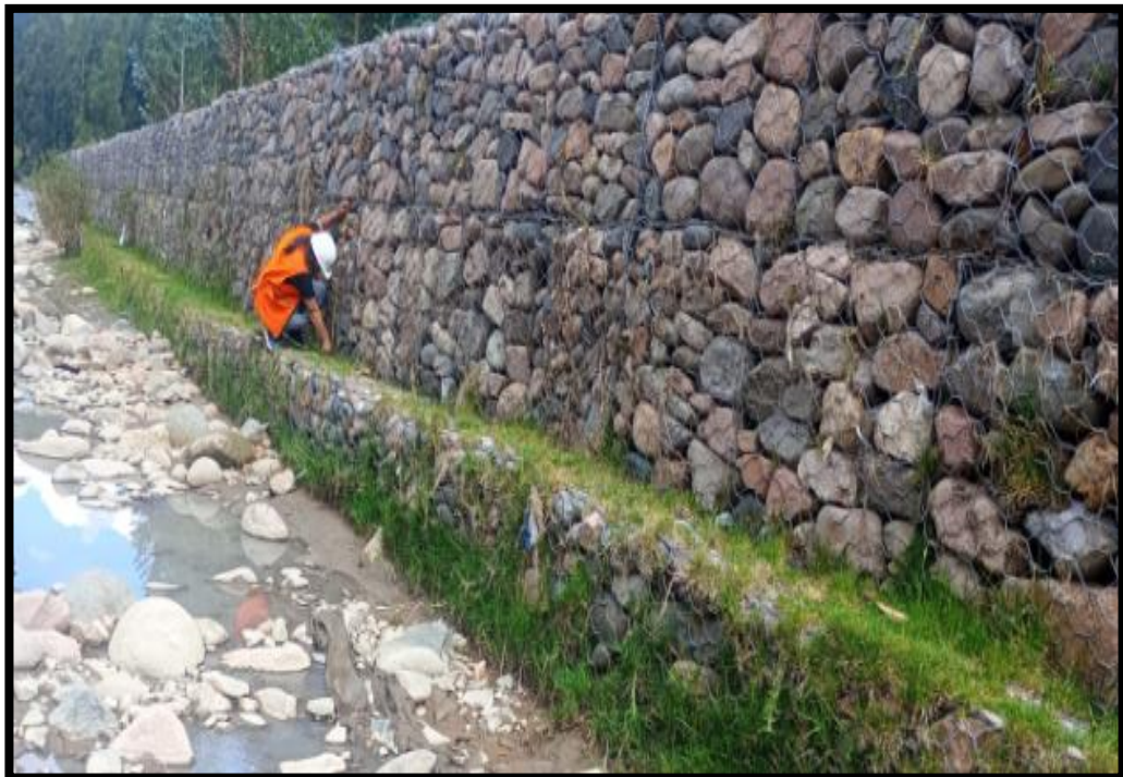
Figura 35: Evaluación de muro de gaviones progresiva 0+900 al 1+000. Fuente: Evidencia de campo 2024.
