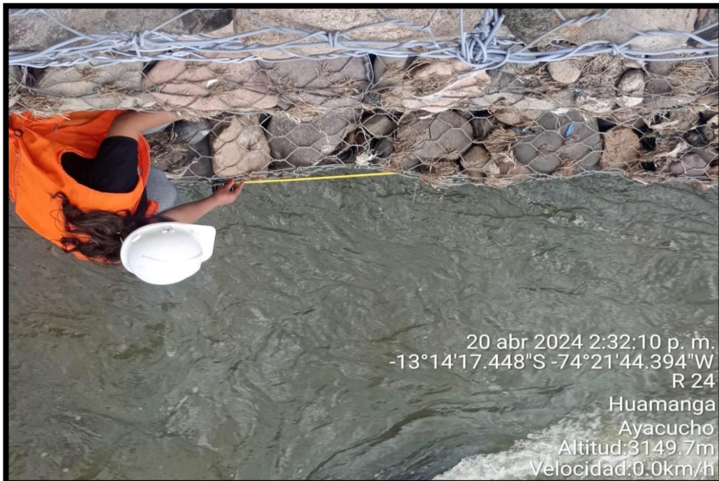
Figura 27: Evaluación de muro de gaviones progresiva 0+100 al 0+200. Fuente: Evidencia de campo 2024.
