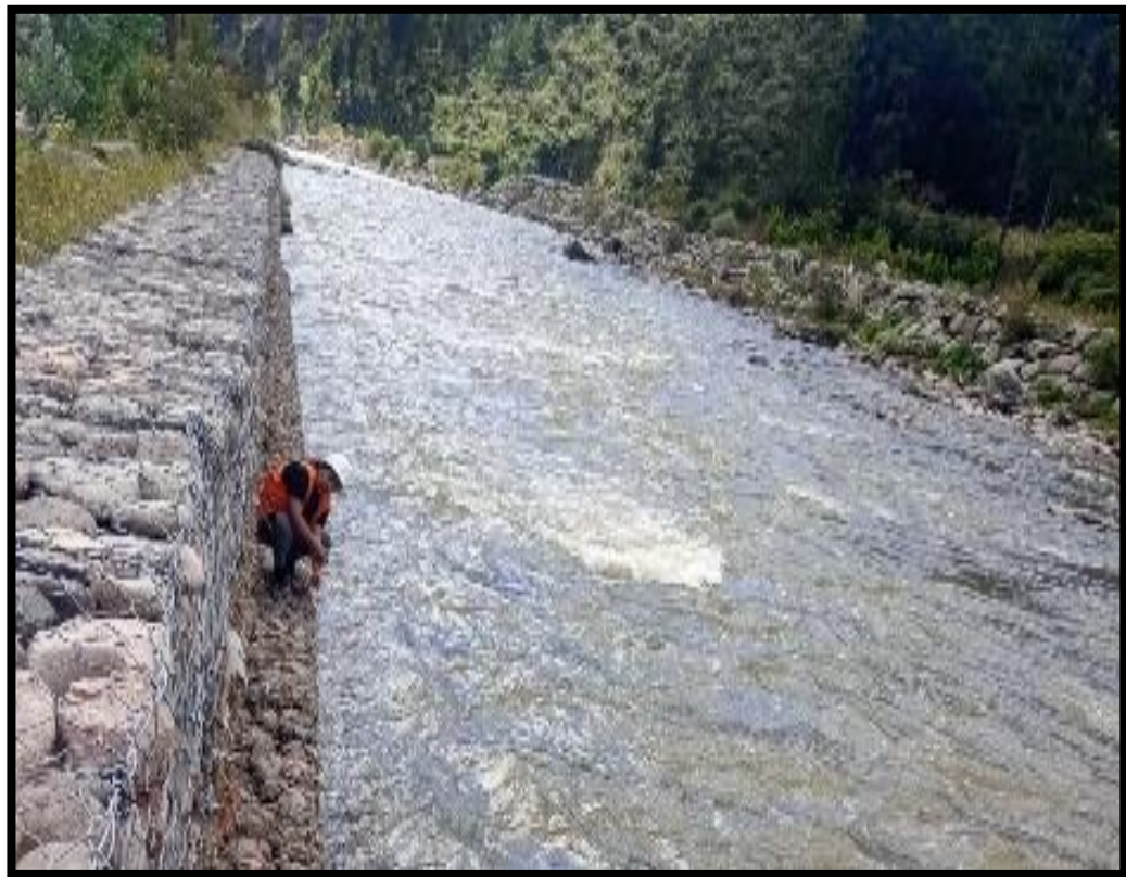
Figura 31: Evaluación de muro de gaviones progresiva 0+500 al 0+600. Fuente: Evidencia de campo 2024.
