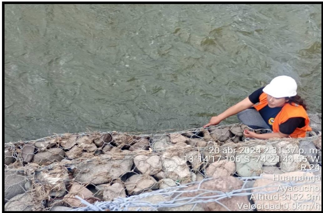
Figura 28: Evaluación de muro de gaviones progresiva 0+200 al 0+300. Fuente: Evidencia de campo 2024.
