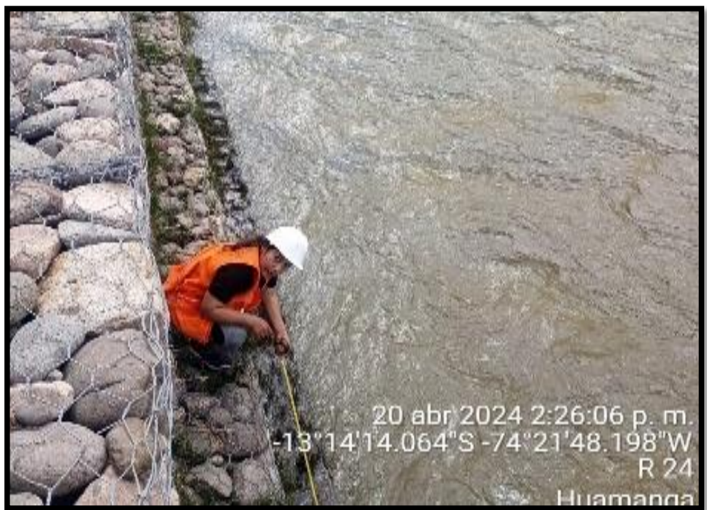
Figura 29: Evaluación de muro de gaviones progresiva 0+300 al 0+400. Fuente: Evidencia de campo 2024.
