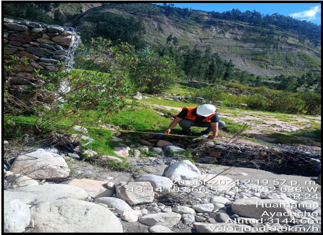
Figura 34: Evaluación de muro de gaviones progresiva 0+800 al 0+900. Fuente: Evidencia de campo 2024.
