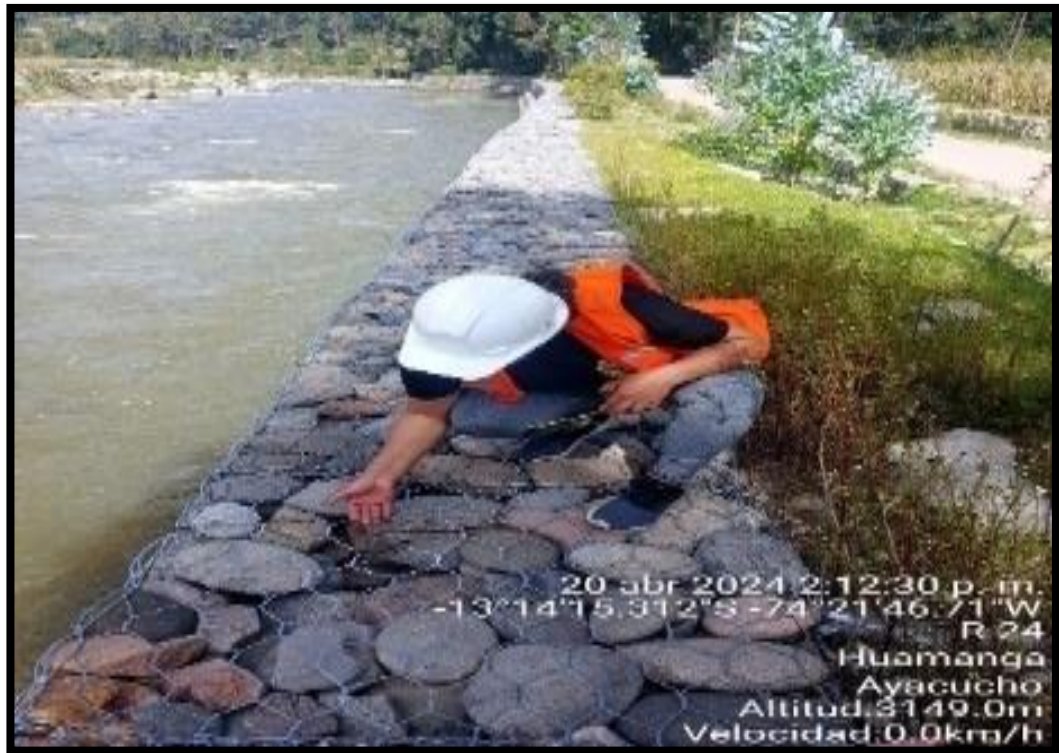
Figura 32: Evaluación de muro de gaviones progresiva 0+600 al 0+700. Fuente: Evidencia de campo 2024.
