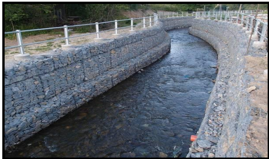
Figura 2: Muro de Gaviones.
