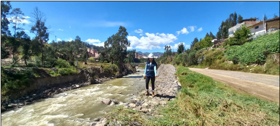
Figura 12: Vista de la vegetación en la corona del muro de gaviones
