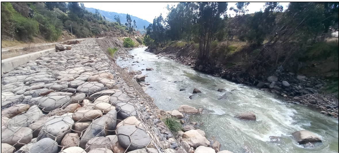
Figura 10: Vista del muro de gavi6n
