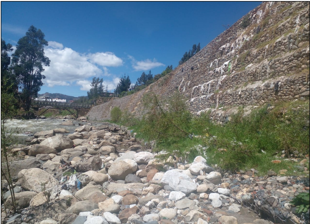
Figura 23: Vista del muro de gaviones.
