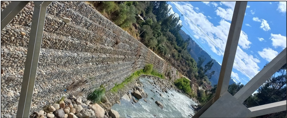
Figura 9: Vista del muro de gaviones
