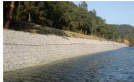
Figura 2. Gaviones para contención fluvial. Fuente: (A Bianchini, 2017).
