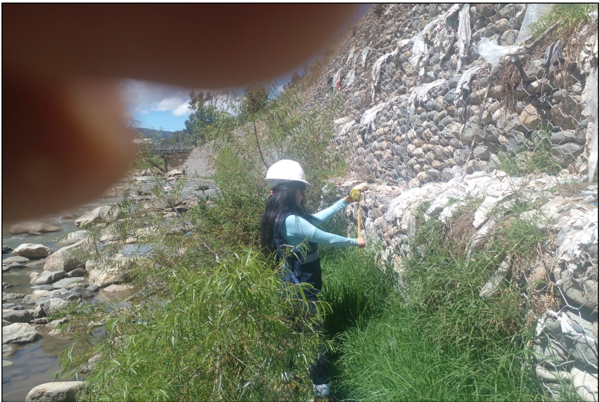
Figura 21: Medida del alto del muro de gavión
