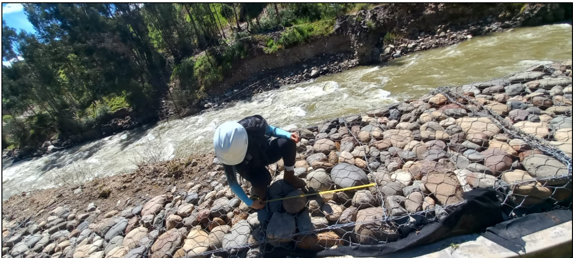
Figura 13: Vista de medida del largo del muro de gavión.
