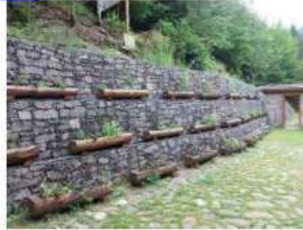
Figura 1. Estructura con gaviones. Fuente: http://www.solucionesespeciales.net/MedioAmbiente/Gaviones/Gaviones.aspx
