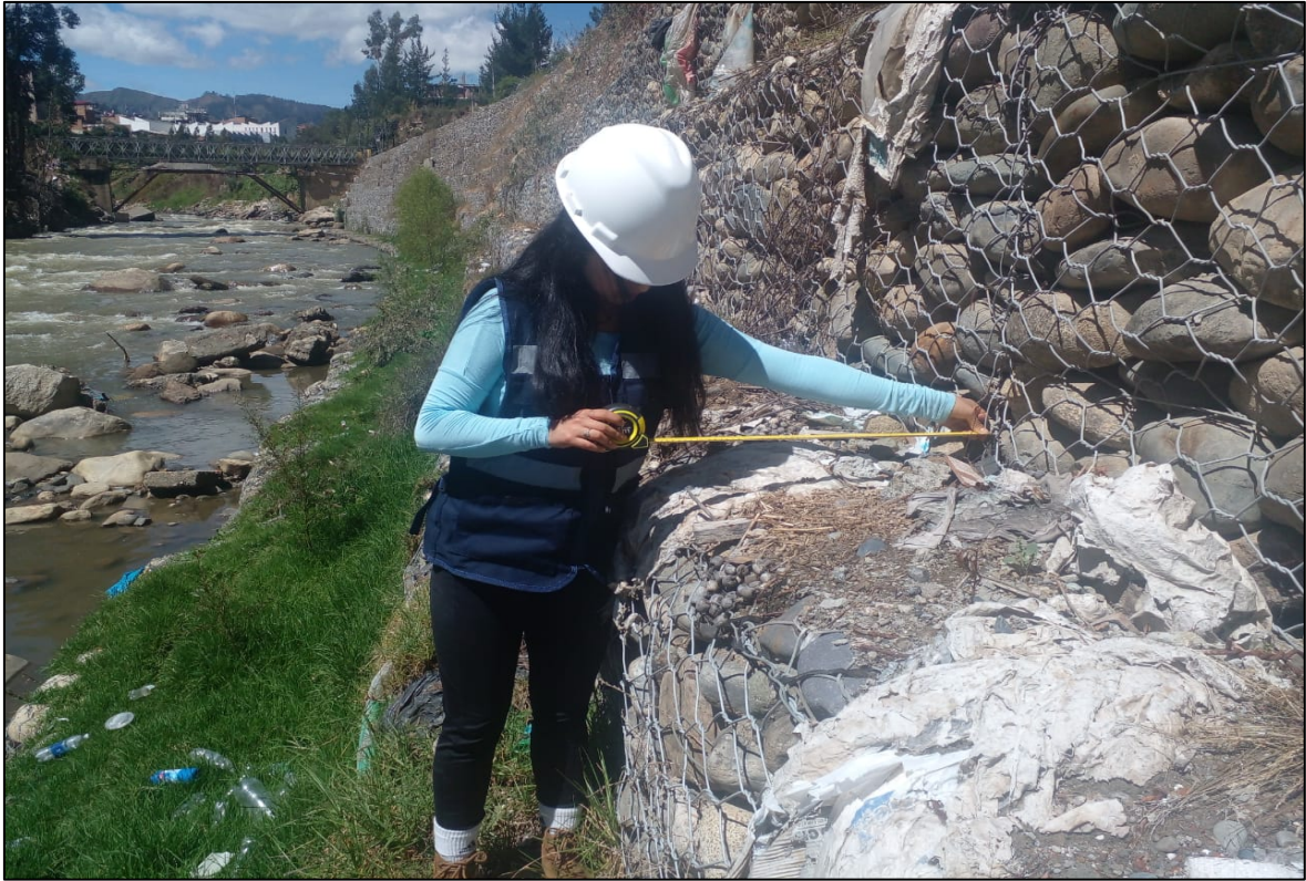
Figura 20: Medidas del ancho del muro de gaviones.
