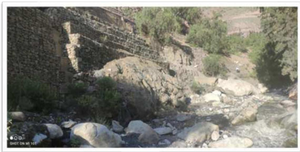
**Figura n°6:** Muro de gavion en buen estado en el tramo 0+000 a 0+150 km donde se observa vegetacion en la parte baja.
