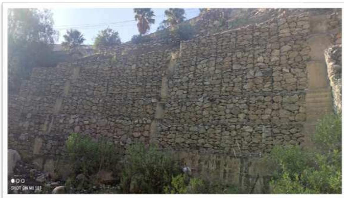
**Figura n°7:** Se observa empuje de terreno y malla rota. Donde el muro de gavion a colapsado dejando a la zona vulnerable a los desbordes del rio en el tramo 0+350 al 0+400 km.
