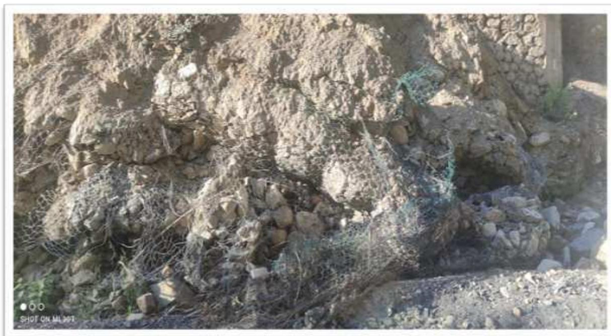
**Figura n°8:** Se Observa en la siguiente imagen presencia de vegetacion en los bordes del muro de gavion en el tramo 0+000 al 0+150 km .
