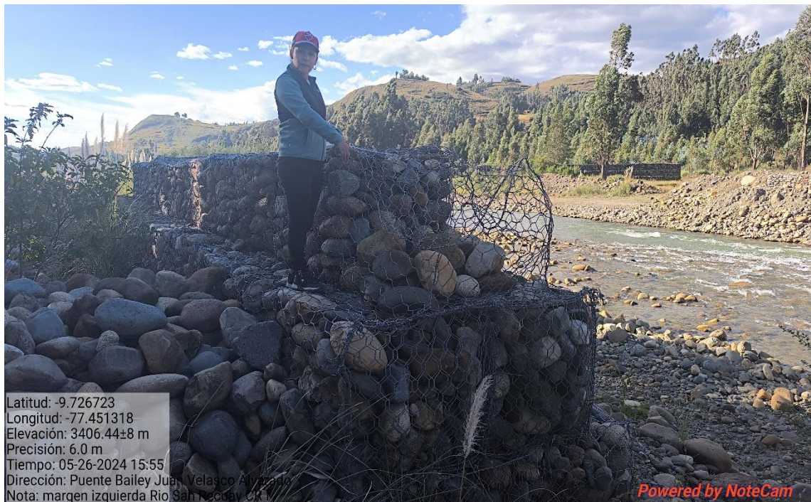
Figura N° 12: Muro de gavión N° 01, Progreciva 0+008m
