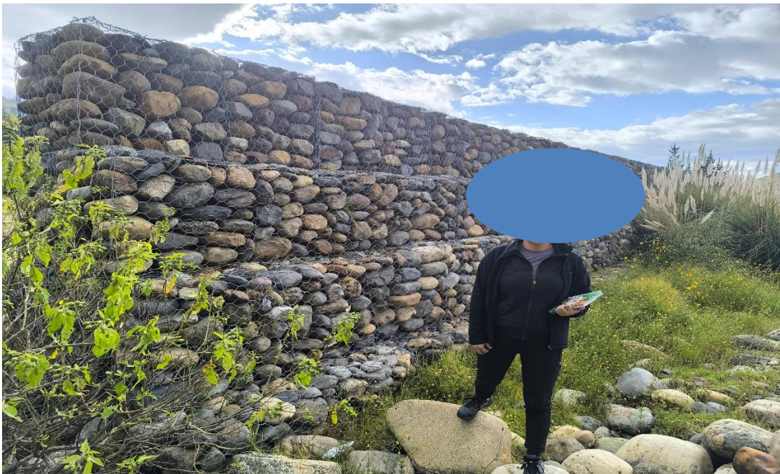
Figura N° 36: Muro de gavion N° 05 , Progresiva 0+430
