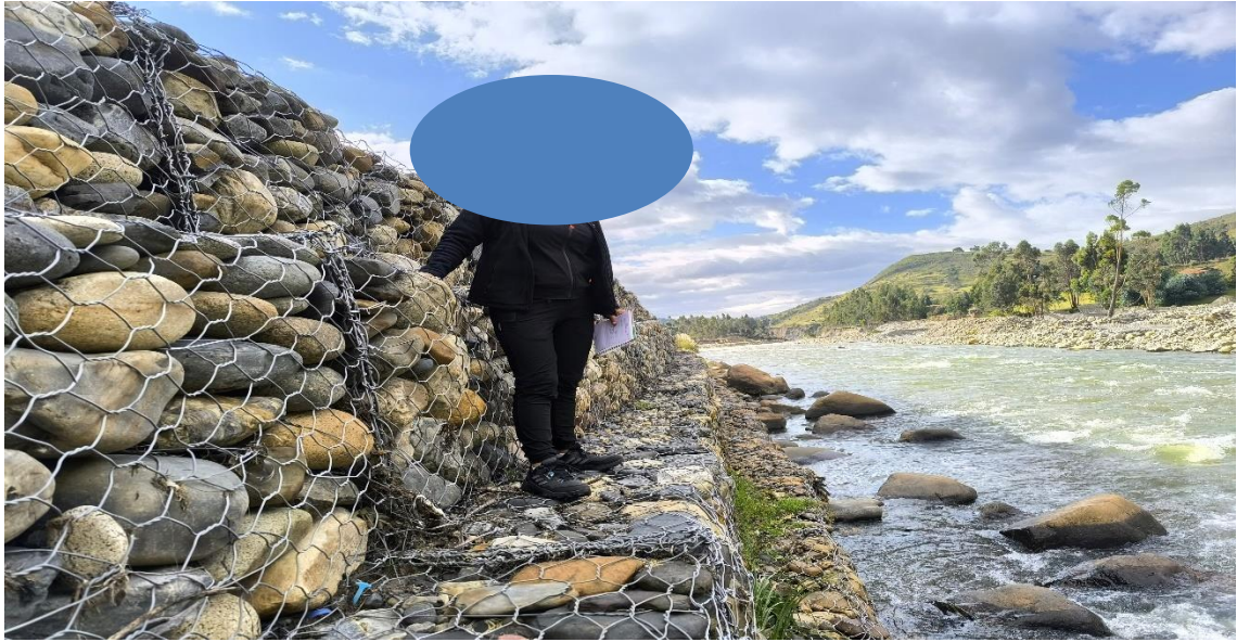
Figura N° 27: Recorrido de muro de gavión, N° 04, verificando las componentes del gavión.
