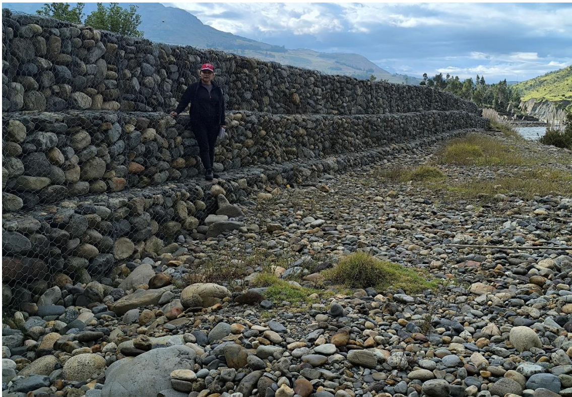
Figura N° 30: Muro de gavión N° 05, Progresiva 0+430 a 0+540m
