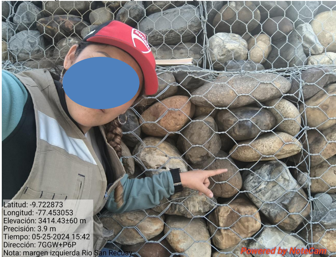
Figura N° 19: Muro de gavión N° 03, sentido de tejido de malla (Horizontal)
