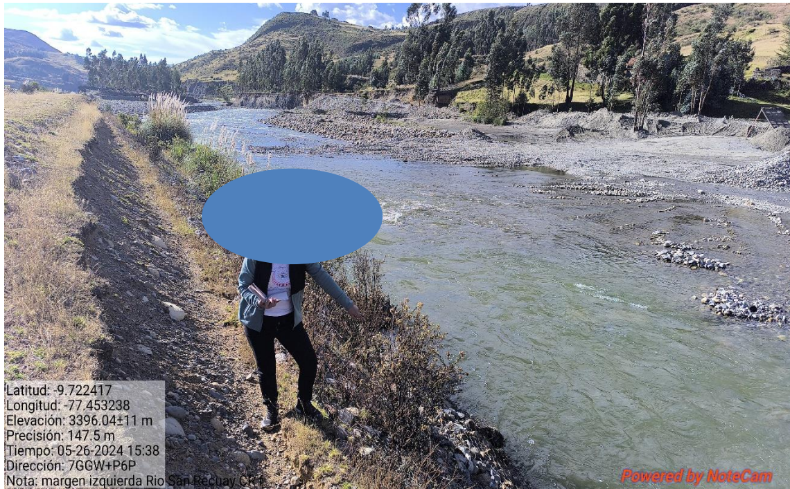
Figura N° 37: Muro de gavion tipo colchon, Progresiva 0+540 a 0+640
