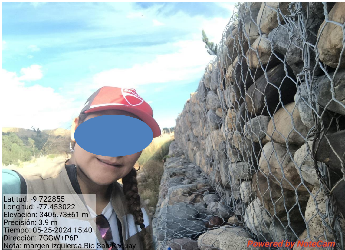
Figura N° 42: Muro de gavion N° 06, Progresiva 0+875 a 1+005m
