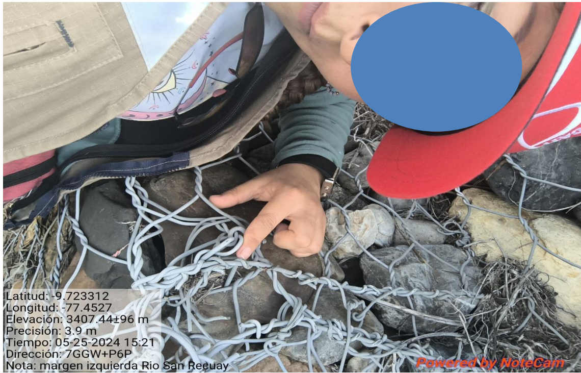
Figura N° 33: Identificación de tipo de revestimiento de la malla del muro de gavión N° 05
