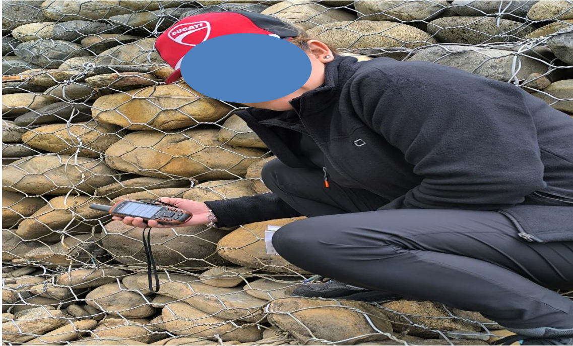
Figura N° 35: Toma de coordenadas del muro de gavion N° 05
