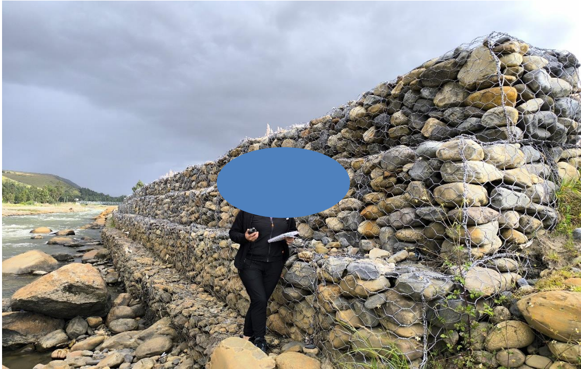
Figura N° 29: Toma de coordenadas del muro de gavión N° 04
