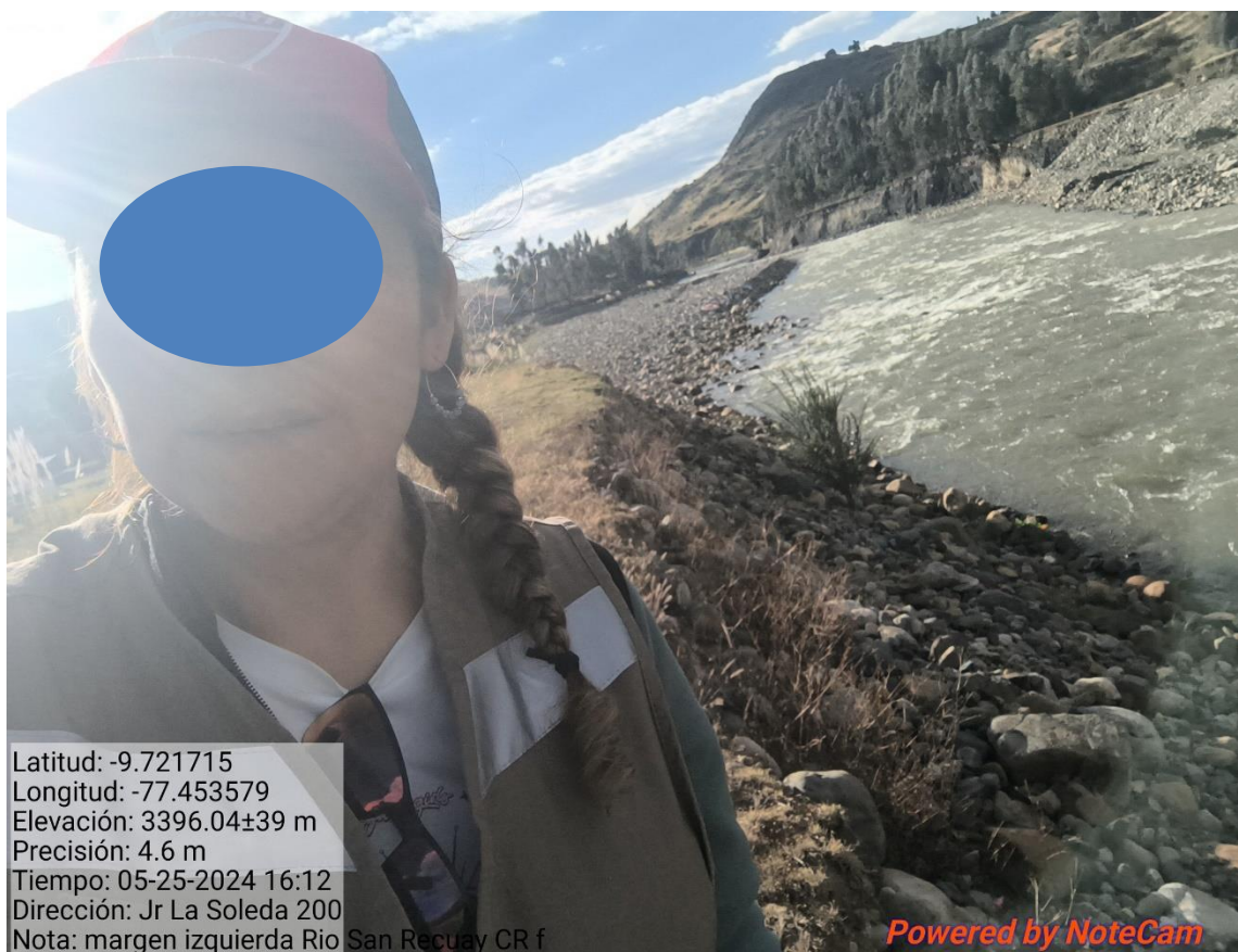
Figura N° 40: Zona N° 05, no cuenta con muro de gavion.
