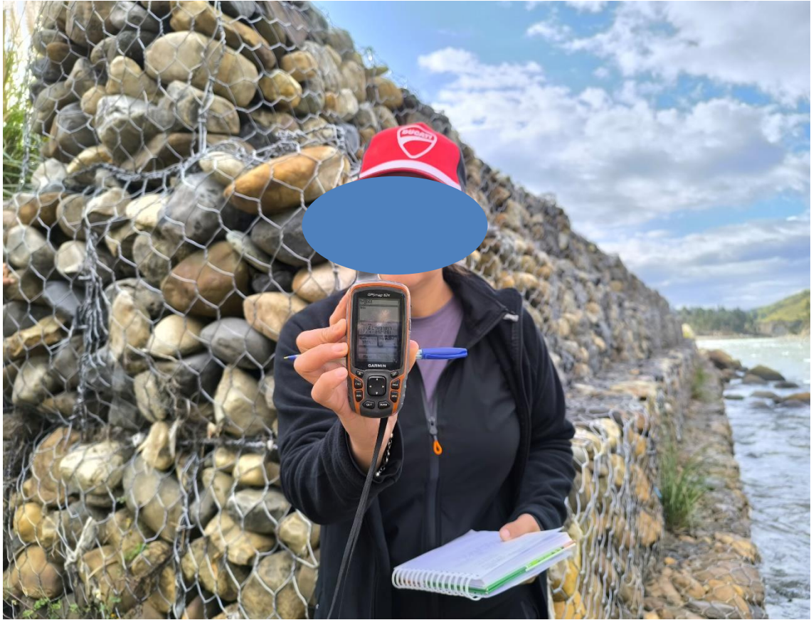
Figura N° 25: Toma de coordenadas del muro de gavión N° 04
