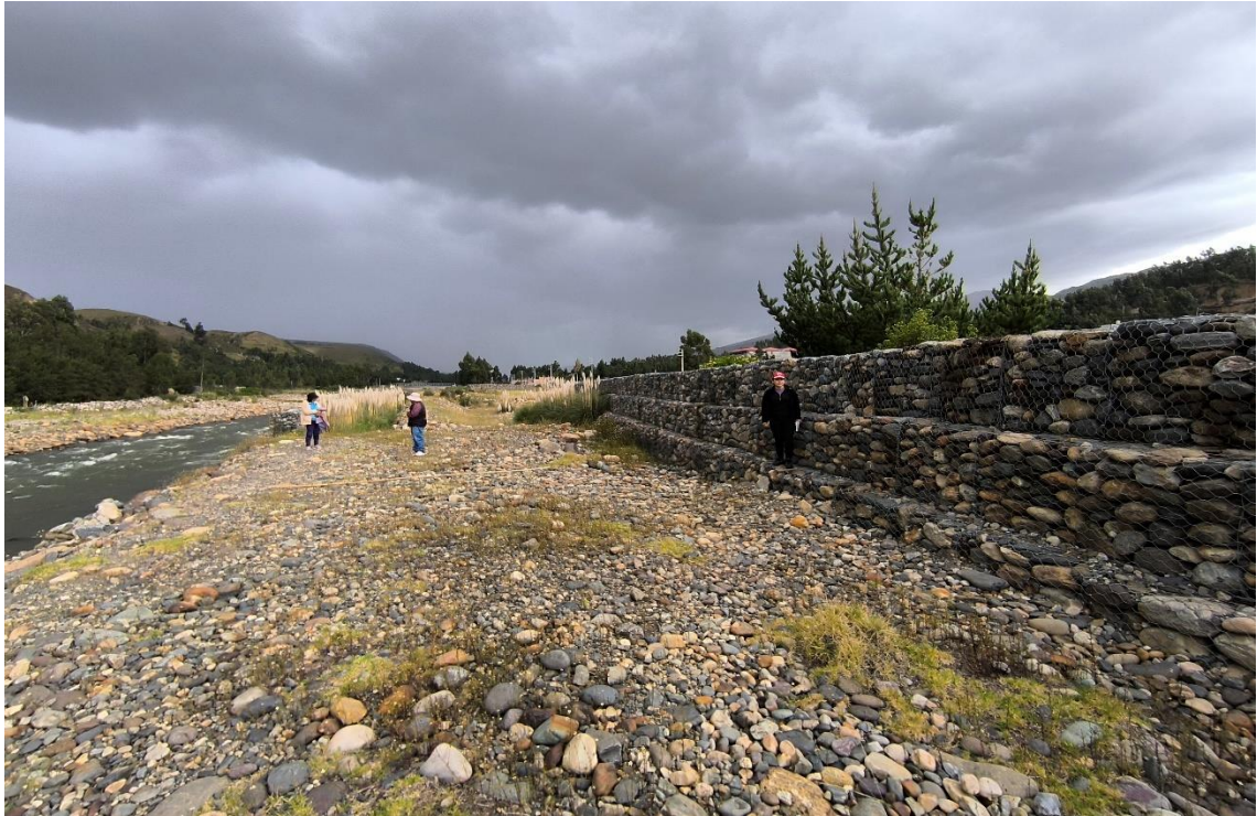
Figura N° 31: Recorrido muro de gavión N° 05
