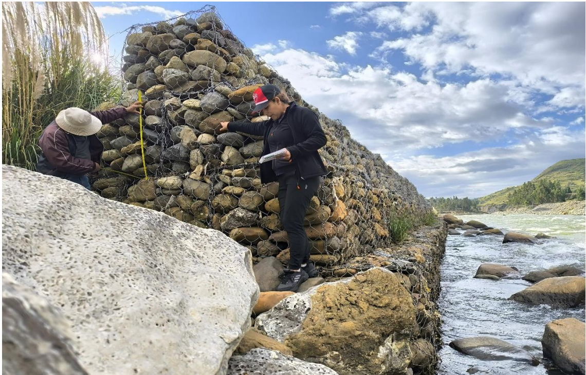
Figura N° 23: Muro de gavión N° 04, progresiva 0+430 a 0+470m
