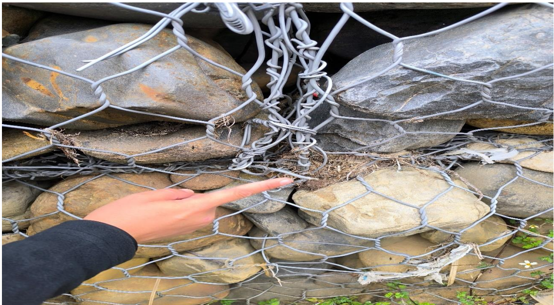
Figura N° 26: Identificación de malla revestida con PVC del muro de gavión N° 04
