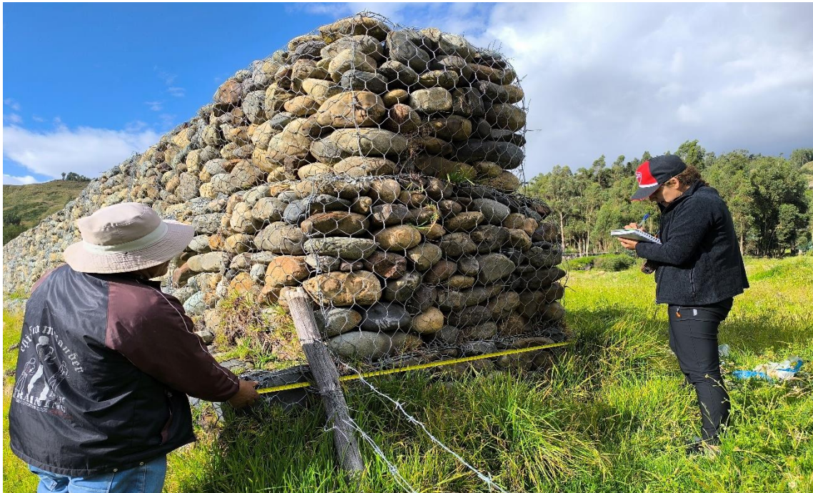
Figura N° 20: Medida de dimensiones del muro de gavión N° 03
