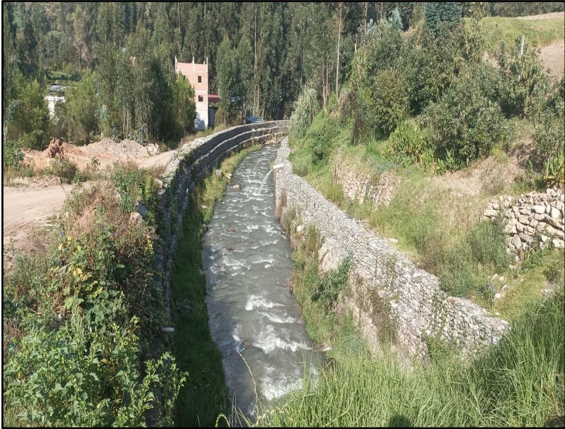
Figura 33: Afectación vegetal al muro de gaviones Fuente: Elaboración del autor-2024
