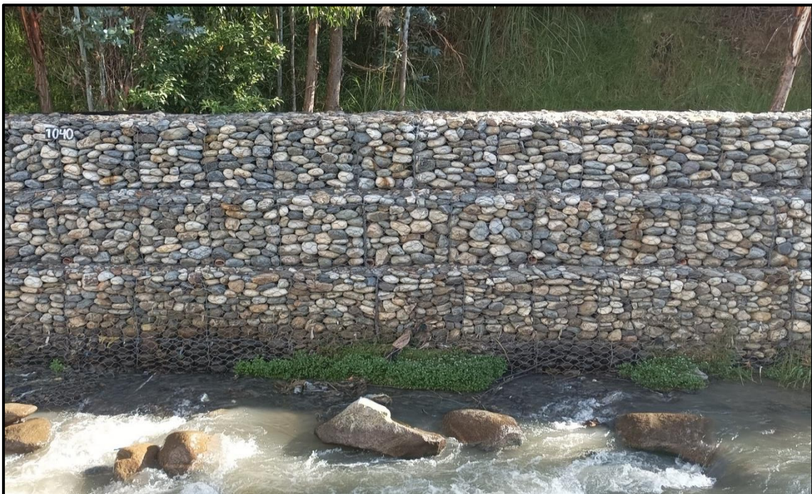
Figura 33: Afectación vegetal al muro de gaviones Fuente: Elaboración del autor-2024
