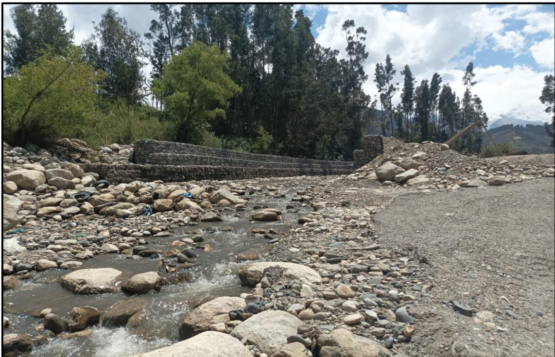
Figura 28: Obstaculización con agregados a la salida de la defensa ribereña Fuente: Elaboración del autor-2024
