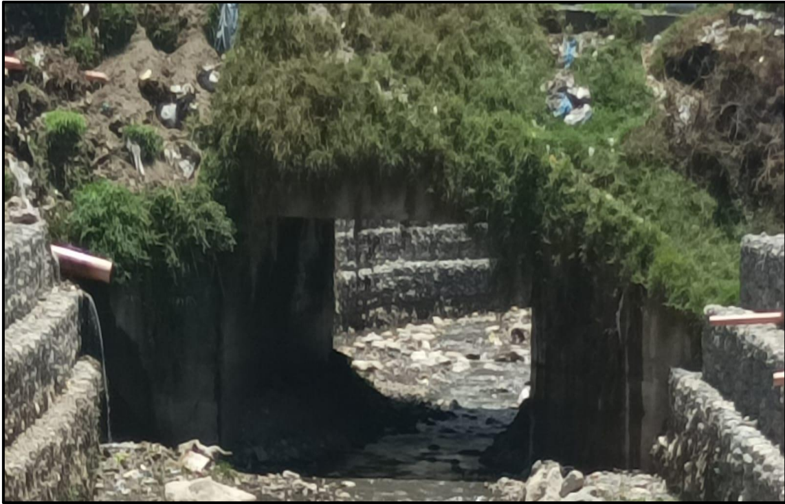
Figura 27: Botadero de desmonte contra el muro de gaviones Fuente: Elaboración de autor-2024
