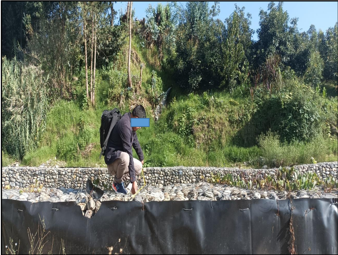
Figura 31: Medición de los muros de gaviones Fuente: Elaboración del autor-2024
