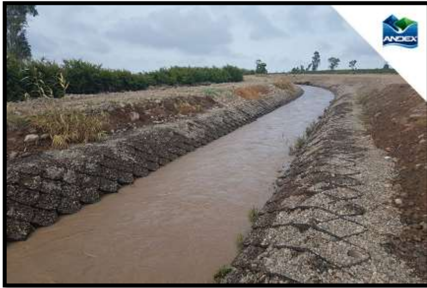
Figura N° 03: Enrocado con gleoceldas
