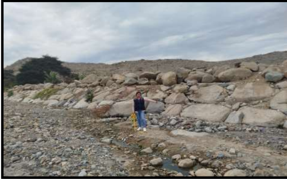
Figura N° 11: Identificación de talud en reserva ribereña
