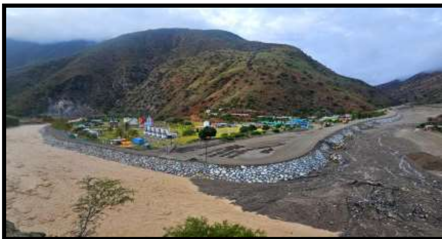
Figura N° 01: Evaluación del enrocado
