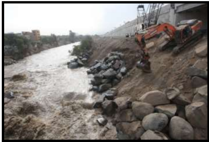
Figura N° 08: Evaluación del enrocado
