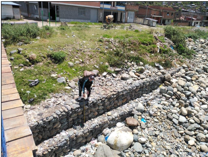
Fotografía 06: Inspección del estado del muro de gaviones por parte del tesista.
