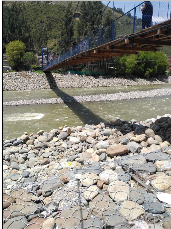
Fotografía 05: Vista parcial del muro de gaviones y al fondo el puente de acceso al Centro Poblado de Quechcap.
