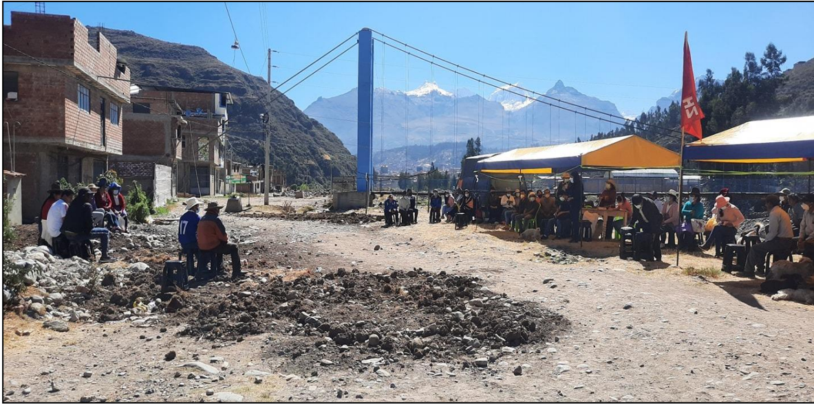
Fotografía 03: Vista de la proximidad de las viviendas a la orilla del río Santa
