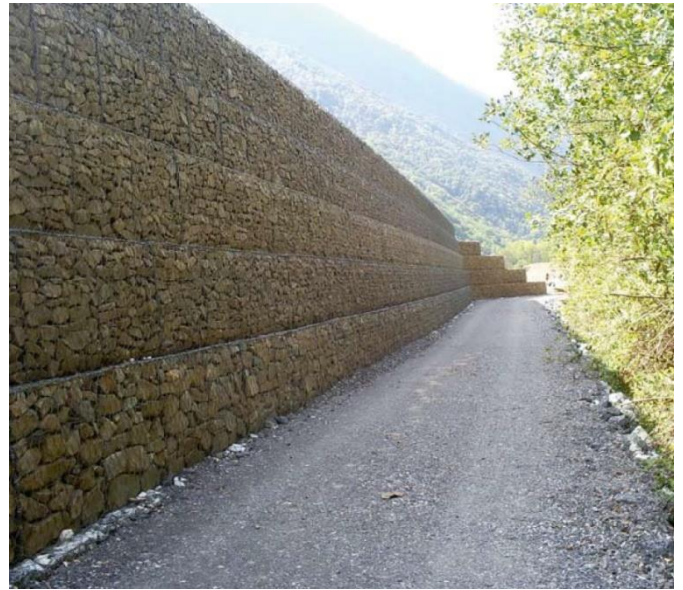
Figura 23. Muro de contención en carretera. Fuente: (A Bianchini, 2017)
