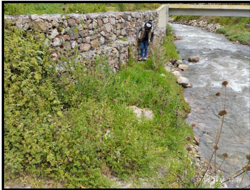
Fotografía 01: Progresiva 0+000 – 0+0.60, se tomó como punto de partida el Puente Carash, podemos observar que, los gaviones, se encuentran sin mayores problemas en su estructura, no se identificó la pantalla antisocavante.
