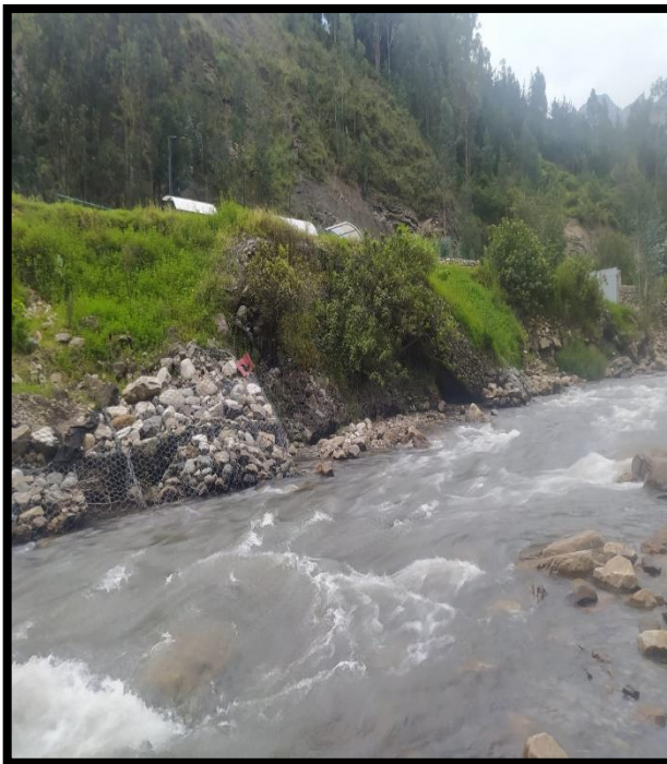
Fotografía 06 - 07: Progresiva 0+180 – 0+200, se puede observar la falla de la estructura en su totalidad, producto de la socavación y de la crecida del tirante de agua en temporada de lluvias, presencia de rocas y residuos, el río no tiene un cause definido.
