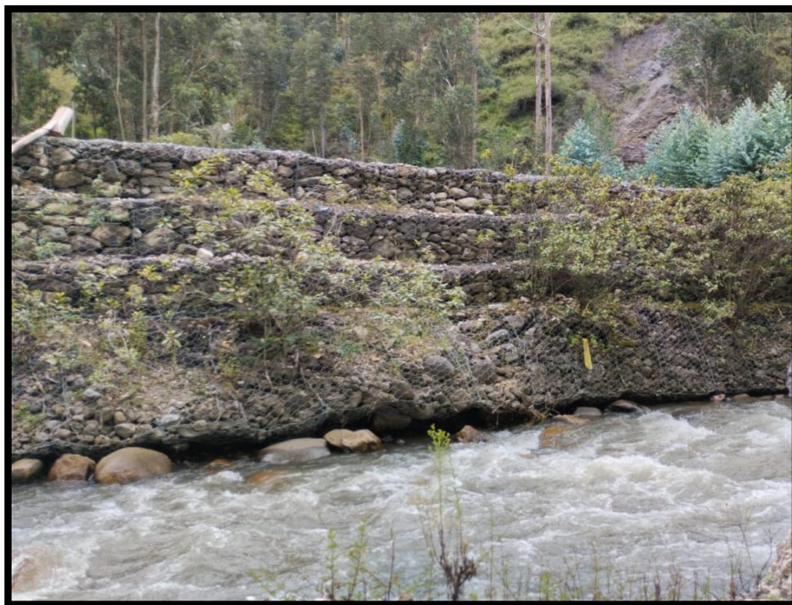
Fotografía 03: Progresiva 0+000 – 0+0.60, la estructura no presenta mayores daños, pese a no contar con la pantalla antisocavante, existe presencia de socavación, se evidencia presencia de vegetación y rocas sueltas, así como residuos sólidos en las orillas.
