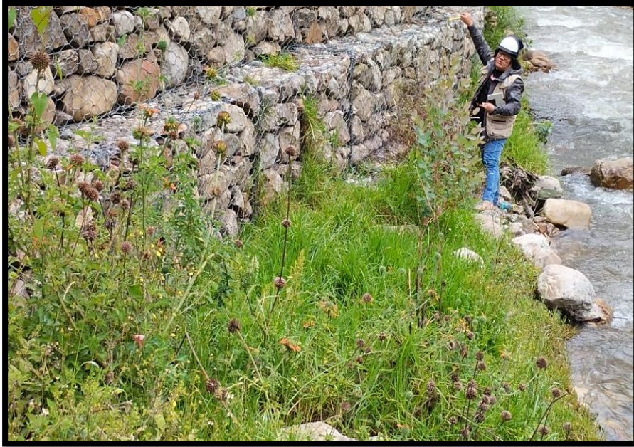
Fotografía 03: Progresiva 0+000 – 0+0.60, la estructura no presenta mayores daños, pese a no contar con la pantalla antisocavante, existe presencia de socavación, se evidencia presencia de vegetación y rocas sueltas, así como residuos sólidos en las orillas.
