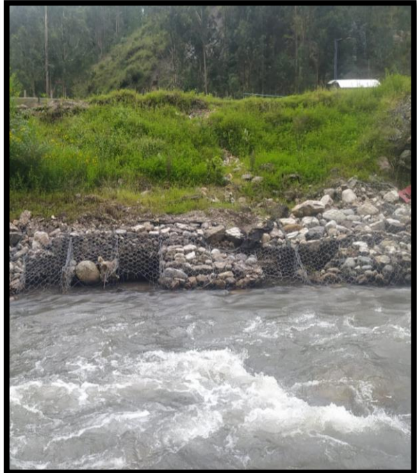
Fotografía 13 - 14: Progresiva 0+280 – 0+300, se puede observar las estructuras de protección totalmente inoperantes lo largo del margen izquierdo del río, poniendo en peligro terrenos de cultivo, y viviendas aledañas.
