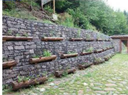
Figura 1. Estructura con gaviones. Fuente: <http://www.solucionesespeciales.net/MedioAmbiente/Gaviones/Gaviones.aspx>
