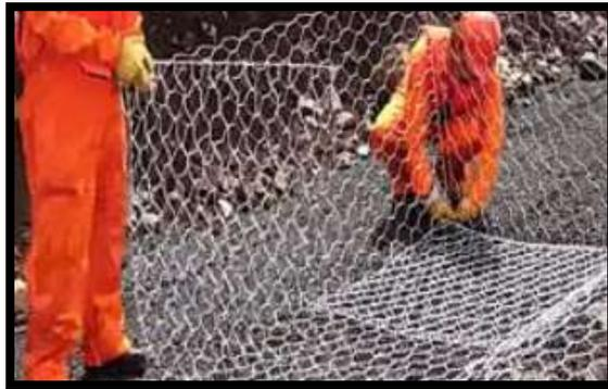
**Figura 7:** Colocación malla en gavion
