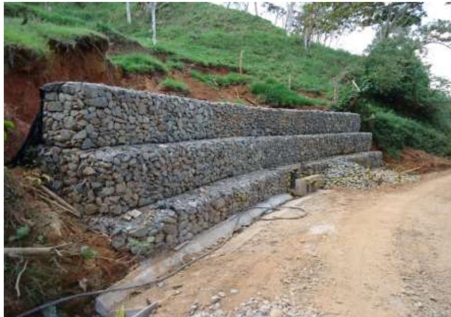
**Figura 2:** Muro de gaviones
