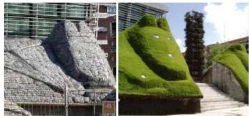
Figura 24. Antes (izquierda) y después (derecha) de una estructura construida con gaviones. Fuente: (A Bianchini, 2017)
