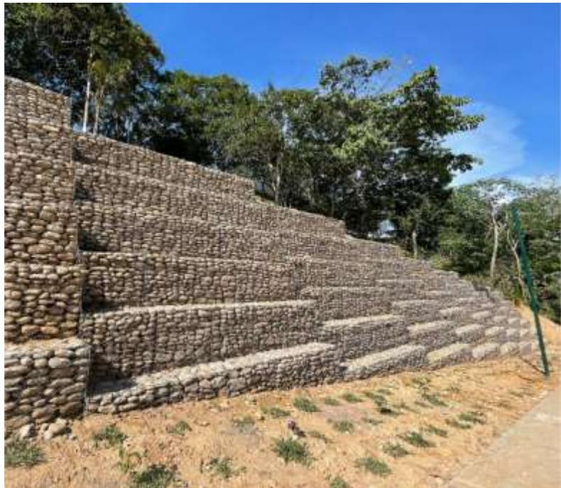
**Figura 4:** Muro de gaviones tipo caja
