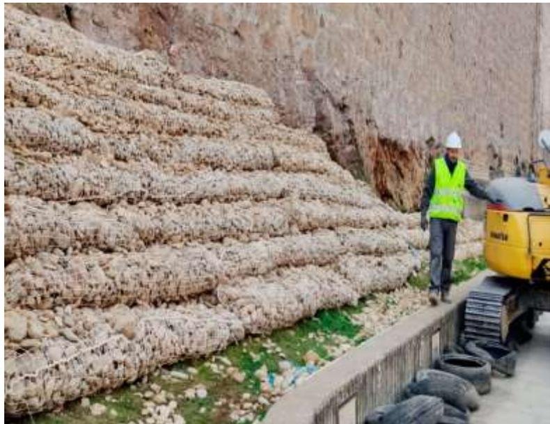
**Figura 3:** Muro de gaviones tipo saco
