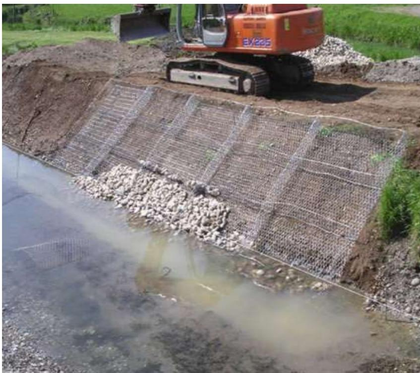
**Figura 5:** Muro de gaviones tipo colchón
