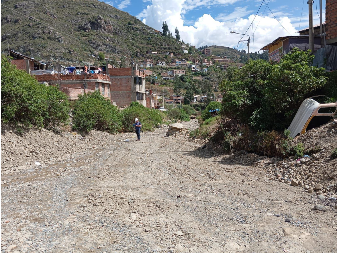
Figura N° 16: Vista de la evaluación del muro de gaviones en el rio seco
