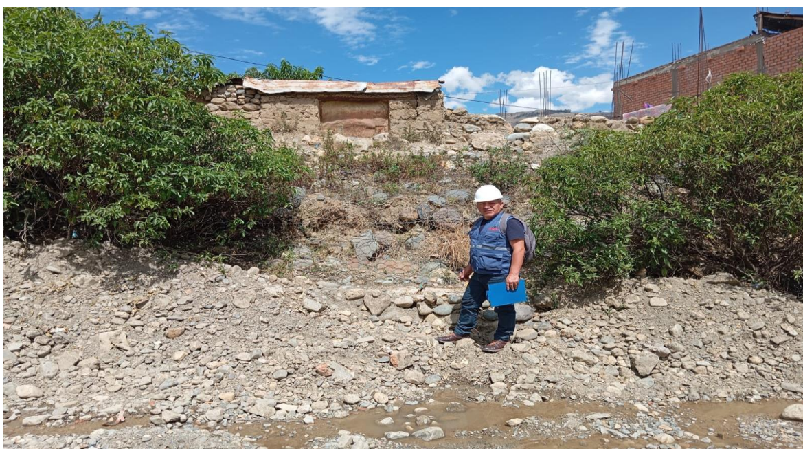
Figura N° 15: Evaluación del muro de gavión el tramo 0+000 hasta 0+100 en el margen derecho
