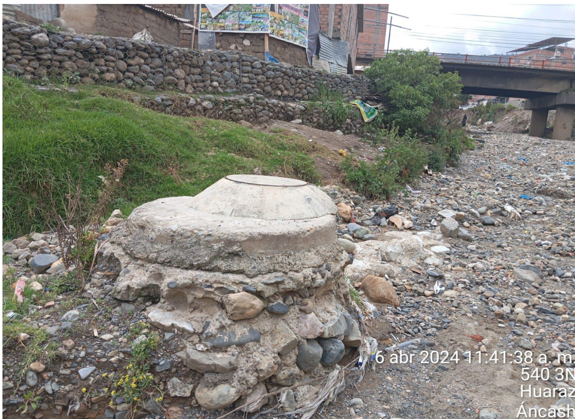
Figura N° 14: Vista del muro de gaviones en el margen derecho
