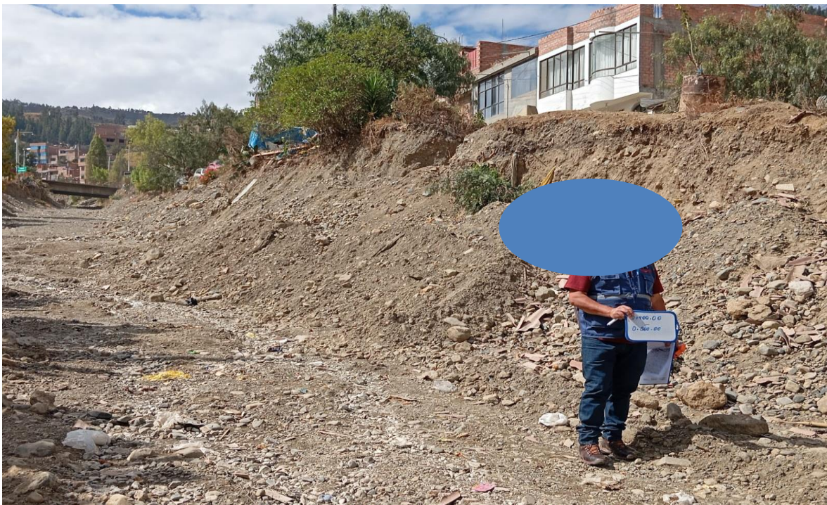
Figura N° 27: Situación actual del tramo 0+400 hasta 0+500 del margen izquierdo
