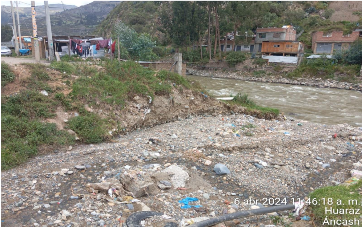
Figura N° 22: Situación actual del tramo 0+100 hasta 0+200 del margen izquierdo
