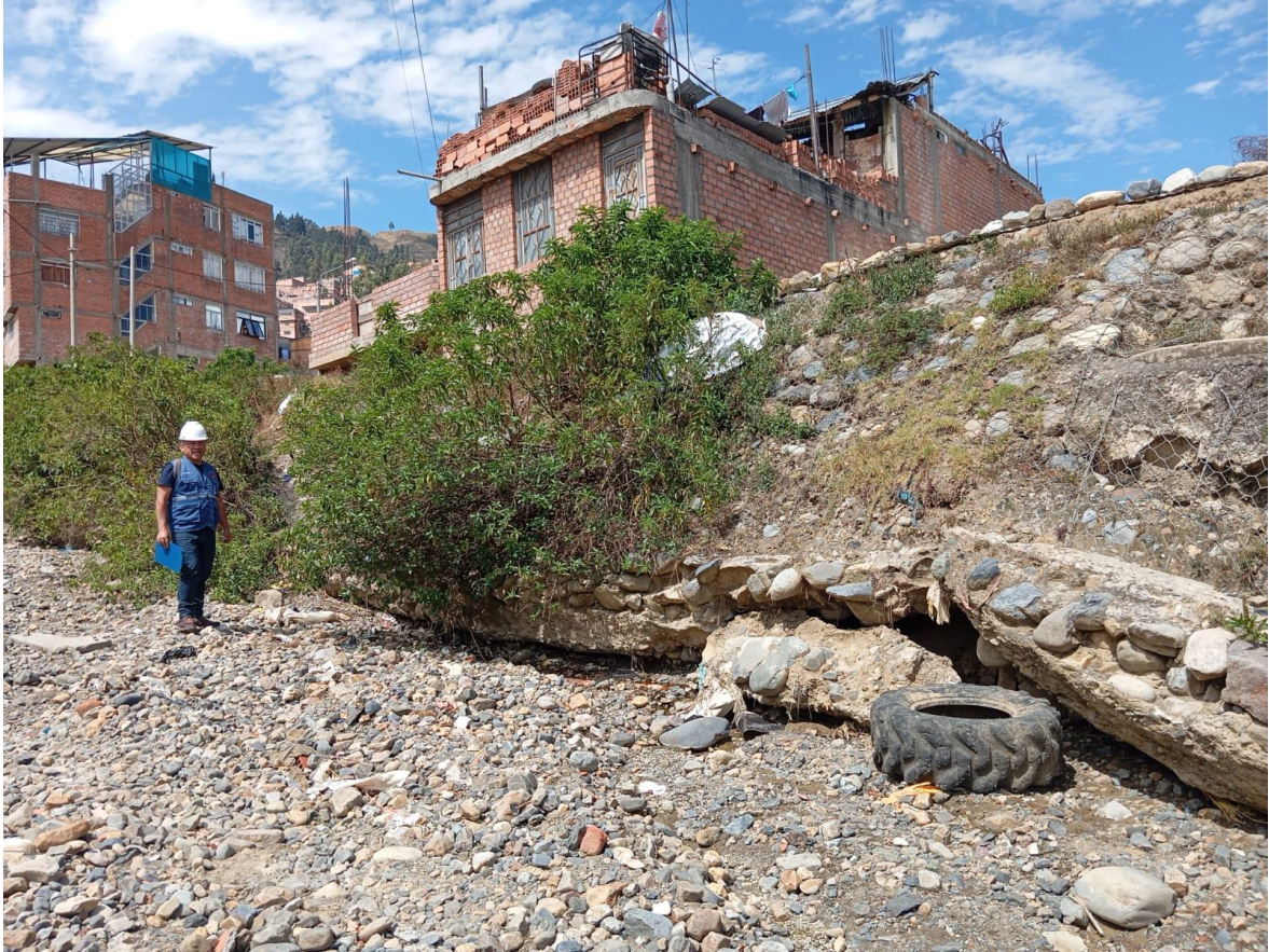
Figura N° 18: Acumulación de arbustos en el margen izquierdo de la defensa ribereña
