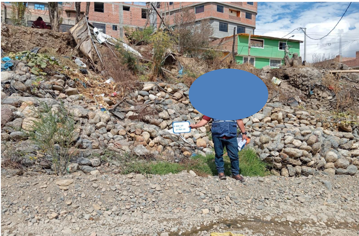
Figura N° 31: Situación actual del tramo 0+600 hasta 0+700 del margen izquierdo
