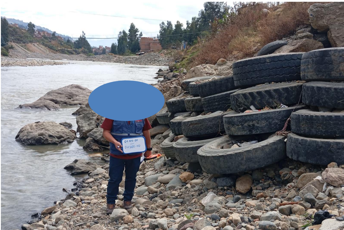
Figura N° 21: Estado actual en el tramo 0+100 hasta 0+200 del margen derecho
