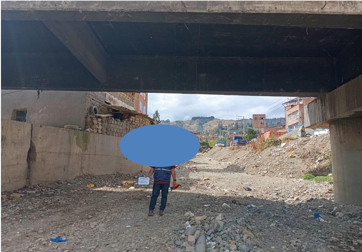
Figura N° 24: Situación actual del tramo 0+200 hasta 0+300 del margen izquierdo
