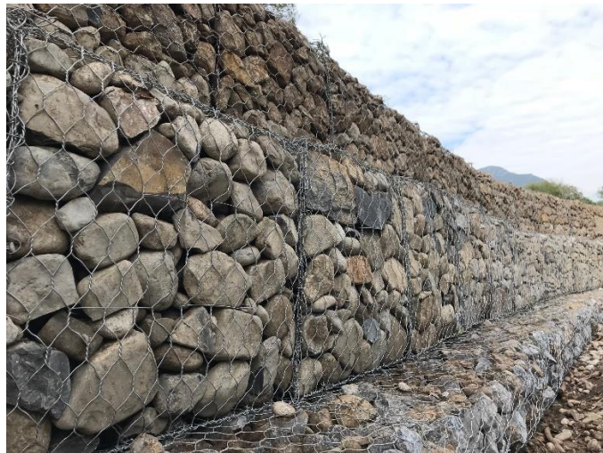
Figura N° 1: Muro de gavión
