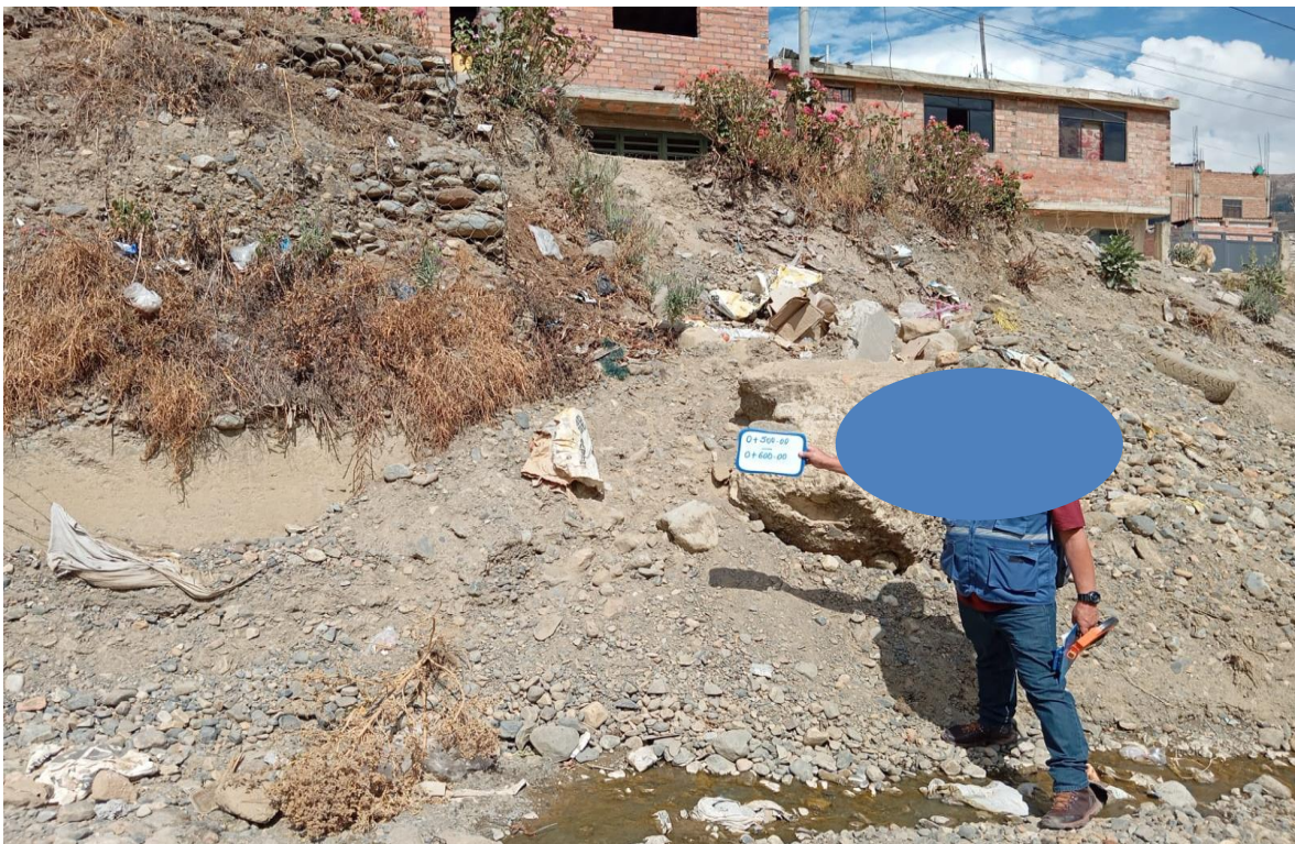
Figura N° 29: Situación actual del tramo 0+500 hasta 0+600 del margen izquierdo
