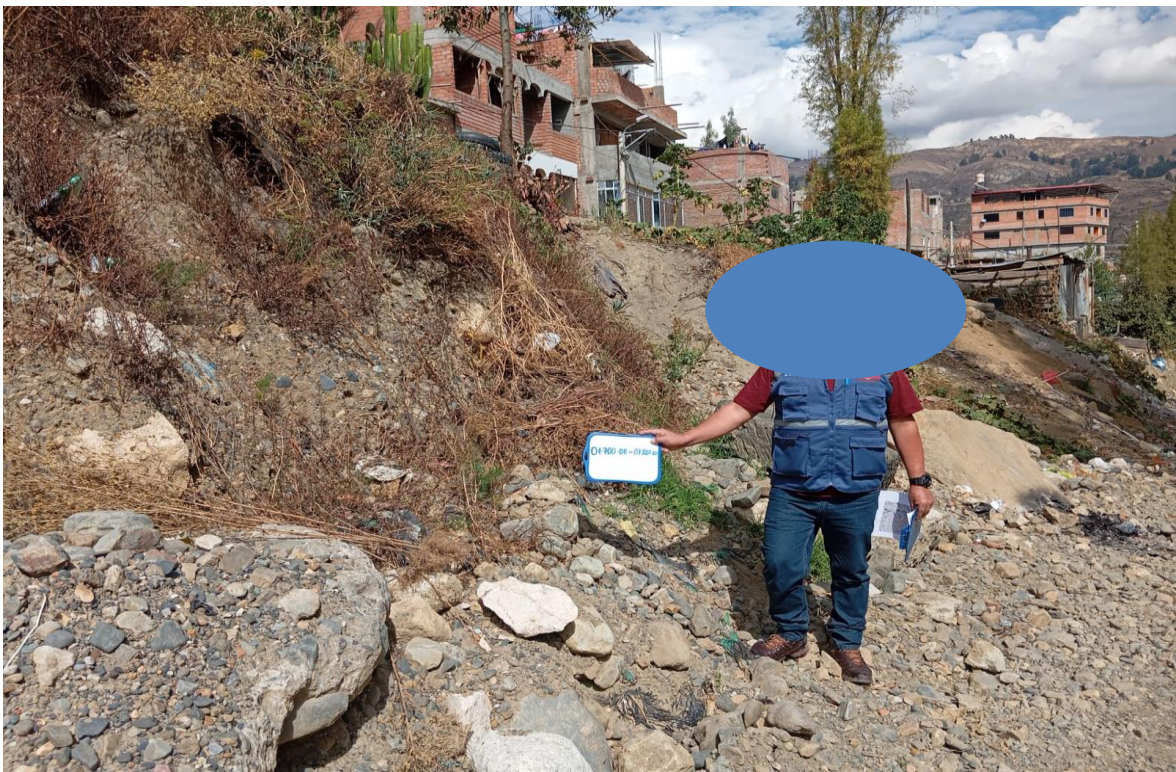
Figura N° 33: Situación actual del tramo 0+700 hasta 0+800 del margen izquierdo
