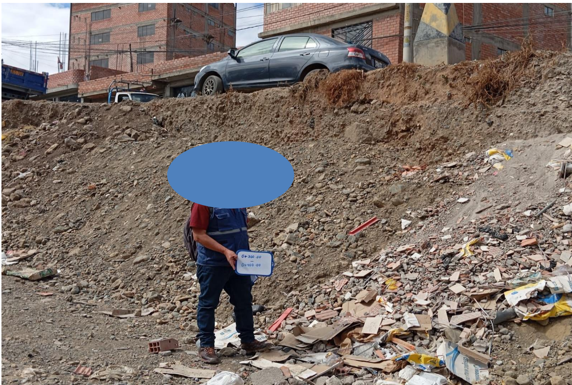
Figura N° 25: Situación actual del tramo 0+300 hasta 0+400 del margen izquierdo
