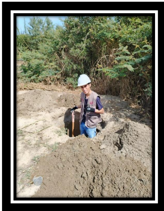
Figura 5: Realizando la excavación de la calicata para el estudio de suelo
