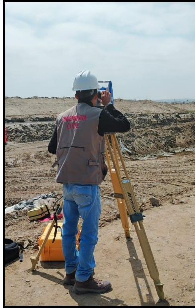
Figura 6: Realizando la nivelación con el equipo topográfico
