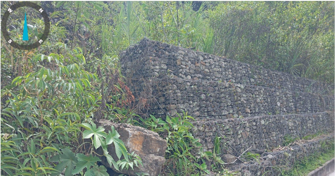
Figura 15: Inicio de muro de gaviones Fuente: Evidencia de Campo
