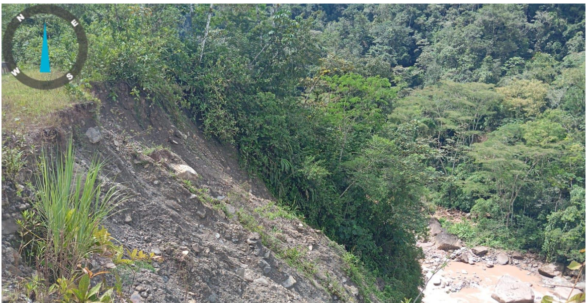
Figura 22: Rio Nueva Requena toma 02 Fuente: Evidencia de campo
