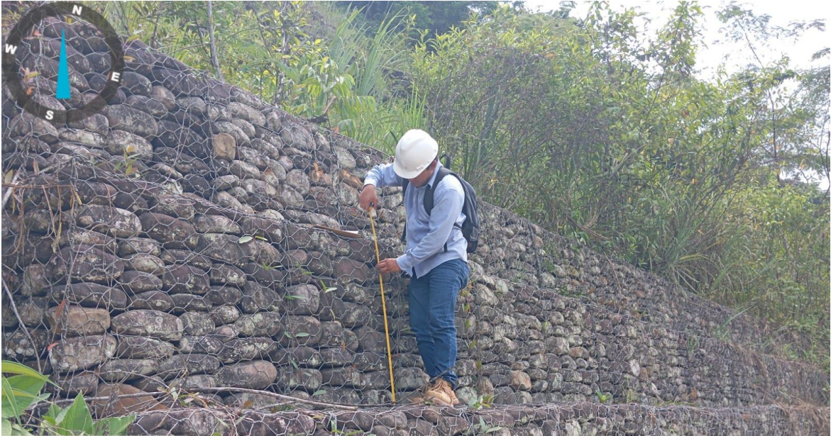
Figura 14: Medición de gavión Fuente: Evidencia de Campo
