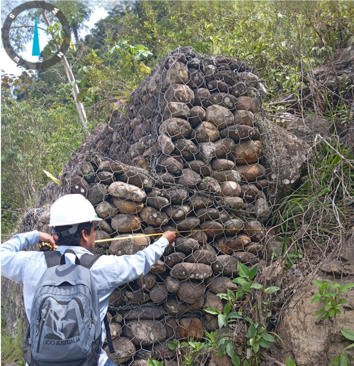
Figura 18: Medición de ancho de gavión Fuente: Evidencia de campo
