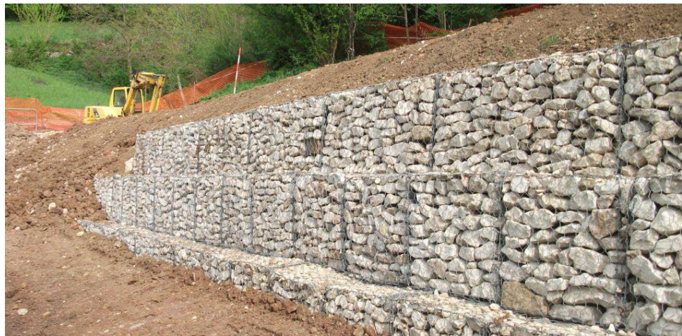
Figura 1: Muro de Gavión
