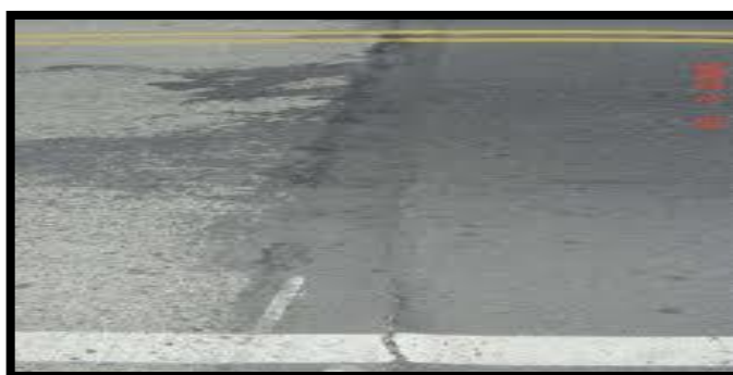
Gráfico N° 15: Fisura transversal.
