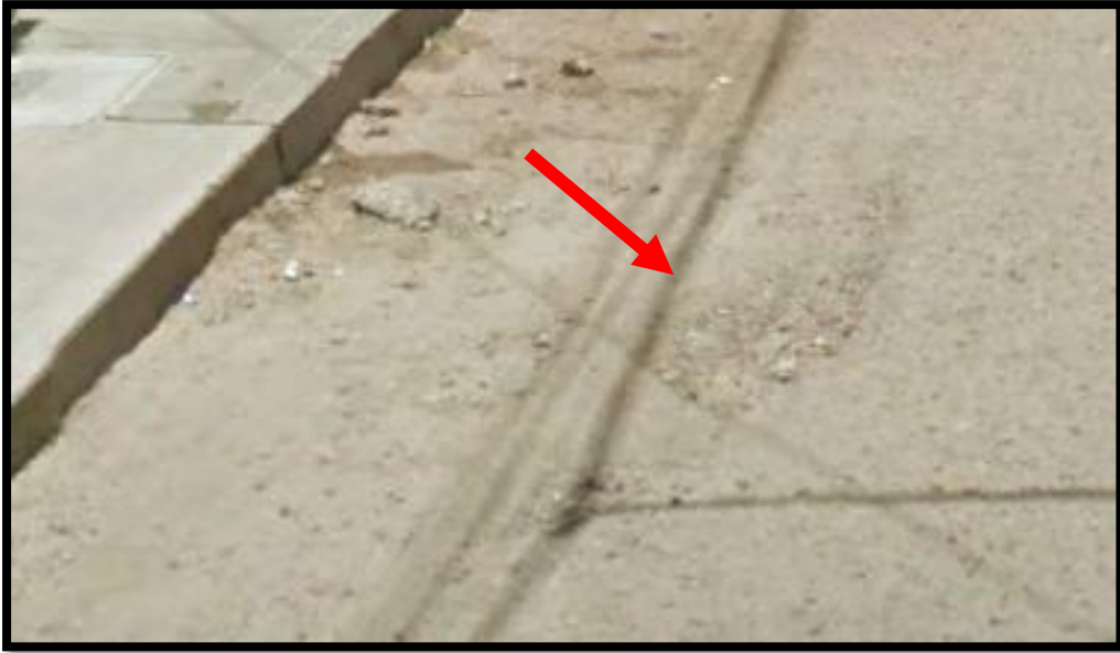
Grafico N° 53: Presentación de baches de media y alta severidad.
