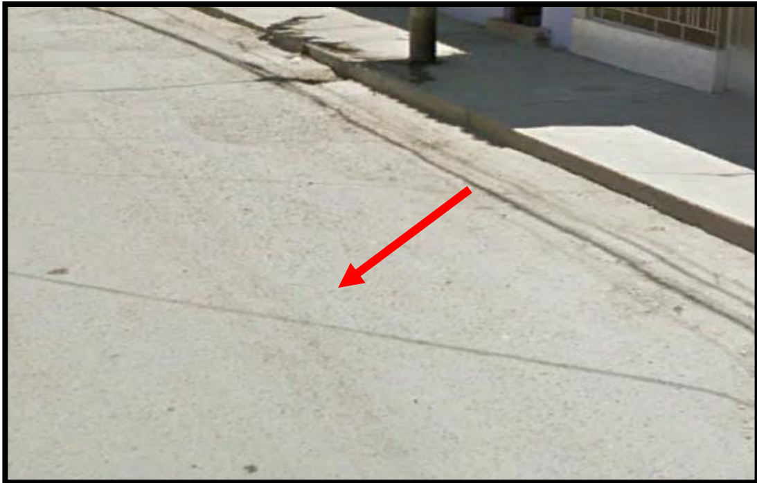
Gráfico N° 34: Presentación de ahuellamiento de severidad media.
