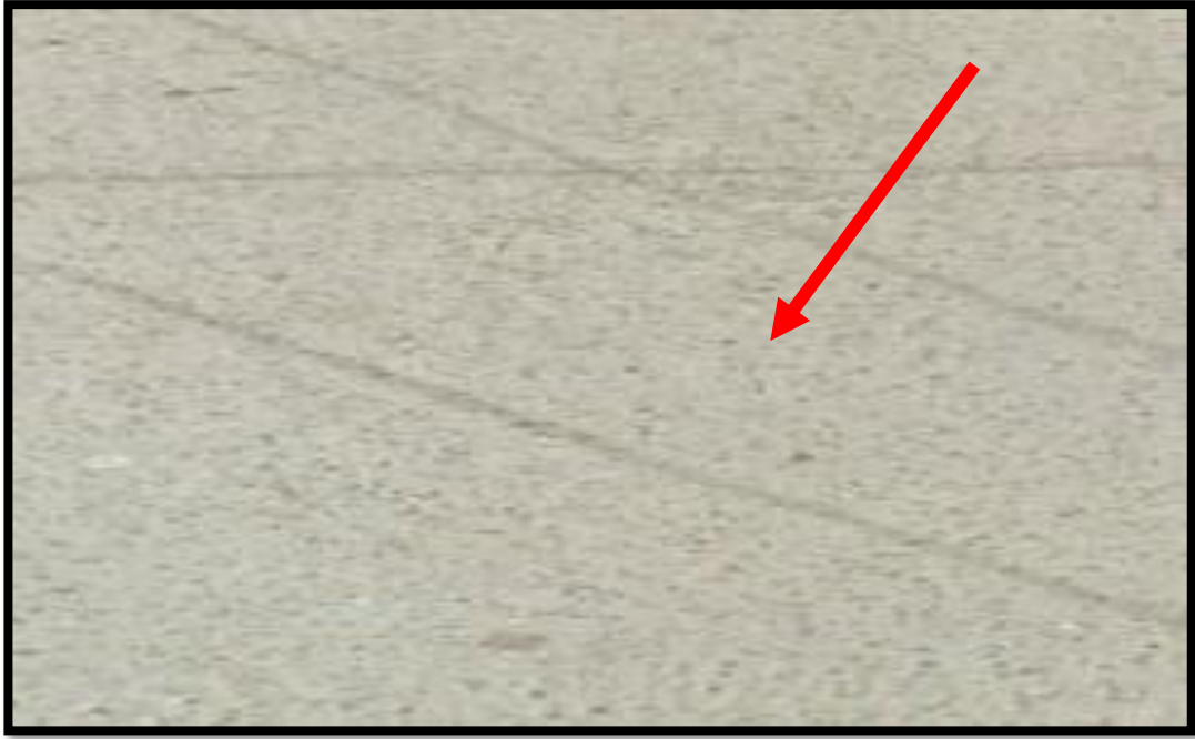
Grafico N° 38: Presentación de peladura por intemperismo de severidad media. Fuente: Propia.
