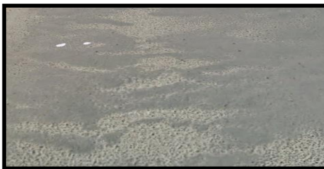
Gráfico N° 17: Abultamientos y hundimientos.
