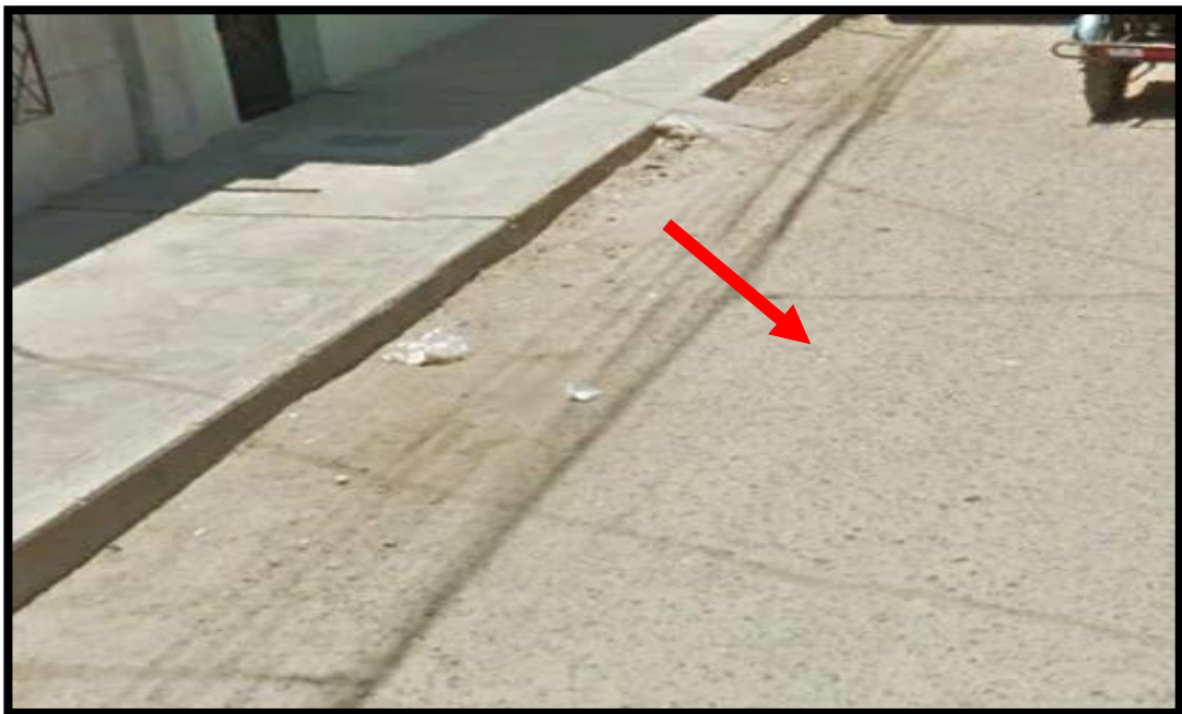
Grafico N° 48: Presentación de peladura por intemperismo de media severidad.
