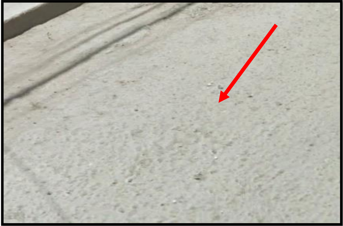
Grafico N° 35: Presentación de peladura por intemperismo de severidad media.
