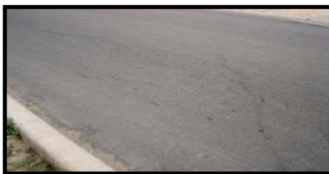
Gráfico N° 16: Fisura parabólica o por deslizamiento.
