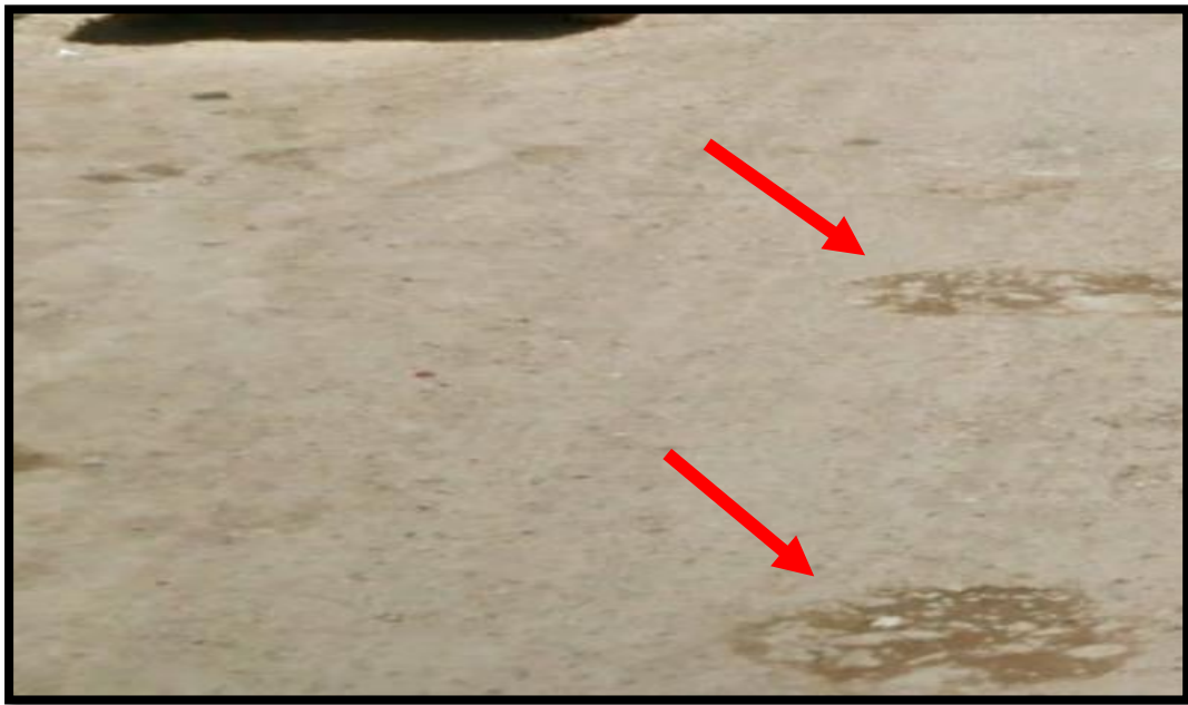
Grafico N° 47: Presentación de baches de baja y media severidad.
